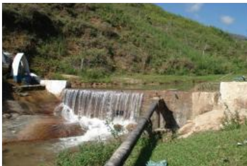
Foto 01 – Captação em afluente do Rio Capitão Mor – Rio da Santa (Fonte: Plano de Saneamento de Arapeí - SABESP)
