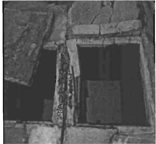
F4:80 – Lajes de Inspeção na Laje do Reservatório da ETA 1
