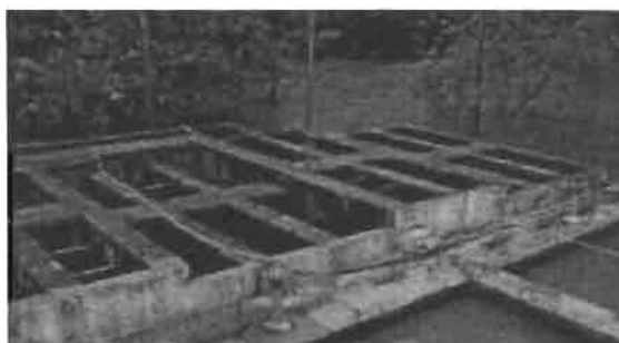
F4:52 – Vista Geral da Unidade de Floculação Hidráulica Implantada na ETA 1 – Floculador 3
