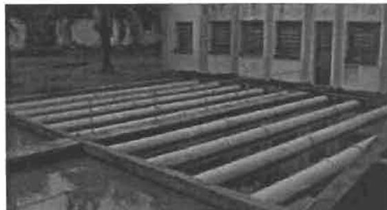
F4:59 – Vista Geral dos Decantadores da ETA 2 em Operação – Decantadores 1 e 2 (Trecho Final Trabalhando como Laminar)
