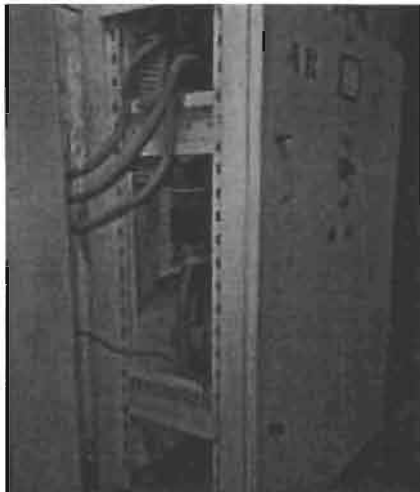
F4:93 – Chave de Partida Tipo Compensadora
