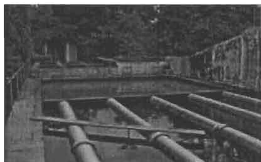
F4:58 – Vista Geral dos Decantadores da ETA 1 em Operação – Decantadores 1 e 2 (Trecho Final Trabalhando como Laminar)
