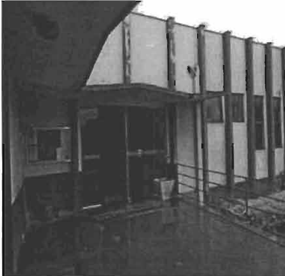
F7:14 – Fachada do Prédio do Atendimento Personalizado
