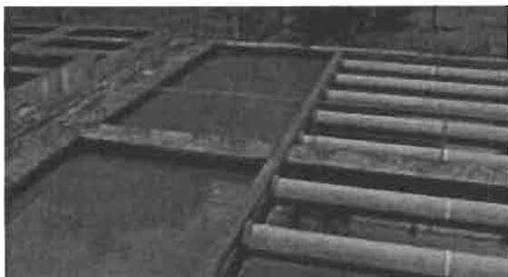
F4:58 – Vista Geral dos Decantadores da ETA 1 em Operação – Decantadores 1 e 2 (Trecho Final Trabalhando como Laminar)
