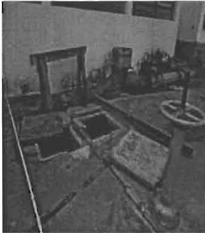
F4:80 – Lajes de Inspeção na Laje do Reservatório da ETA 1
