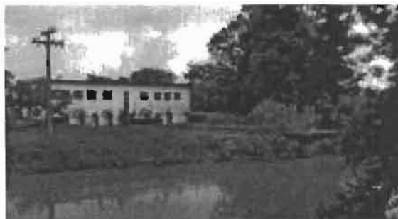
F4:20 – Vista Geral da Captação de Água Bruta no Manancial Rio Baguaçu – ETA 2
