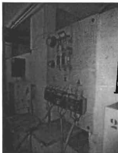
F4:98 – Chave de Partida e EAT de Transferência para a ETA 2
