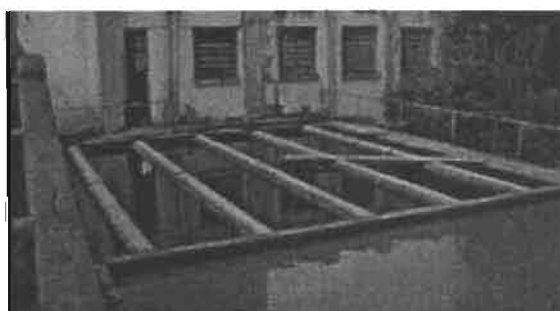
F4:59 – Vista Geral dos Decantadores da ETA 2 em Operação – Decantadores 1 e 2 (Trecho Final Trabalhando como Laminar)
