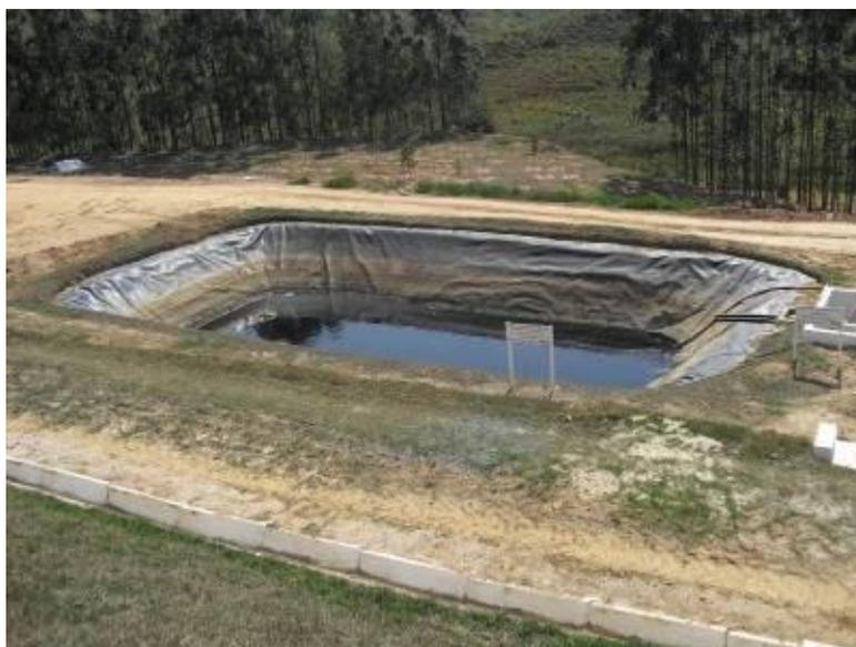
**Foto 11 - Tanque Reservatório de Líquido Percolado – Chorume.**
