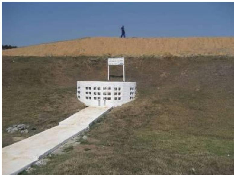
**Foto 10 - Poço de Captação de Líquido Percolado – Chorume.**
