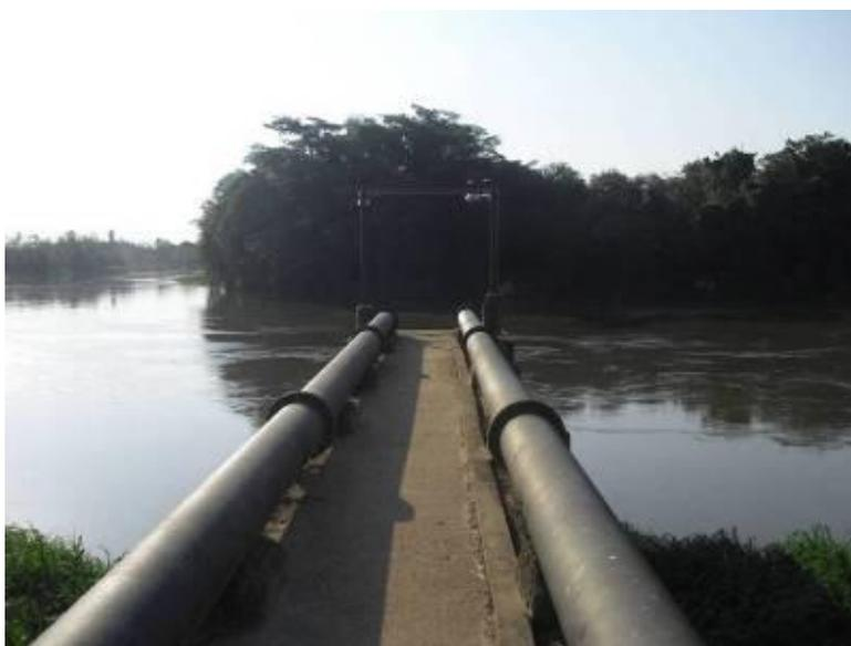
Foto 01 - Captação de Água Bruta no Rio Paraíba do Sul, a jusante da foz do Ribeirão da Chácara.
