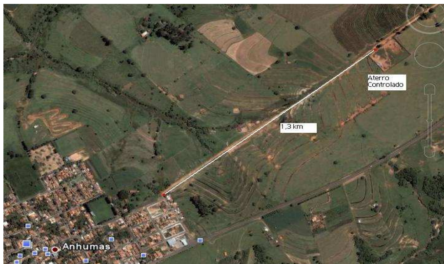
FIGURA 06- Aterro controlado em valas.
