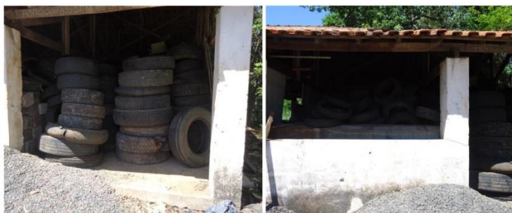
Local de armazenamento.
