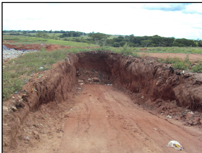
Foto 02 - Sistema de Abertura de Vala Sanitária
