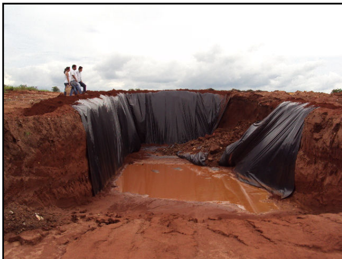
Foto 03 - Impermeabilização de valas com lona plástica, desestruturação da lateral da vala.
