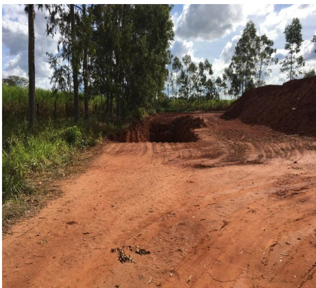
Foto 3.46 – Vista da última vala em utilização
