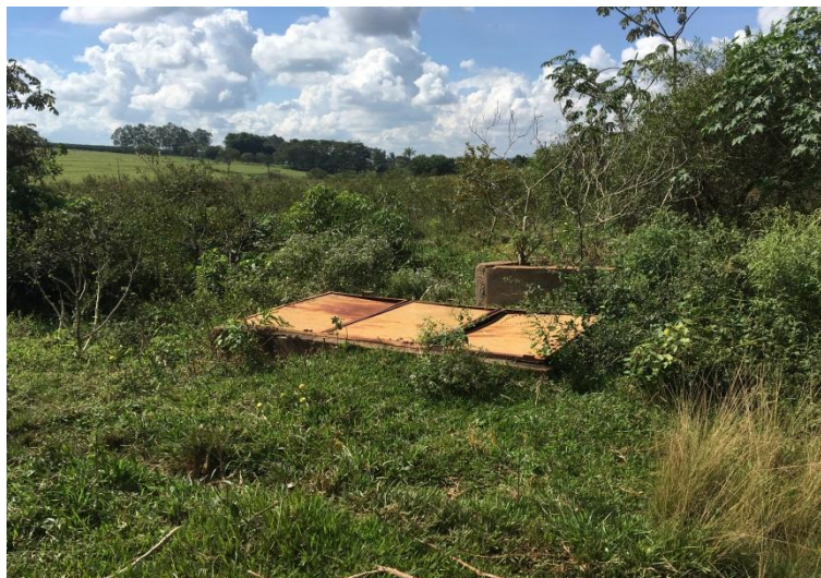
Foto 3.34 – Caixa de areia na confluência dos interceptores
