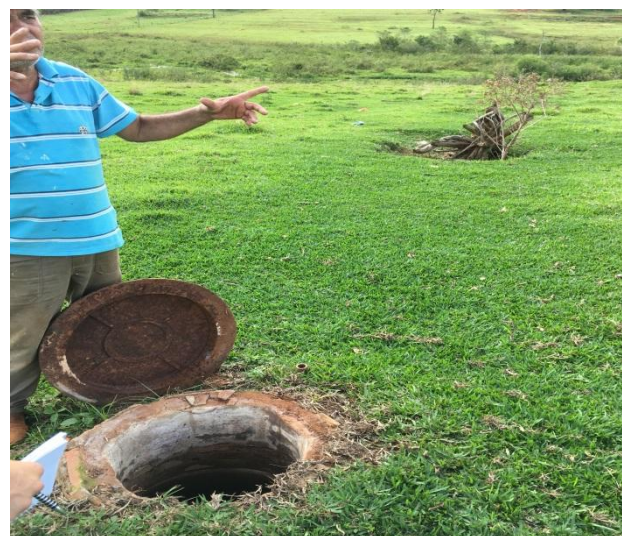
Foto 3.33 – Área de transbordamento do PV
