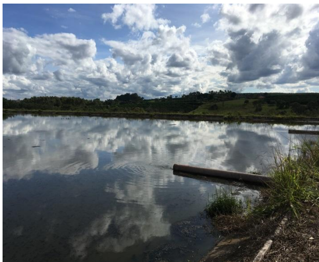
Foto 3.39 – Vista frontal da lagoa facultativa
