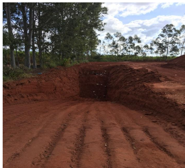
Foto 3.47 – Vala para depósito dos resíduos
