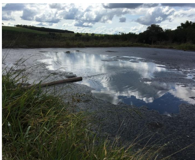
Foto 3.37 – Vista frontal da lagoa anaeróbia
