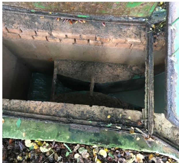
Foto 3.26 – Medidor de Vazão
