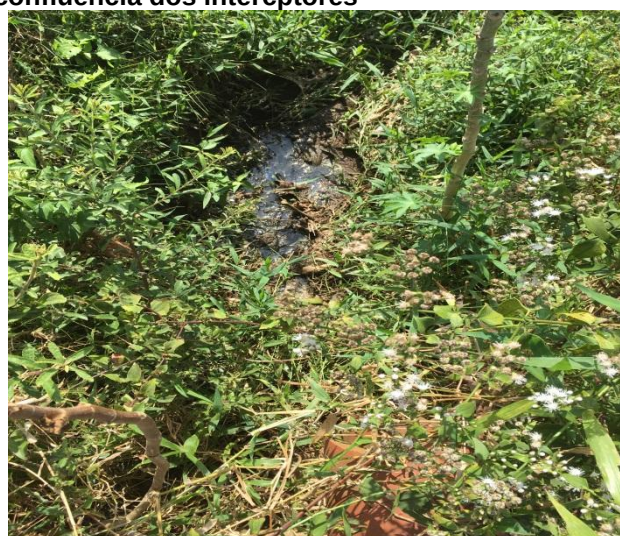
Foto 3.36 – Esgoto extravasado da caixa de areia
