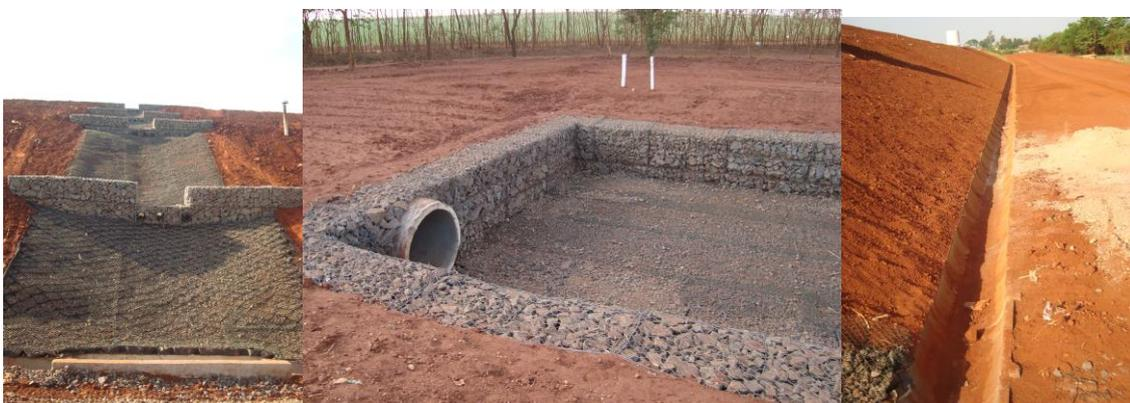
Figura 23: Drenagem de Águas Pluviais, detalhe dos dissipadores de energia e das canaletas laterais. Fonte: DAEMA, 2011.
