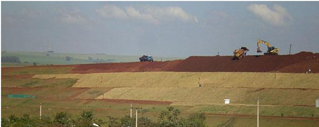
Figura 26: Regularização dos taludes e plantio de gramíneas. Fonte: DAEMA, 2011.
