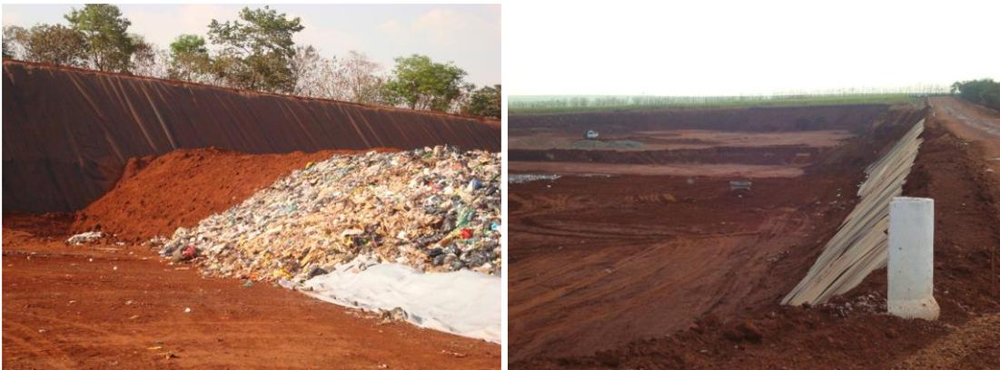
Figura 20: Sistema da Aterramento de camadas, com cobertura dos resduos com solo e a geomembrana de PEAD. Fonte: DAEMA, 2011.
