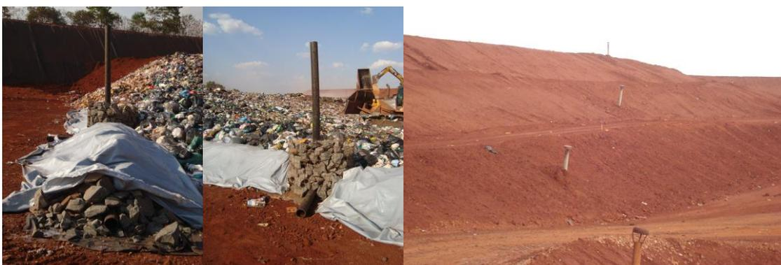
Figura 22: Detalhe dos Drenos de Gases e Chorume e os drenos de gases após o aterramento dos resíduos. Fonte: DAEMA, 2011.
