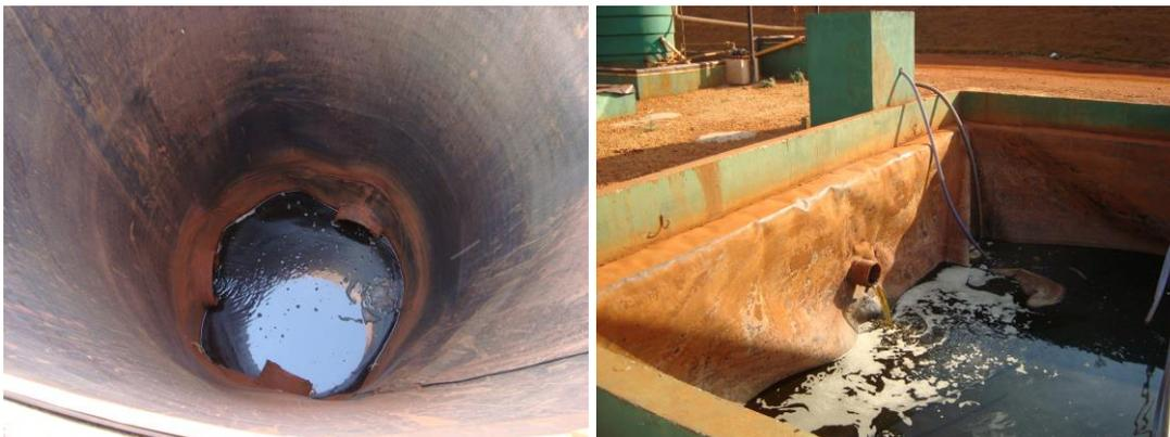
Figura 21: Tubos de PEAD encaminhando o chorume até o tanque de acumulação para posterior tratamento. Fonte: DAEMA, 2011.
