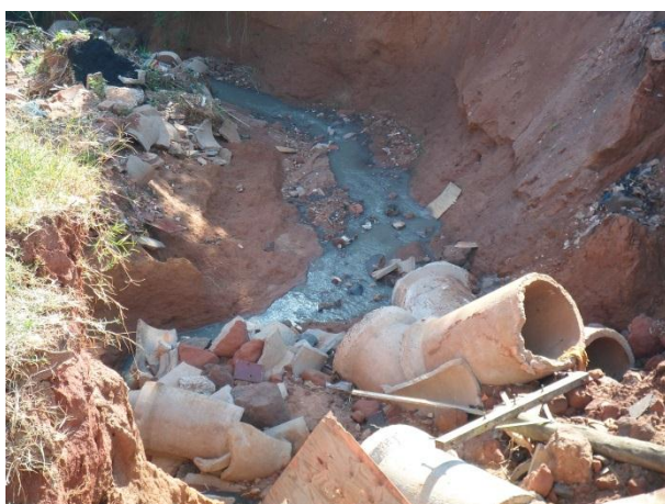
Foto 4.22 - Lançamento córrego Xavier
