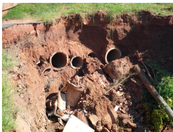
Foto 4.23 - Lançamento córrego Xavier
