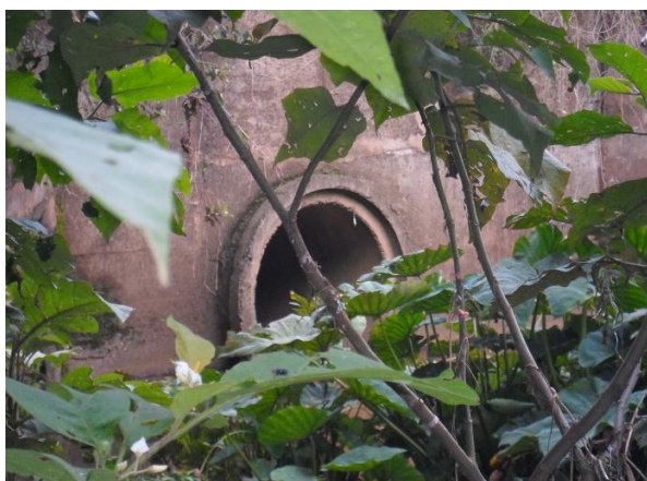
Foto 4.20 - Travessia Avenida Deputado Aldo Lupo
