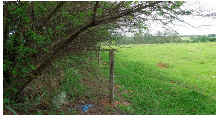
Figura 25 – Cercamento do aterro com cerca de arame liso e madeira.
