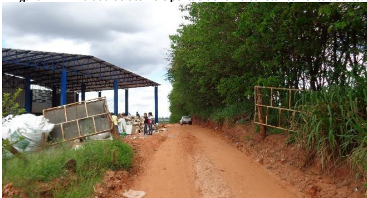
Figura 24 – Entrada do aterro e portão de ferro constantemente aberto.
