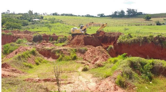
Figura 30 – Retirada de solo de terreno vizinho ao aterro.
