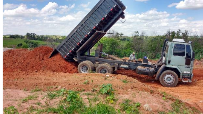
Figura 31 – Caminhão descarregando o solo para recobrimento dos resíduos.
