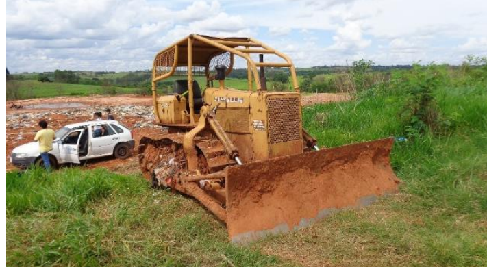
Figura 29 – Trator de esteira utilizado para o recobrimento dos resíduos.
