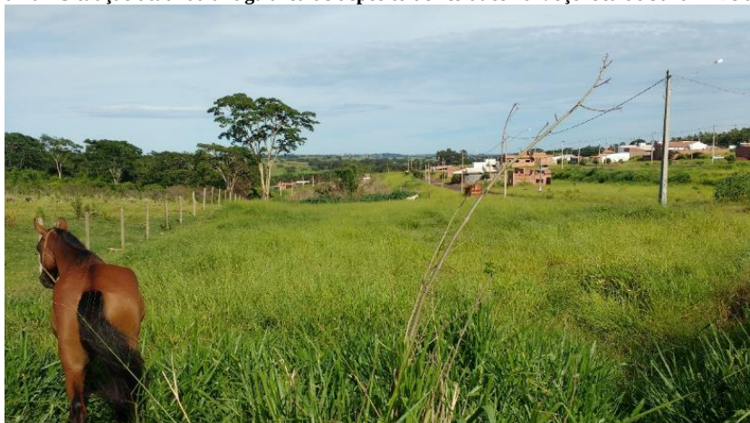
Figura 40 – Situação atual da antiga área de depósito de resíduos na Voçoroca do Jardim Bela Vista
