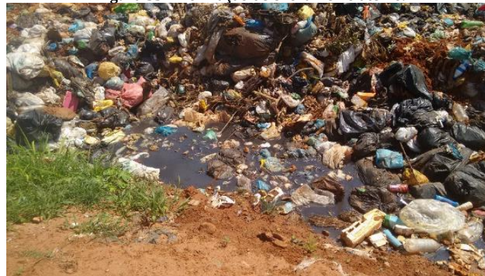
Figura 33 – Formação de chorume no aterro.
