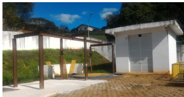
Foto 3.16 – Casa do gerador e bombeamento
