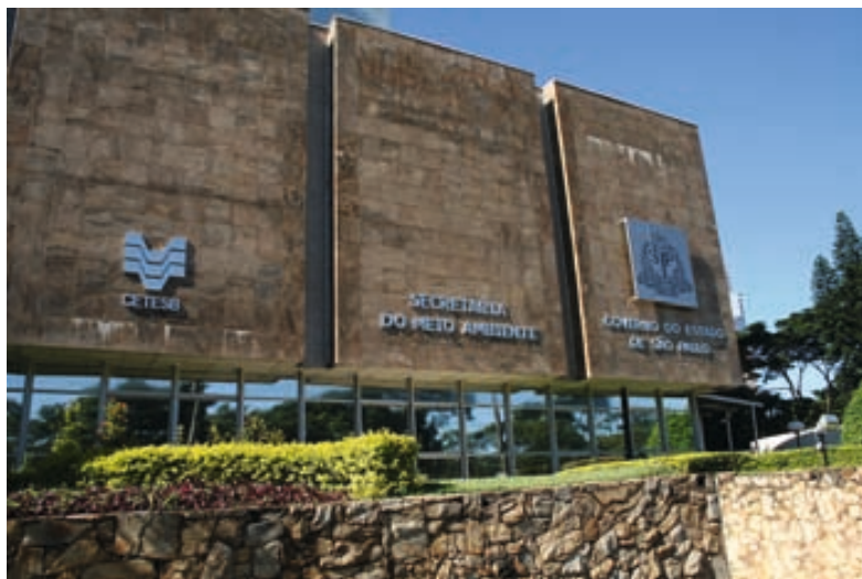
FIGURA 16 – FACHADA DA SECRETARIA DO MEIO AMBIENTE.
