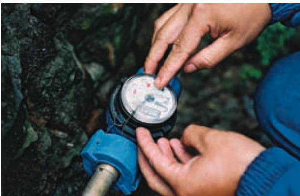
FIGURA 35 – VERIFICAÇÃO DE HIDRÔMETRO.
