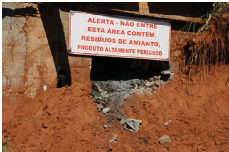
FIGURA 29 – ÁREA CONTAMINADA COM AMIANTO.
