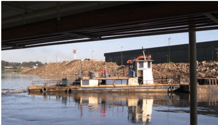
FIGURA 26 – OBRAS NO RIO TIETÊ.
