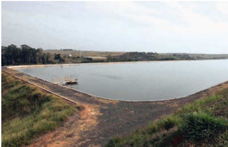
FIGURA 23 – TRATAMENTO DE ÁGUA PARA REUSO.
