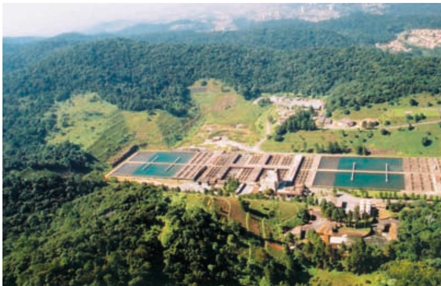
FIGURA 24 – ESTAÇÃO DE TRATAMENTO DE ESGOTO - CANTAREIRA, SP.
