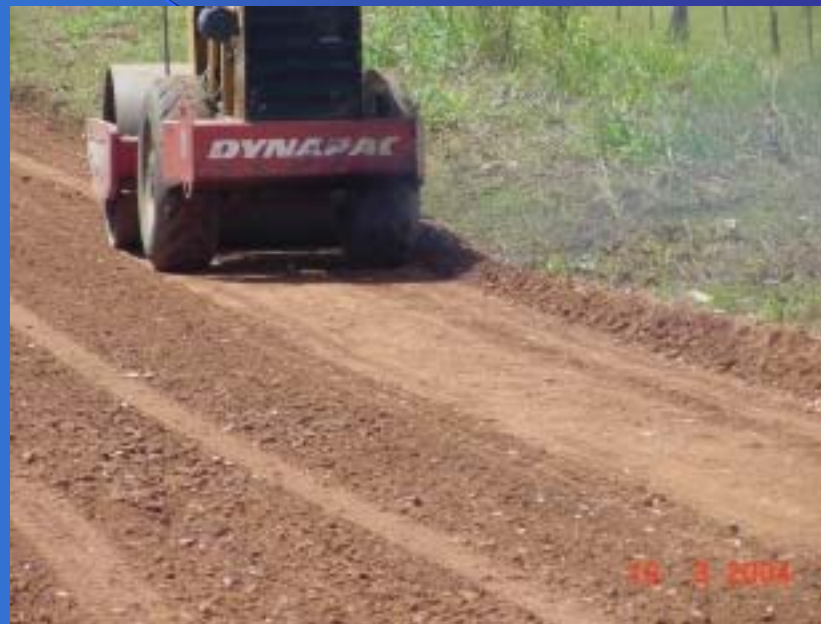
Pavimentação - trecho experimental
