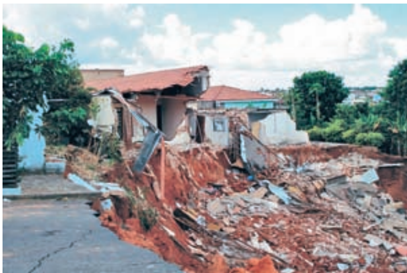
Foto 11: Erosão em Monte Alto (SP) (Foto: Luís Antônio Pereira de Souza). 写真 11 サンパウロ州モンテ・アウト市内で地崩れの侵食現象に破壊 された民家（L・A・P・デ・ソウザ撮影）
