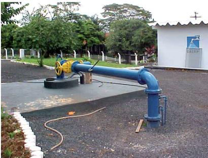
Ribeirão Preto (SP) – Poço tubular corretamente construído e protegido. Foto: Arquivo IG/SMA.
