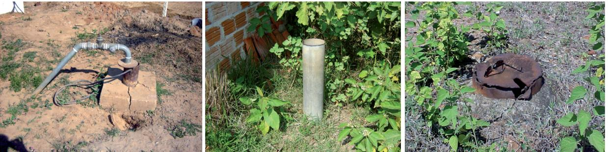
Poço com trinca na laje de proteção e tampa mal colocada.
