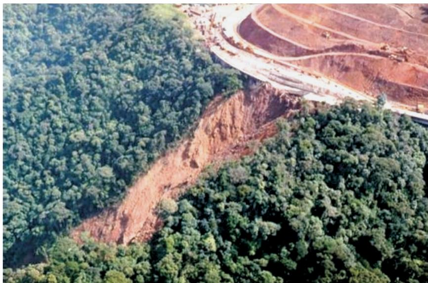
Figura 8.8. Escorregamento na Serra do Mar, atingindo a Rodovia Anchieta, Km 42, 2001 (Fonte: acervo IG-SMA).
