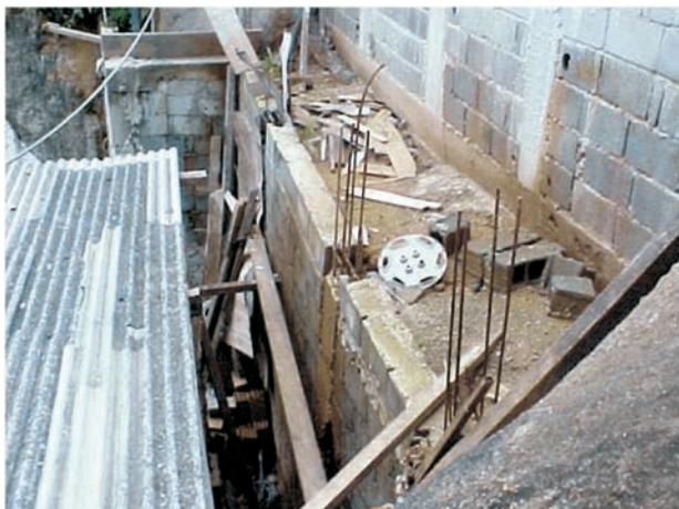
Figura 9.6. Mesmo local da foto anterior, mostrando muro de contenção construído posteriormente ao escorregamento (Foto: autoria de Daniela G. M. Faria).
