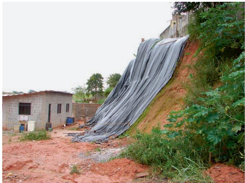
Figura 4.2. Atendimento do PPDC realizado em 2009 em Araçariguama (SP). Vista em detalhe de escorregamento em talude de corte e aterro, com moradias localizadas no topo e na base do talude (Fonte: Acervo IG-SMA).
