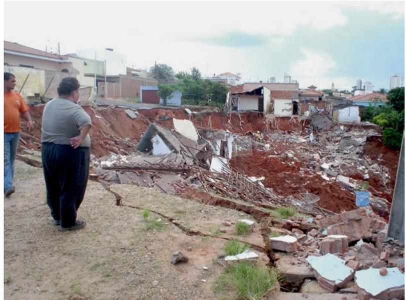
Figura 4.1. Atendimento do PPDC realizado em 2007, em Monte Alto (SP). Vista geral de processo de escorregamento em área de aterro sobre erosão em forma de boçoroca (Fonte: Acervo IG-SMA).
