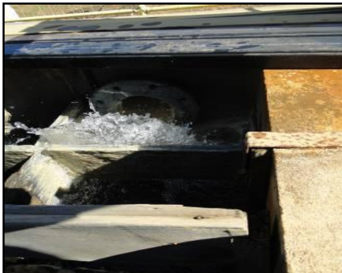
Figura 28 - Chegada da ETA
