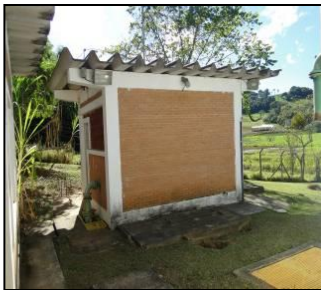
Figura 41 - Estação elevatória de água tratada - ETA
