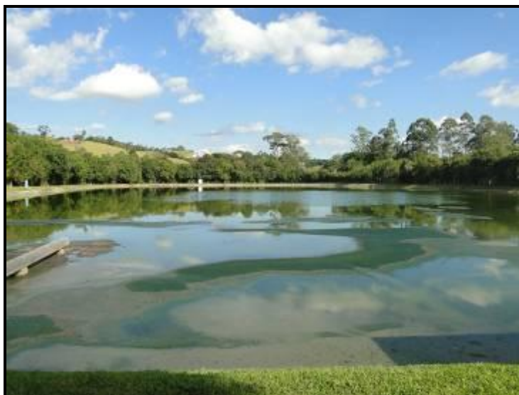
Figura 59 - Estação de tratamento de esgoto
