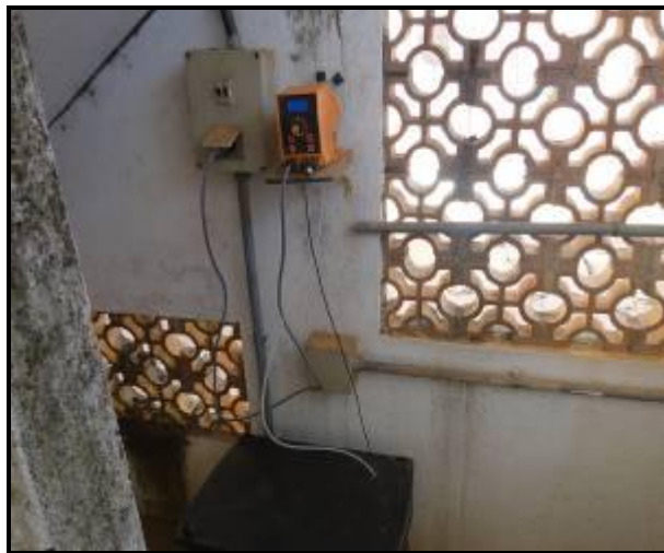
Figura 35 - Sistema de dosagem de flúor
