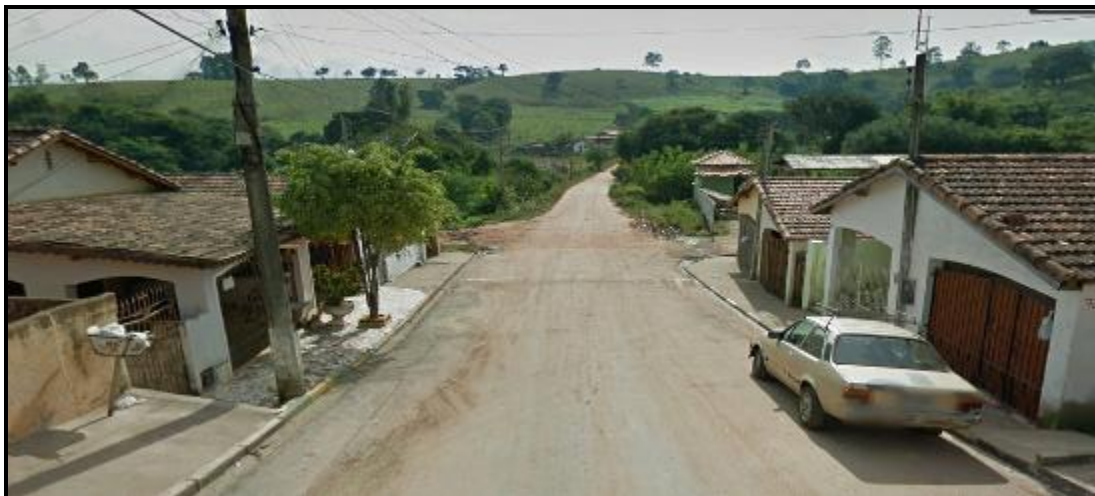
Figura 83 - Vista oposta a da figura anterior
