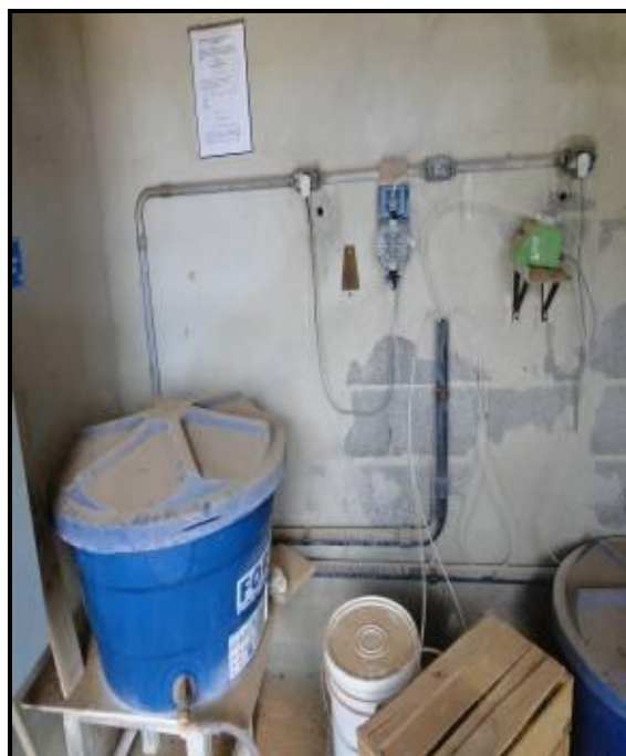
Figura 46 - Dosagem de cloro e flúor
