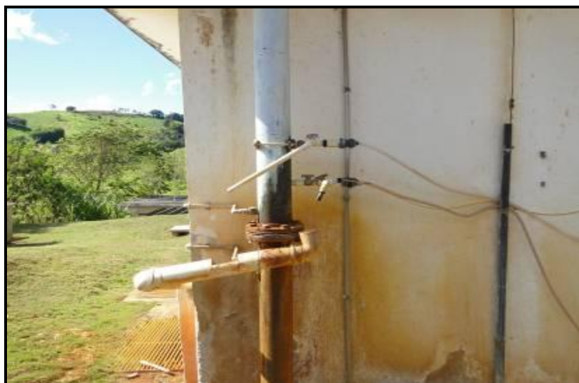
Figura 36 - Aplicação de sulfato de alumínio
