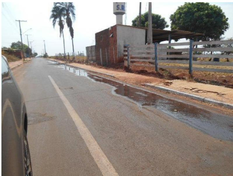
ESCOAMENTO INADEQUADO DE AGUAS DEVIDO A FALHA NA EXECUÇÃO DO PAVIMENTO.
