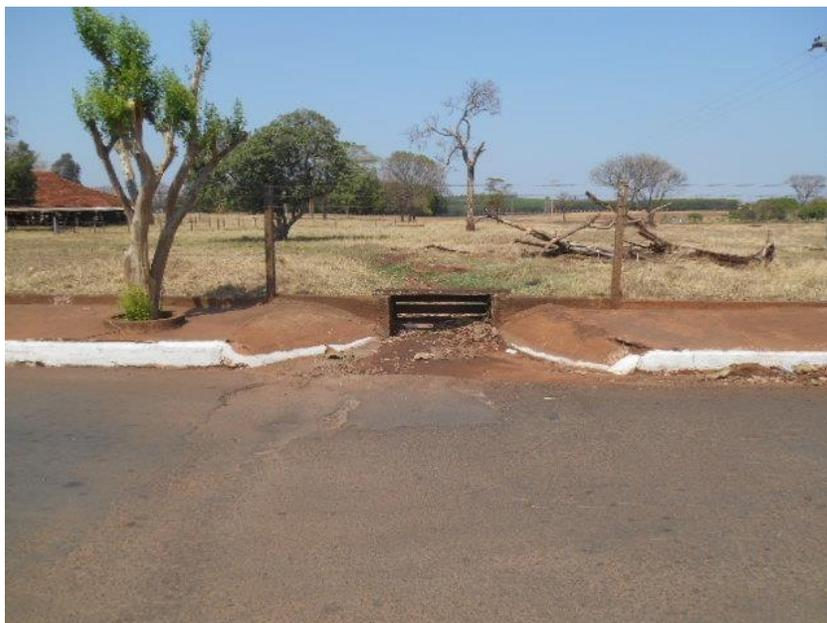
PONTO DE ESCOAMENTO LOCALIZADO NA AV. CIRCULAR C, SEM DANOS NA AREA DE DESPEJO.
