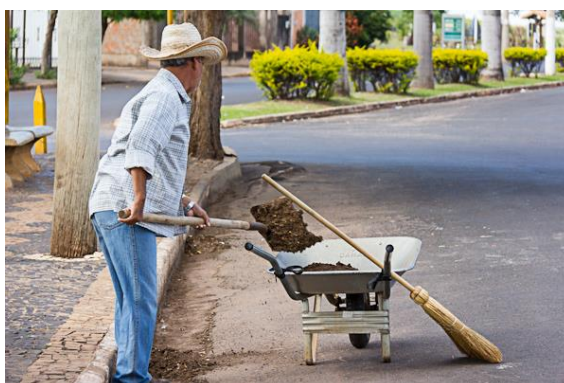
Foto 10 - Serviço de Raspagem
