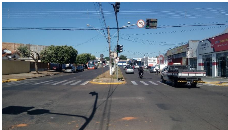
Figura 25 – Vista geral do Ponto de Alagamento 03.
