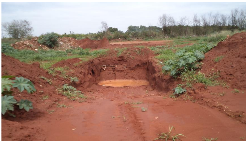
Figura 9: Vala escavada para recepção de resíduos.
