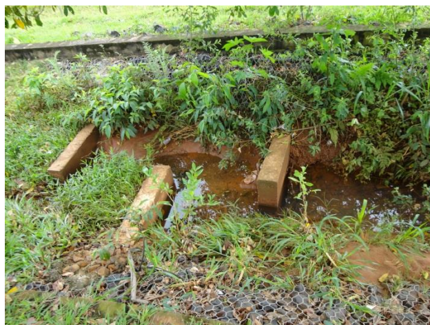
Foto 7.3.8 – Dissipador de energia do lançamento
