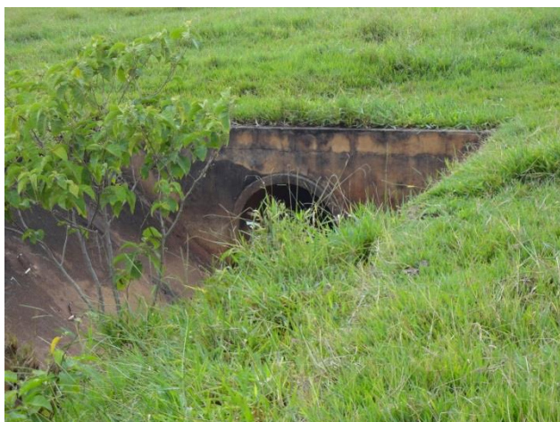
Foto 7.3.7 – Estrutura de lançamento de águas pluviais
