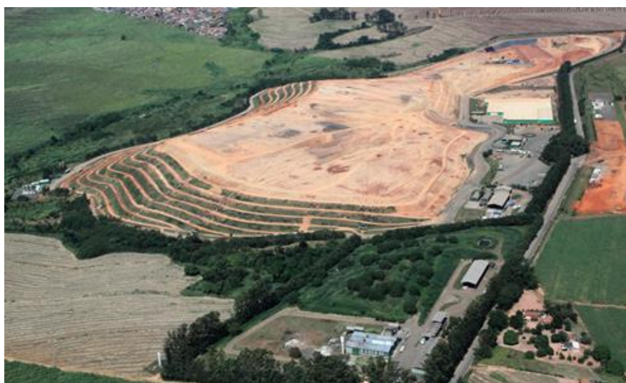
Figura 17: CGR Paulínia da empresa Estre Ambiental S.A. (aterro sanitário)
