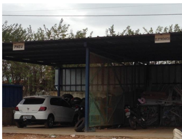
Figura 43: Segregação e armazenamento de pneus.
