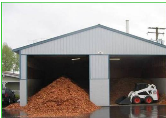
Figura 68: Galpão de compostagem da empresa WTE Brasil
