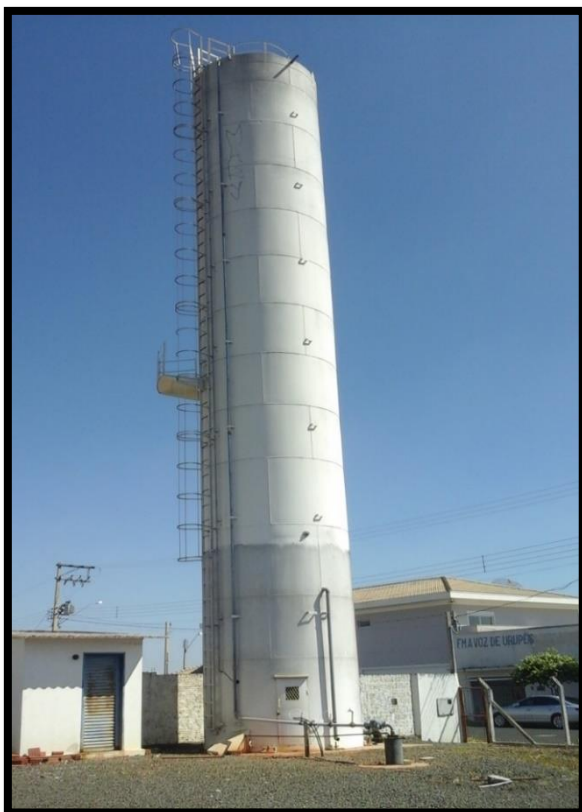
Imagem 25 – Reservatório Residencial dos Lagos II (R10)
