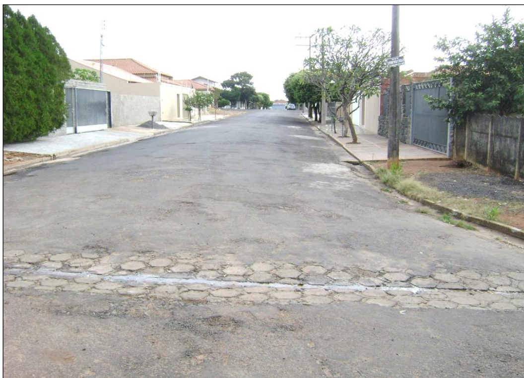
Imagem 36 – Vista da Rua Antônio Natal Crevelaro, à montante norte do ponto
