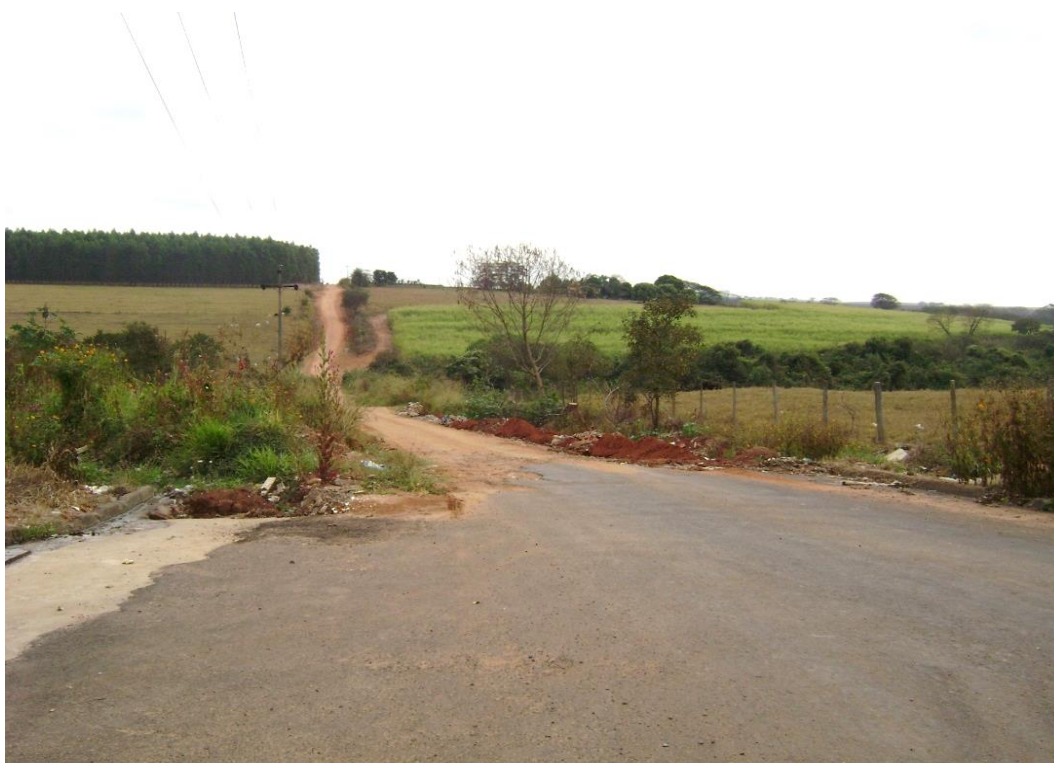
Imagem 49 – Vista da Rua Francisco Moreira da Silva, à jusante do ponto
