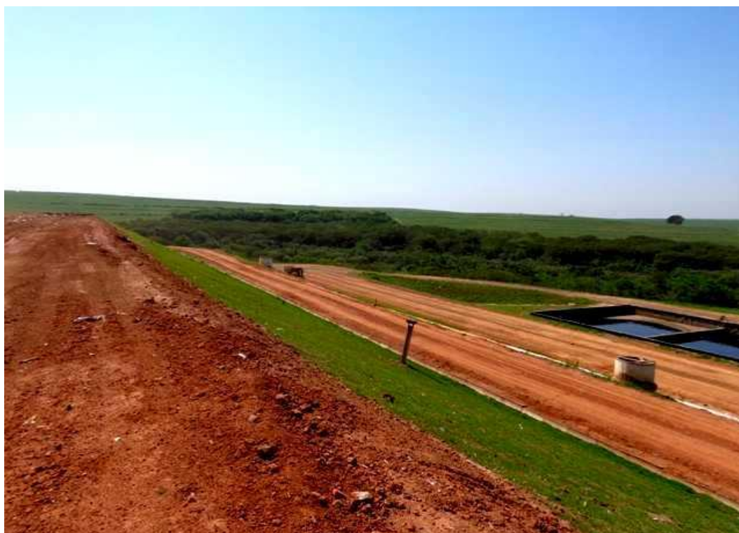
Imagem 82 – Aterro sanitário da CGR – Catanduva (Área de Disposição Final)
