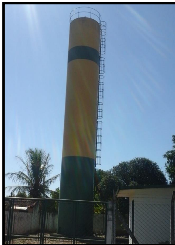
Imagem 21 – Reservatório São Gonçalo (R5)
