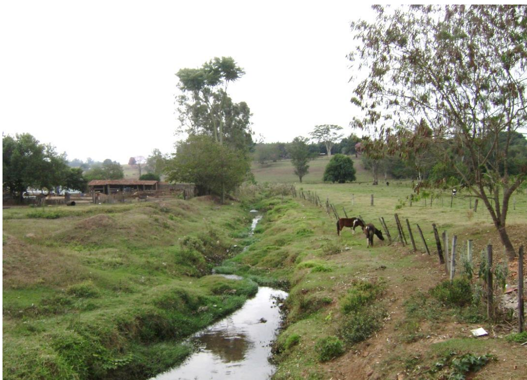
Imagem 60 – Vista do córrego Guapiru, a jusante da ponte da Rua Avelino de Abreu Isiqui
