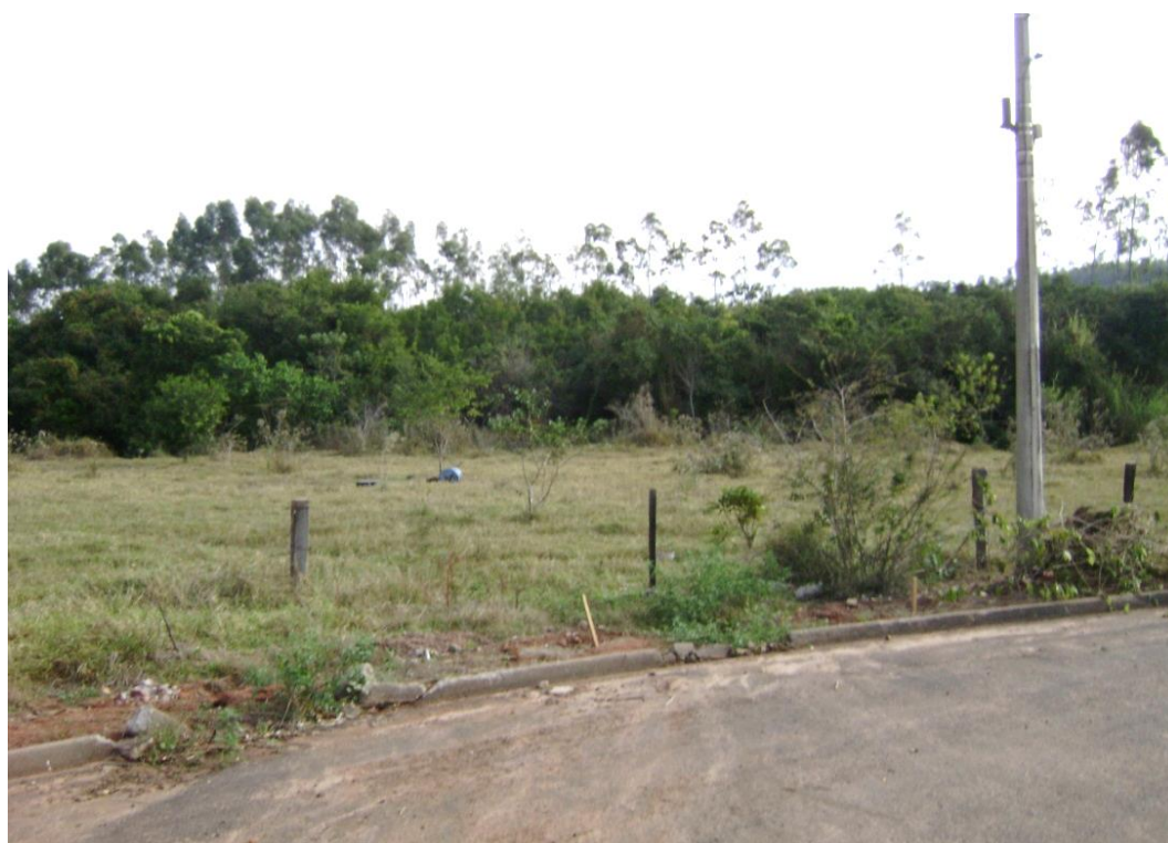
Imagem 41 – Vista do lançamento final da Avenida Roberto Mário Pedrosa
