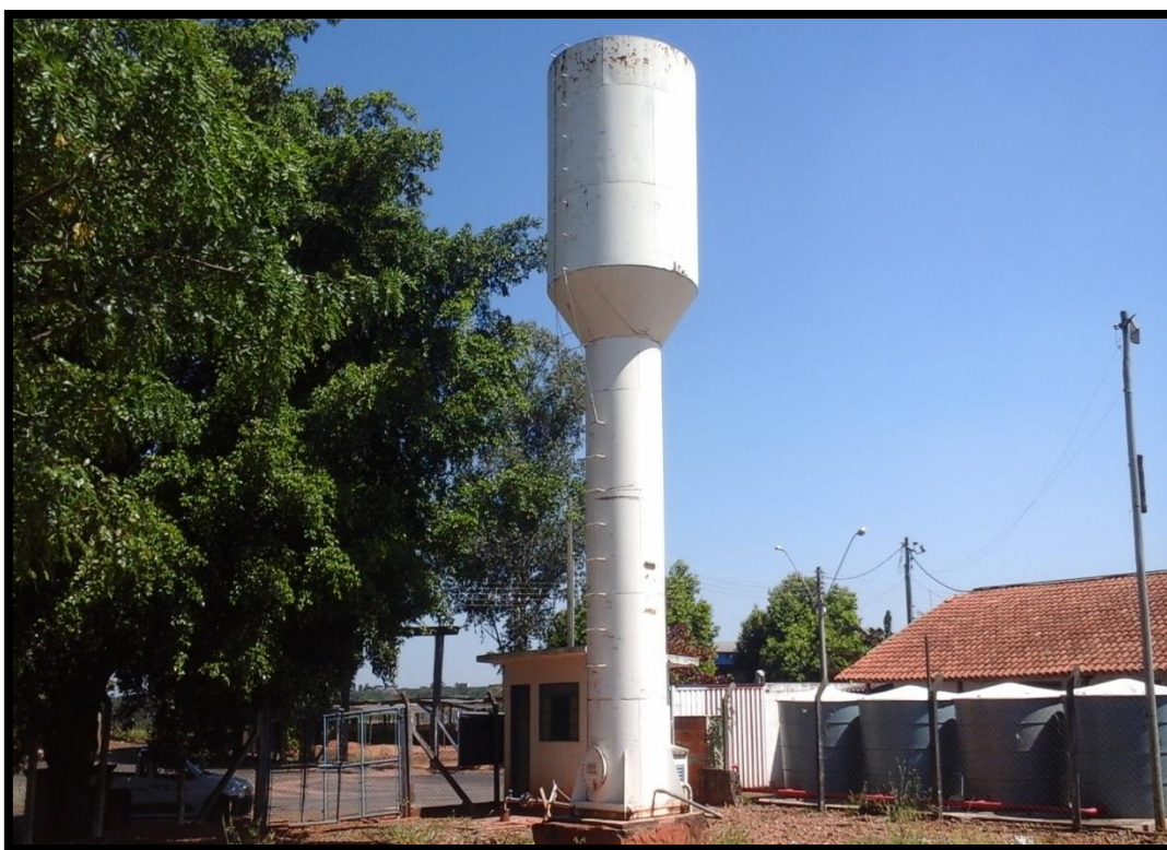
Imagem 24 – Reservatório Distrito Industrial (R9)
