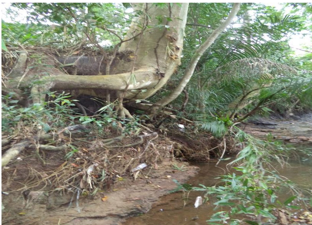
Imagem 57 – Raízes expostas de árvores que estão cedendo à erosão
