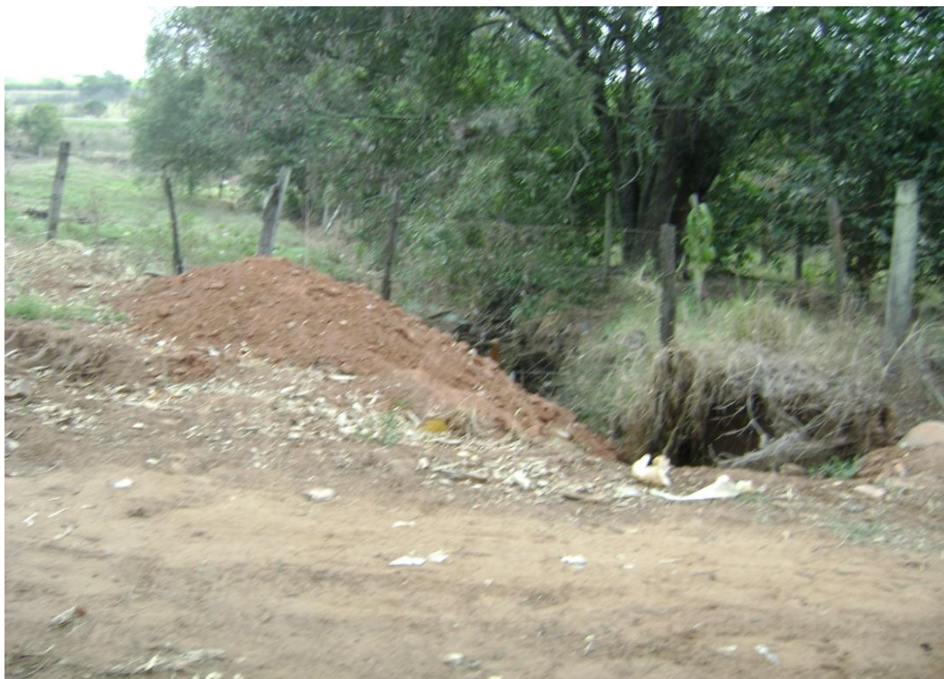
Imagem 69 – Vista do ponto de lançamento no córrego São João
