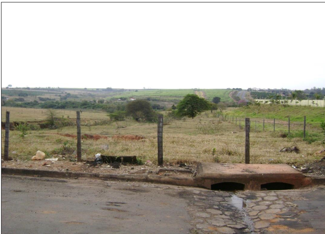
Imagem 50 – Vista do ponto de lançamento e início da erosão
