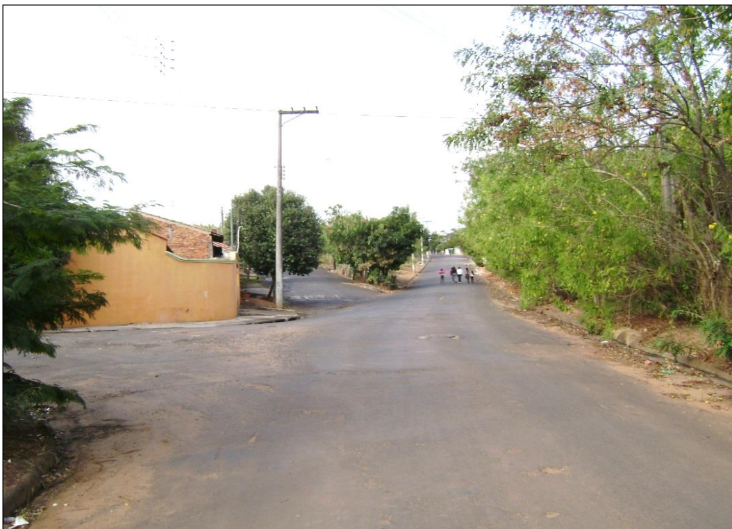
Imagem 46 – Vista à montante da Rua Maria de Souza
