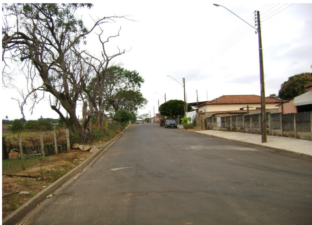
Imagem 68 – Vista a montante da Rua São João
