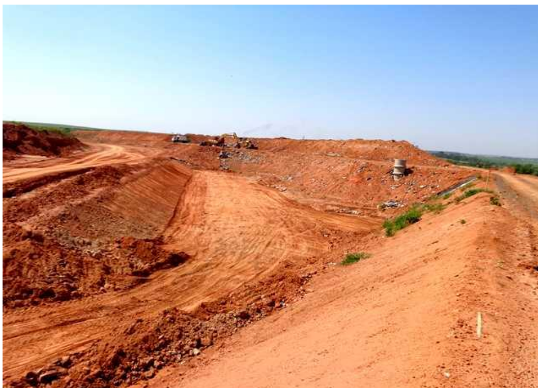
Imagem 84 – Aterro sanitário da CGR – Catanduva (Área de Disposição Final)
