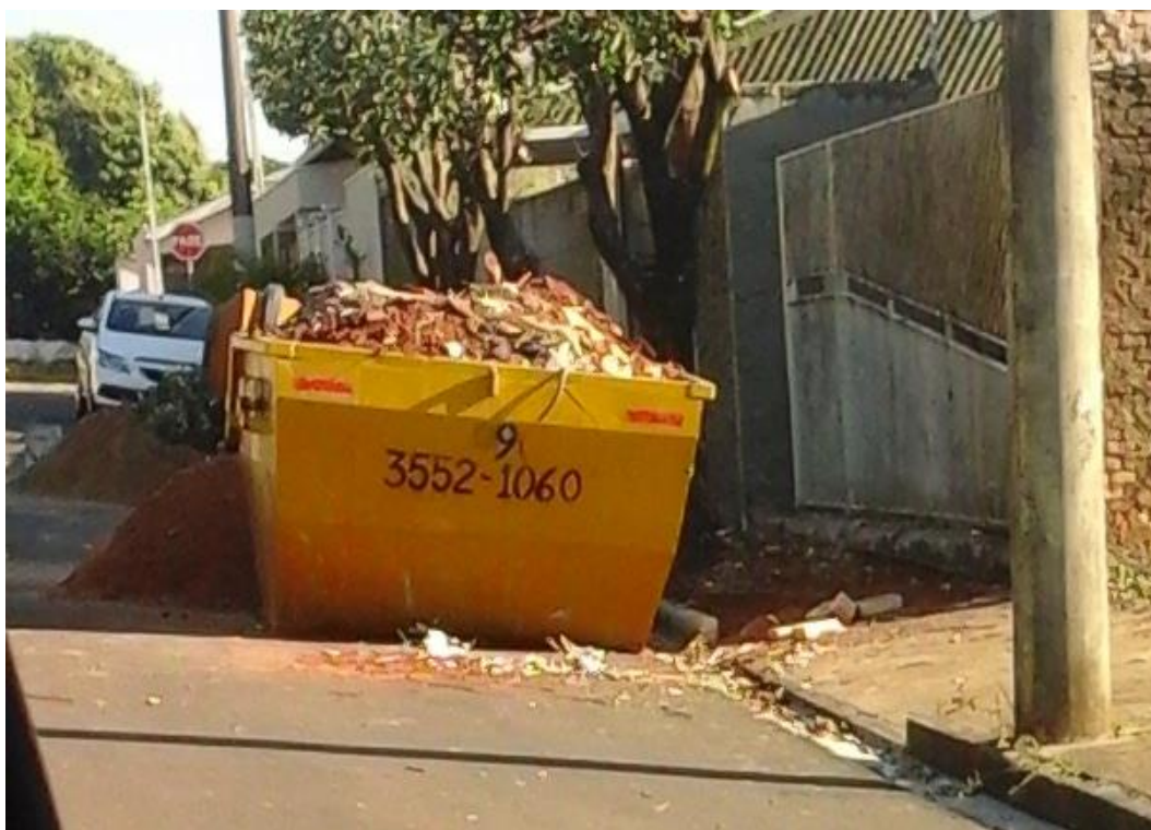
Imagem 86 - Acondicionamento dos Resíduos da Construção Civil
