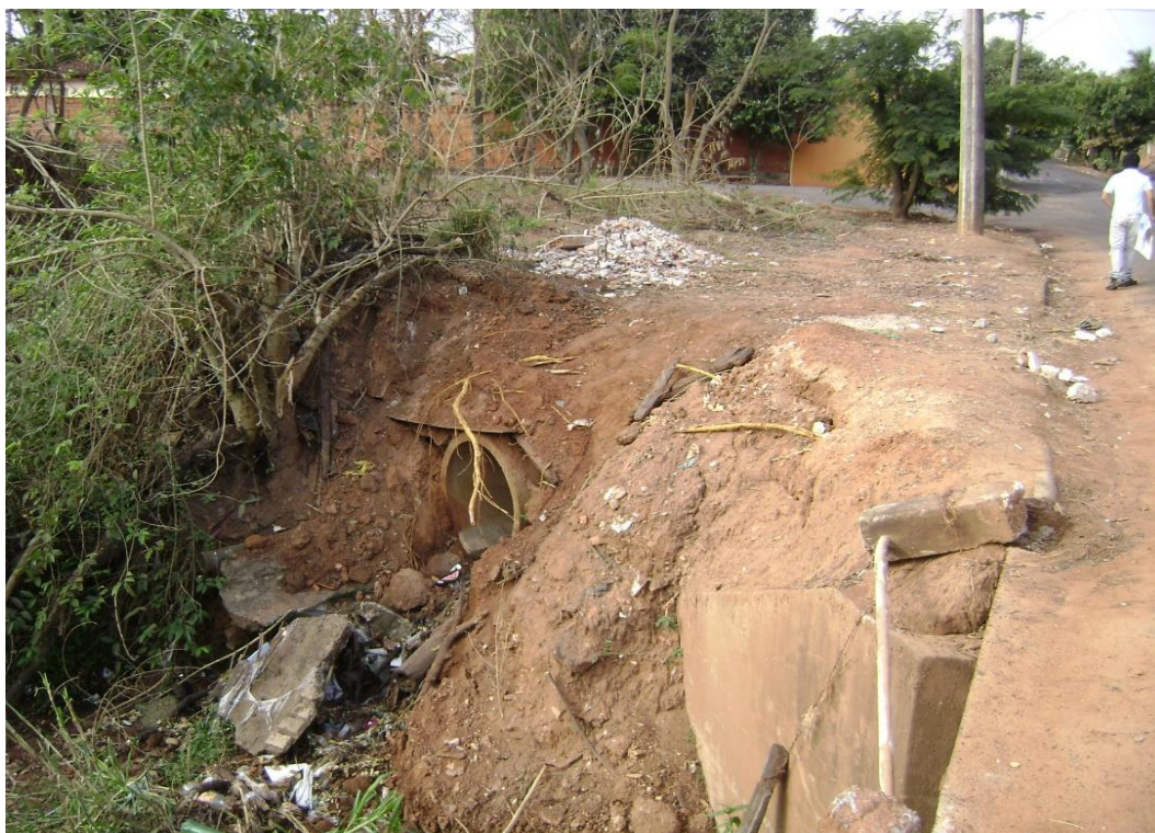
Imagem 47 – Ponto de lançamento da galeria de diâmetro 0,80 metros da Rua Maria de Souza, no córrego Água Sumida
