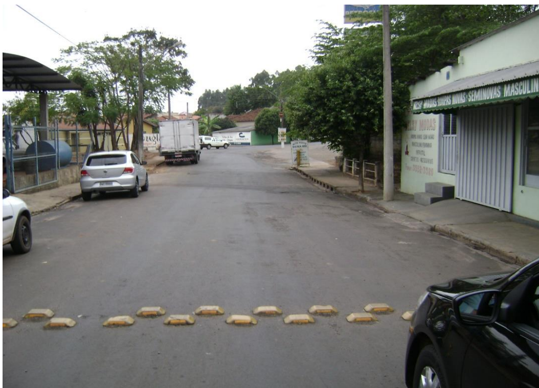
Imagem 63 – Vista da Rua Gonçalves Ledo, no ponto de lançamento
