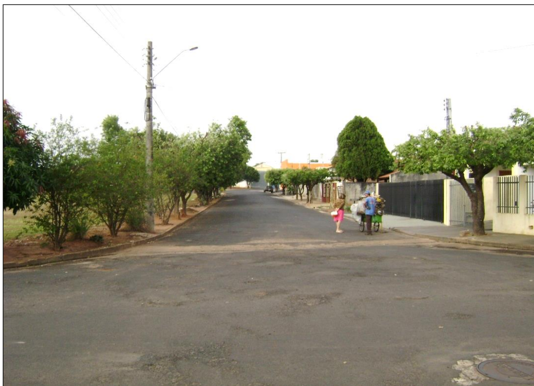
Imagem 37 – Vista da Rua Antônio Natal Crevelaro, à montante sul do ponto de inundação
