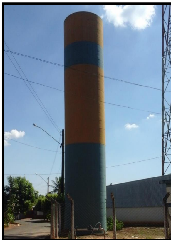
Imagem 28 – Reservatório Distrito São João do Itaguaçu (R8)
