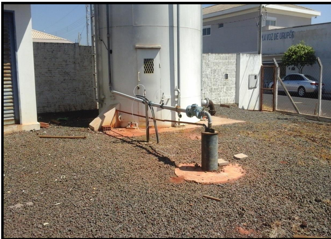
Imagem 13 – Poço Residencial dos Lagos II (P10)
