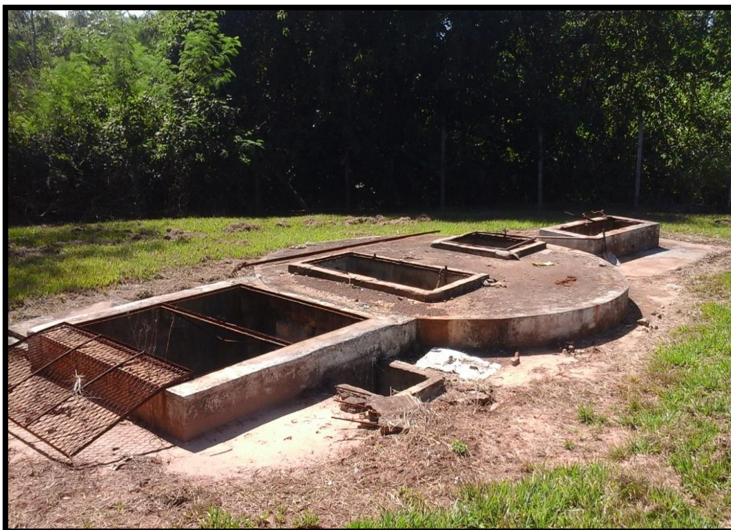
Imagem 29 – Estação Elevatória de Esgoto
