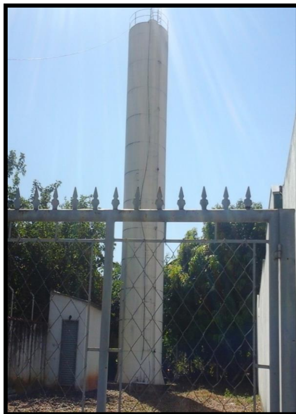
Imagem 26 – Reservatório Residencial Pôr do Sol (R11)
