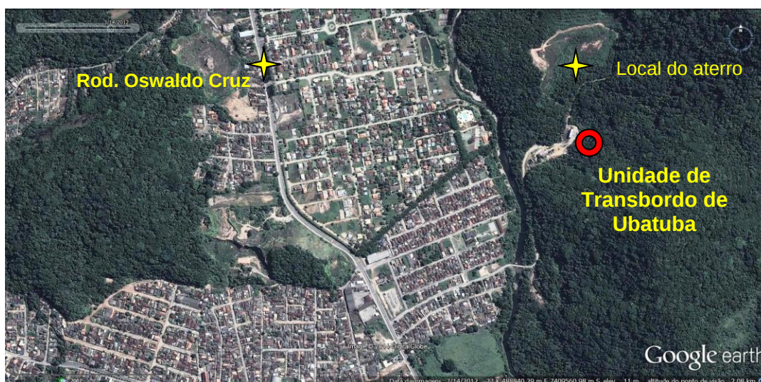
Figura 18: Vista aérea da unidade de transbordo municipal. Fonte: Google Earth.
