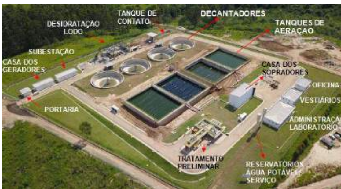
Figura 37 - Vista Aérea ETE Toledos II
