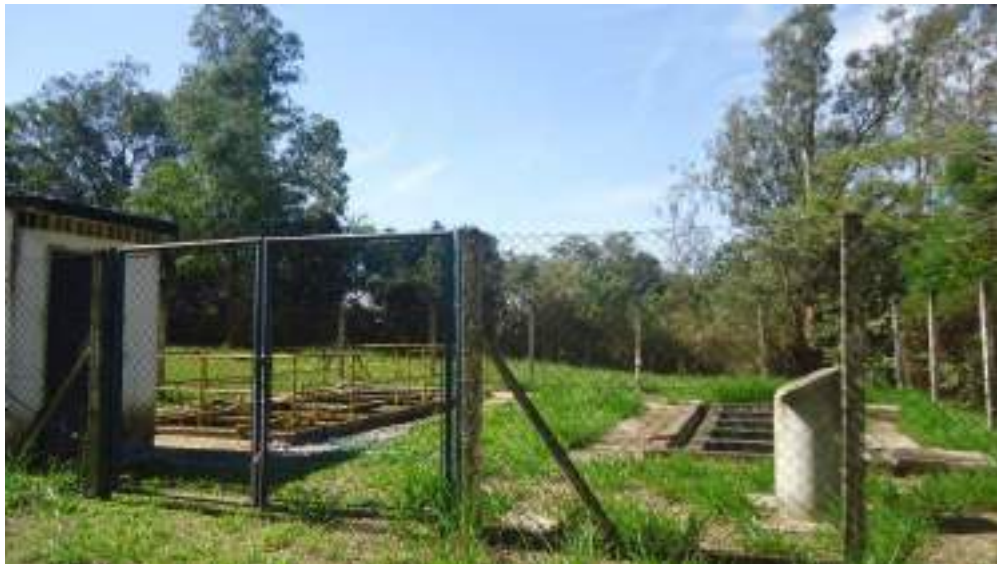
Figura 34 - Acesso à ETE Andorinhas.
