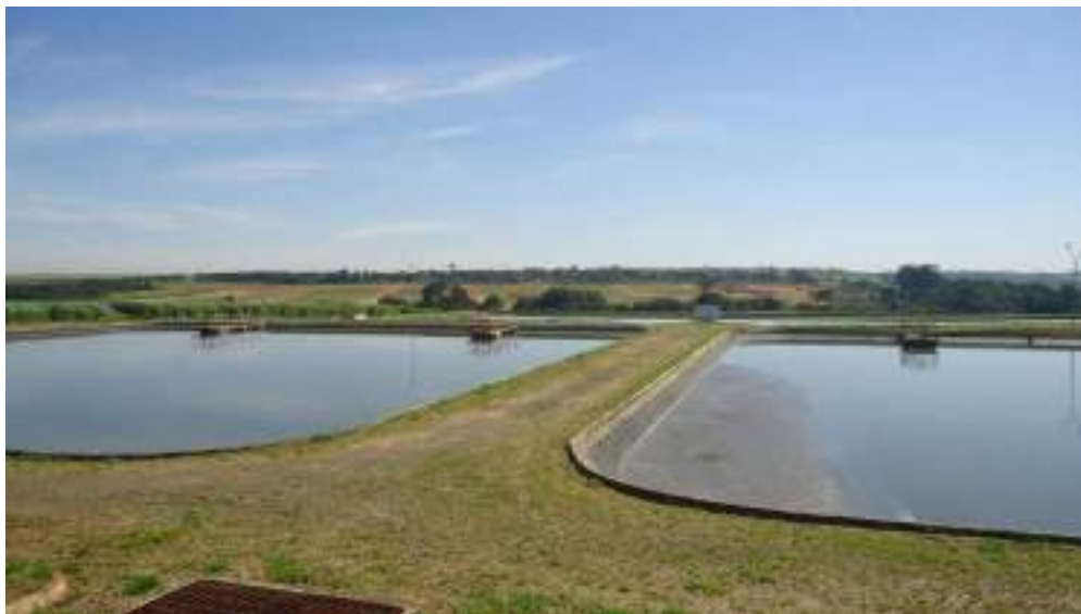
Figura 27 - Lagoas de estabilização - ETE Balsa.
