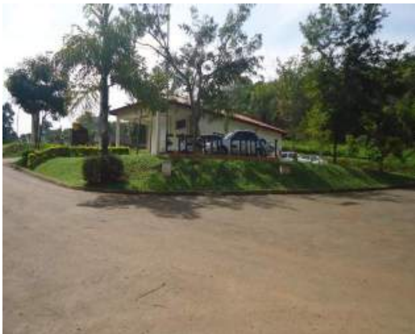
Figura 25 - Estação de Tratamento de Esgoto Toledos I.
