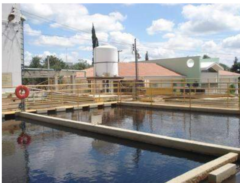
Figura 14 - Tanques de decantação ETA I
