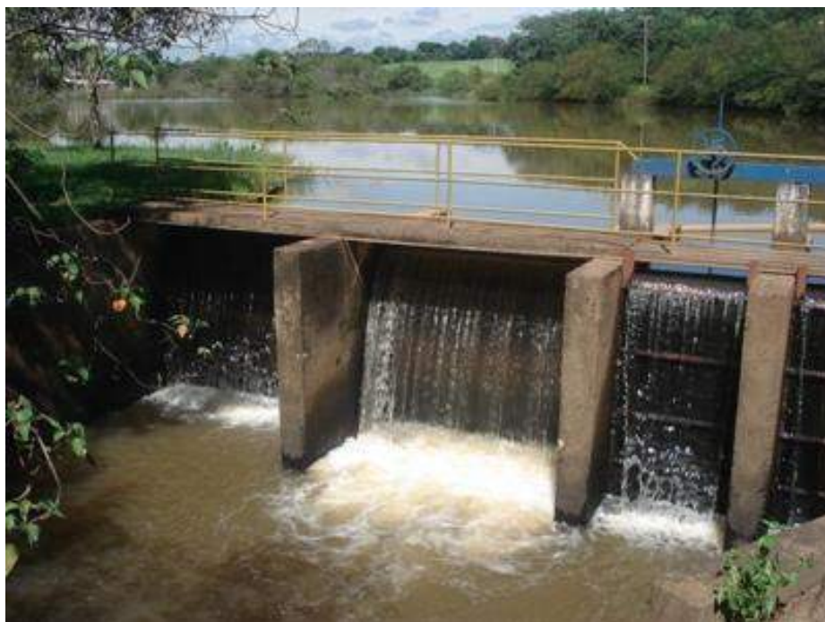
Figura 9 - Vista da barragem
