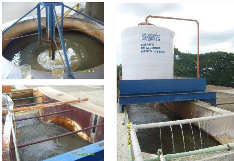
Figura 48 - Caixa Distribuidora (acima), Calha Parshall (abaixo) e Adição de Cal Hidratada e Sulfato de Alumínio (dir.)
