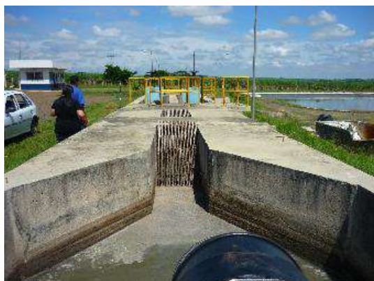
Figura 129 - Gradeamento Grosso
