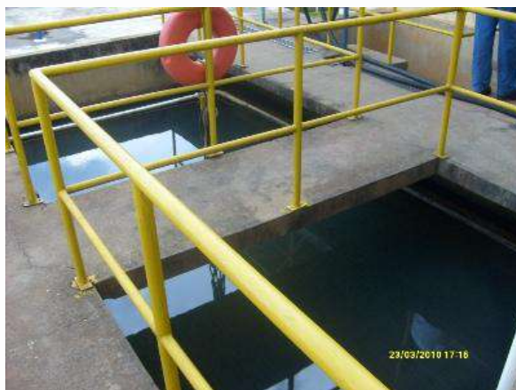
Figura 60 - Decantador
