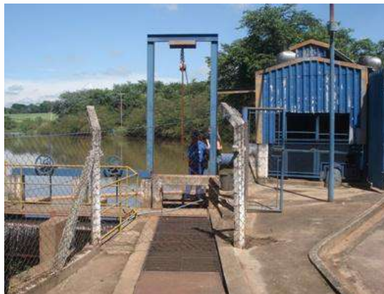
Figura 25 - Vista de Jusante do Canal de Tomada
