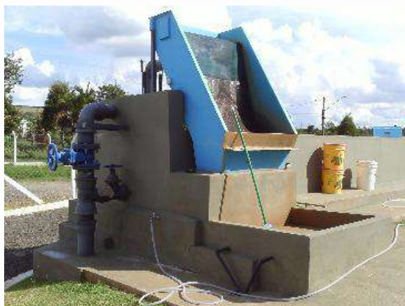
Figura 139 - Peneiramento Fino - Peneira Estática
