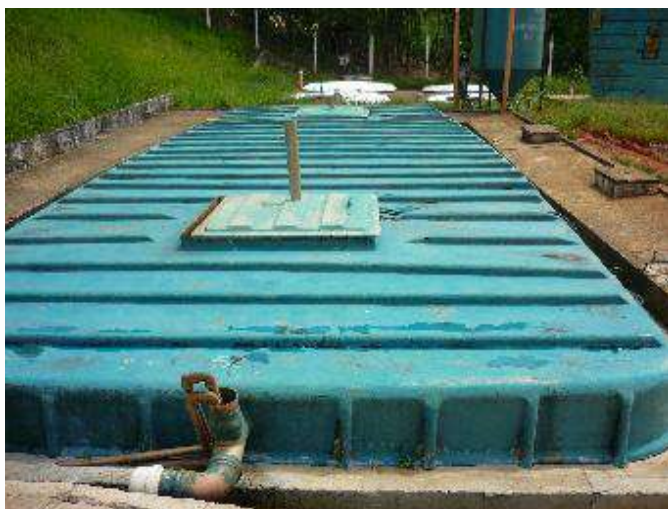
Figura 153 - Tanque de Aeração (esq.) e Detalhe do Aerador (dir.)
