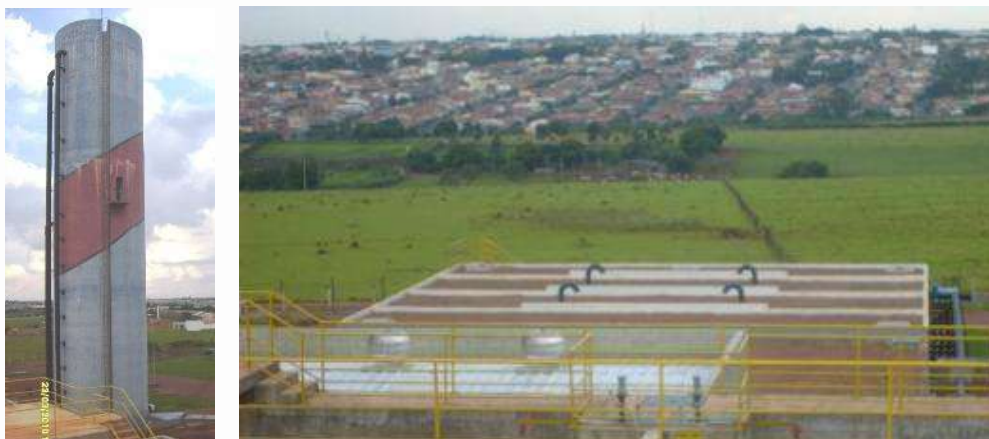
Figura 73 - Reservatório Elevado (esq.) e Reservatórios Apoiados (dir.)
