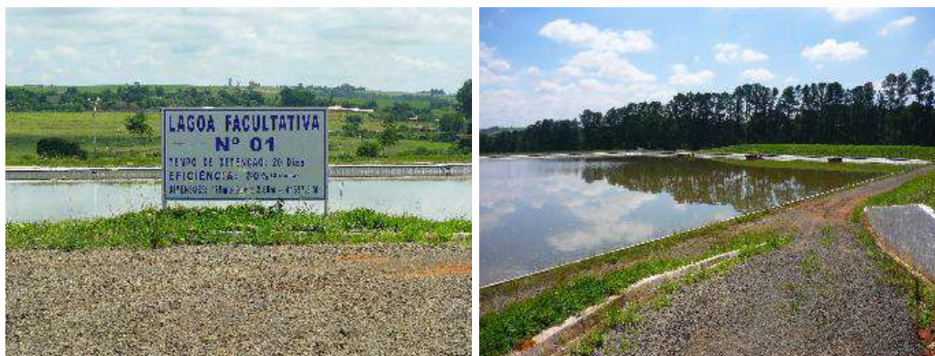
Figura 134 - Vista da Lagoa Facultativa N° 1 (esq.) e Saídas da mesma (dir.)
