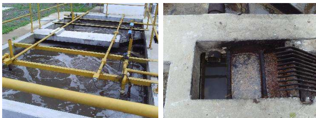
Figura 157 - Vista do Tanque de Aeração (esq.) e Detalhe da Entrada no Tanque (dir.)
