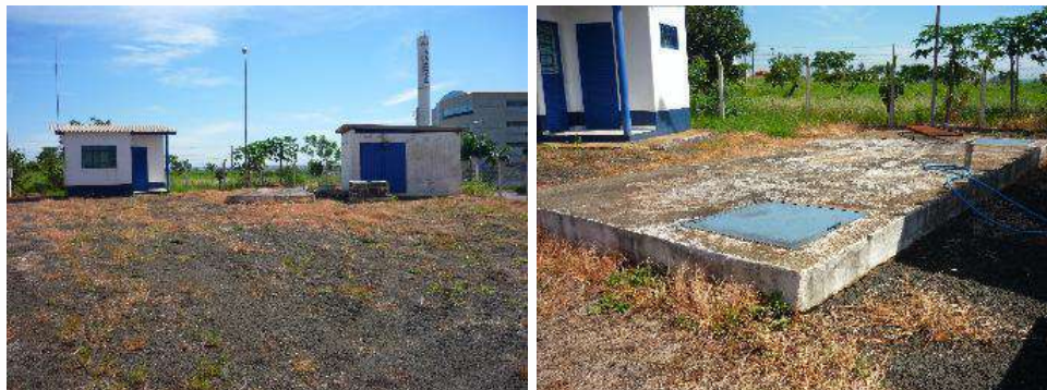
Figura 168 - Vista Geral da EEE (esq.) e Detalhe do Poço de Chegada de Esgotos (dir.)
