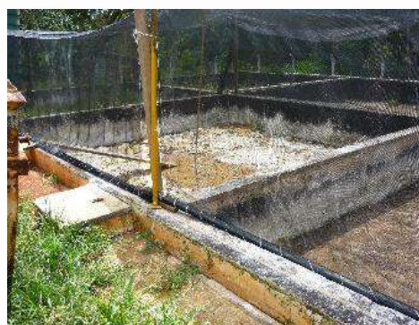
Figura 154 - Tanque de Decantação (esq.) e Leito de Secagem (dir.)
