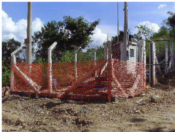
Figura 172 - Vista Geral da EEE (em obras quando da visita)
