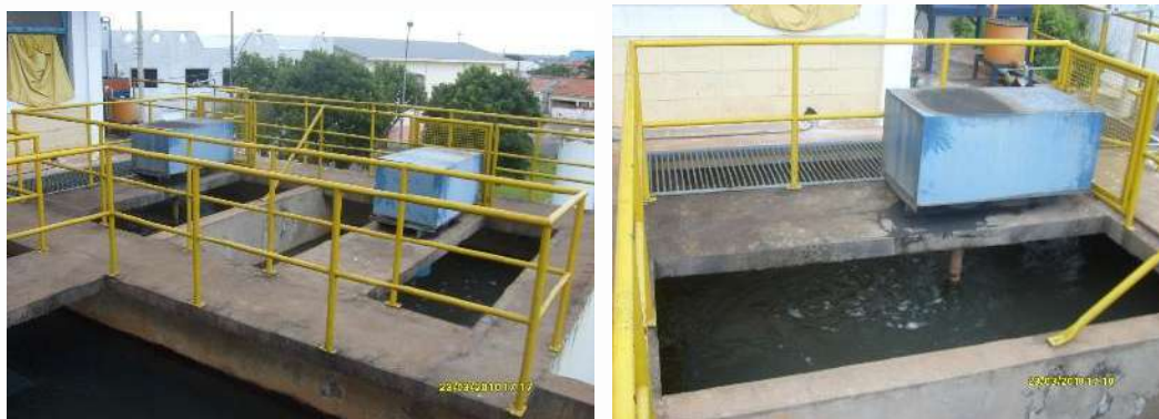
Figura 59 - Floculadores Mecânicos
