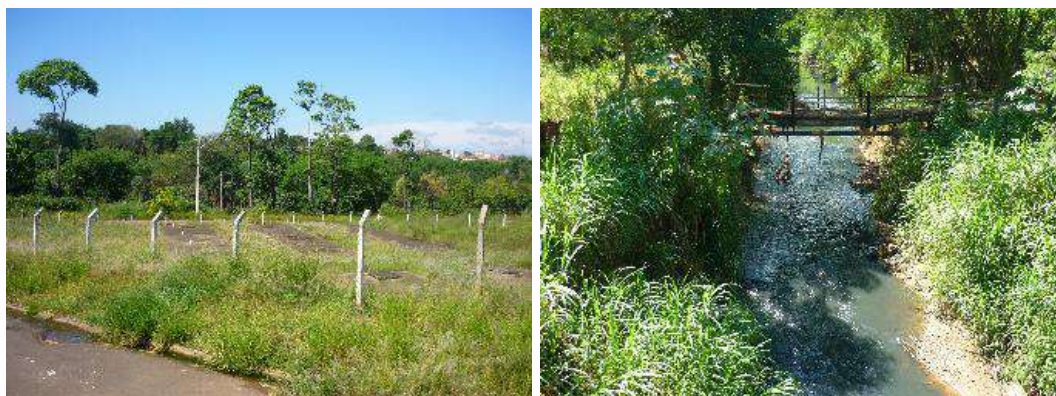
Figura 149 - Vista Geral da Estação (esq.) e Rio São Joaquim (dir.)
