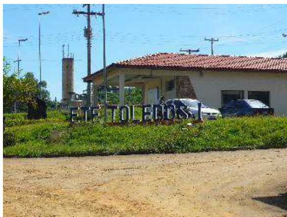
Figura 101 - ETE – Toledos 1, Acesso Principal
