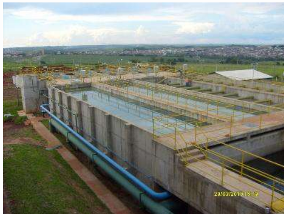
Figura 67 - Etapa 2 da ETA IV
