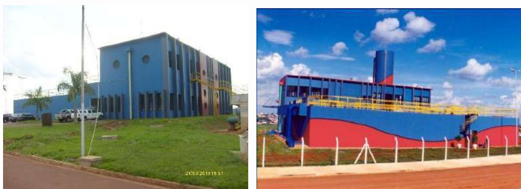
Figura 66 - Vista geral da ETA IV (Fotos: Consorcio PCJ)
