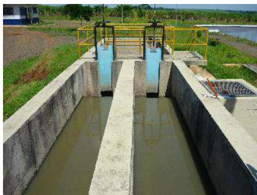
Figura 130 - Caixas de Areia
