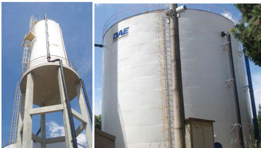
Figura 95 - Reservatório elevado (esq.) e Apoiado (dir.)
