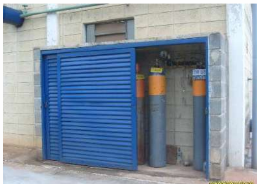
Figura 64 - Preparação de Solução de Carvão Ativado (esq.) e Cilindros de Cloro-18 kg (dir.)
