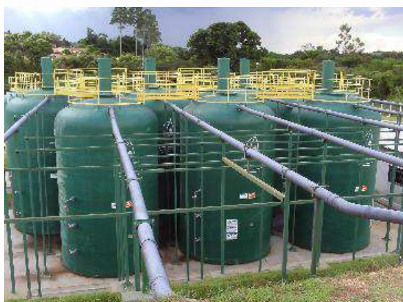
Figura 143 - Reatores anaeróbios
