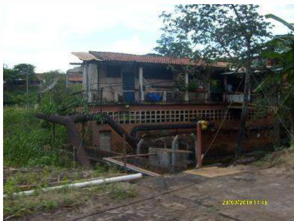
Figura 38 - Moradia irregular sobre a Casa de Bombas
