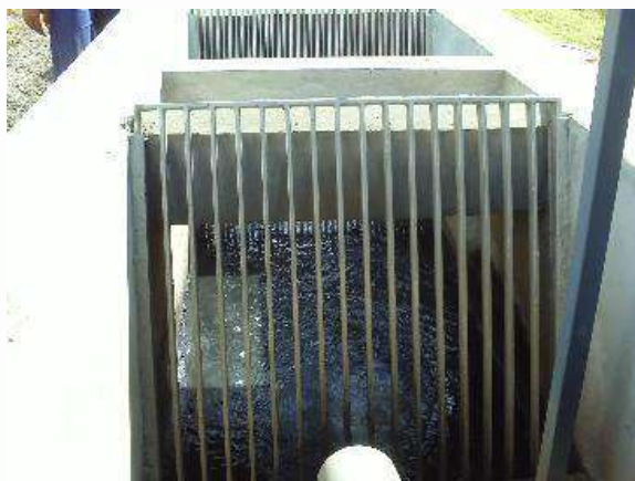
Figura 140 - Gradeamento Grosso
