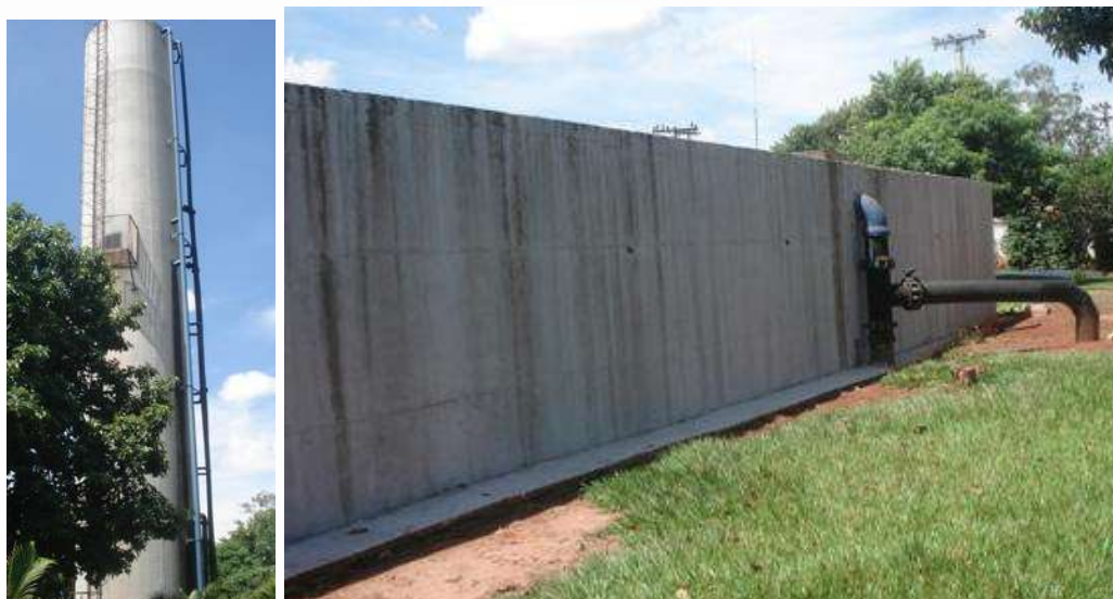
Figura 82 - Reservatório Elevado (esq.) e Semi-enterrado retangular (dir.)
