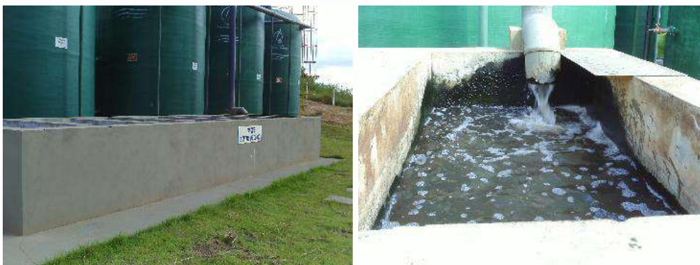
Figura 146 - Tanque de Contato – Vista lateral (esq.) e Detalhe da Entrada de Esgoto no Tanque
