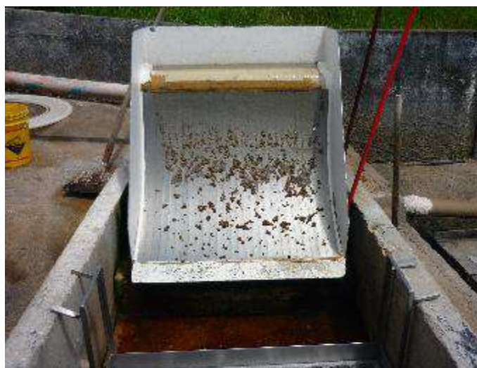
Figura 152 - Medidor Parshall (esq.) e Peneiramento Fino: Peneira Estática (dir.)
