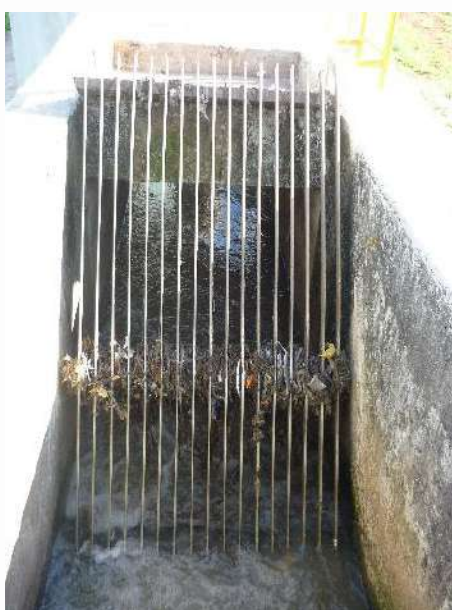
Figura 103 - Gradeamento com Limpeza Manual
