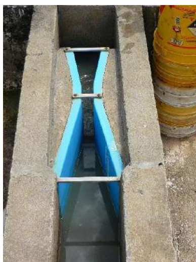
Figura 152 - Medidor Parshall (esq.) e Peneiramento Fino: Peneira Estática (dir.)
