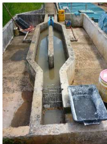
Figura 151 - Vista Geral da ETA (esq.) e Canal de Entrada: Gradeamento e Caixa de Areia (dir.)
