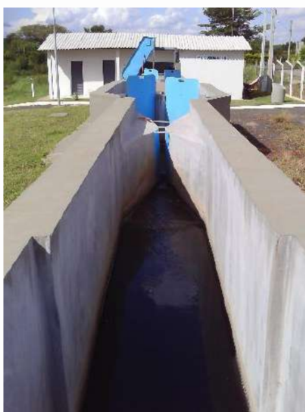
Figura 142 - Medidor Parshall
