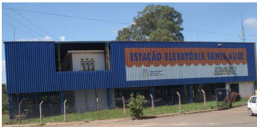
Figura 27 - Vista Exterior da Casa de Bomba.
