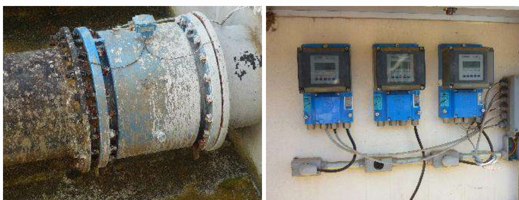
Figura 116 - Detalhe do Sensor Ultrassônico de Vazão (esq.) e Indicadores de Vazão (dir.)
