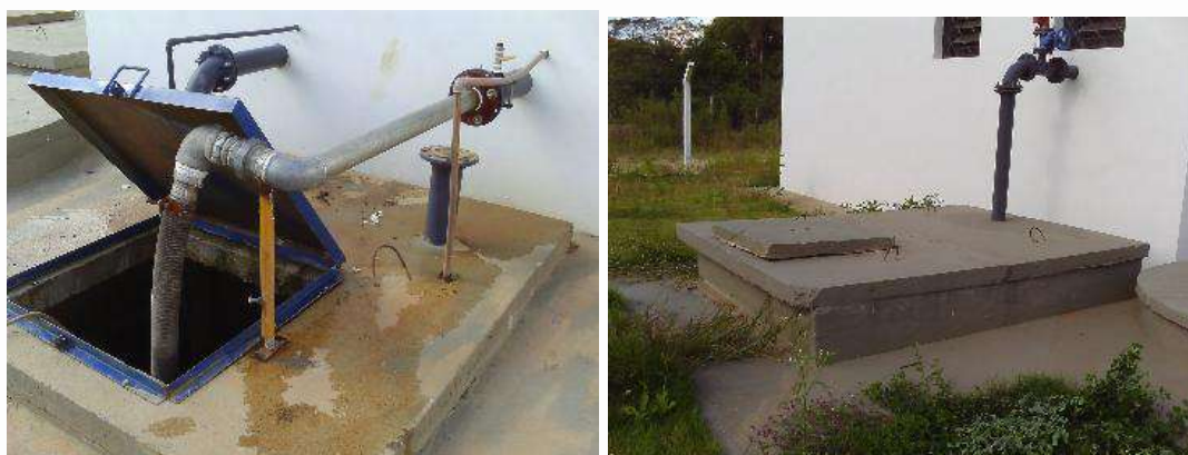
Figura 175 - Detalhe Tubulação de Sucção Adaptada (esq.) e da Tubulação de Recalque (dir.)
