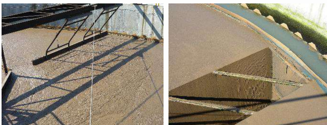
Figura 118 - Ponte Raspadora de Lodo (esq.) e Saída do Lodo Raspado na Superfície (dir.)
