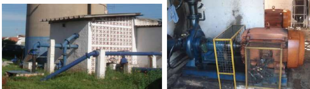
Figura 77 - Casas de bombas (esq.) e Conjunto Moto-bomba (dir.)
