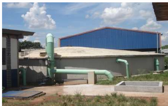
Figura 80 - Reservatório Semi-enterrado
