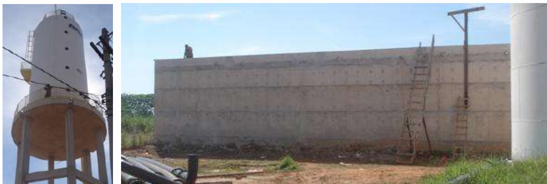
Figura 92 - Reservatórios em construção
