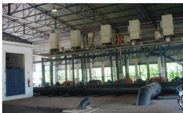
Figura 28 - Vista Interior da Casa de Bombas
