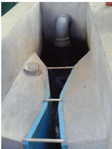
Figura 148 - Medidor Parshall
