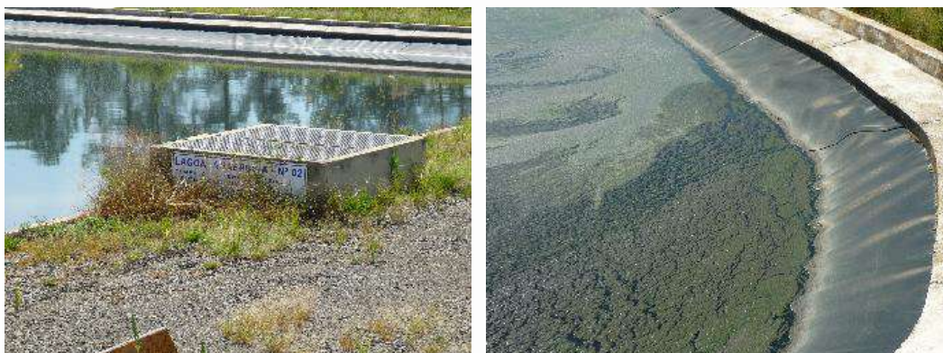
Figura 133 - Vista da Lagoa Anaeróbia 2 (esq.) e Detalhe da Manta de PEAD (dir.)
