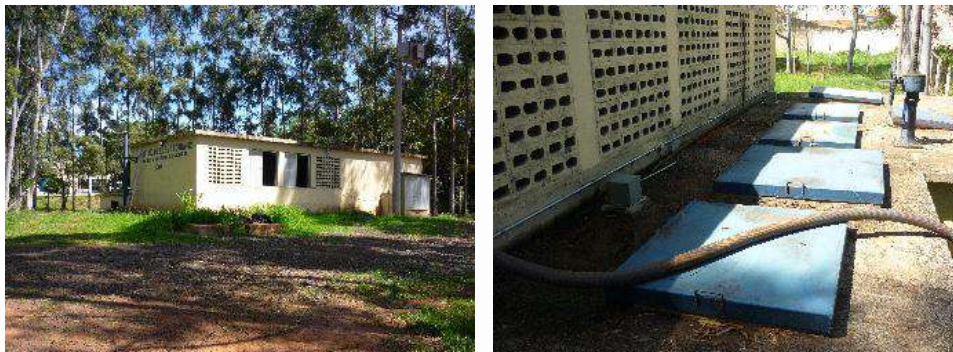
Figura 164 - Vista Posterior da EEE (esq.) e Inspeções dos Poços de Chegada de Esgotos (dir.)
