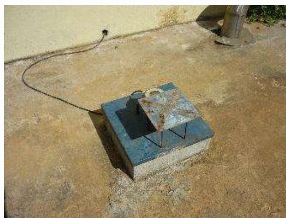
Figura 122 - Sensor Ultrassônico de Vazão - Esgoto Tratado para Saturação
