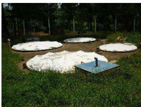
Figura 154 - Tanque de Decantação (esq.) e Leito de Secagem (dir.)
