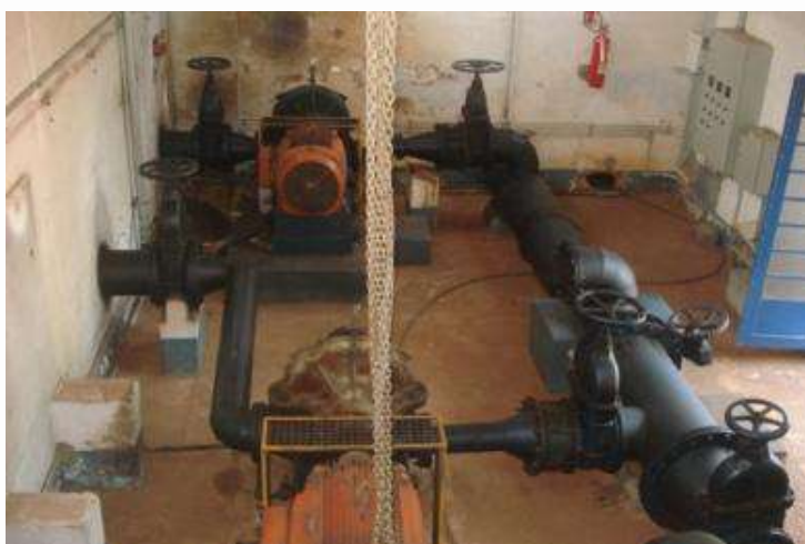
Figura 83 - Conjuntos moto-bomba
