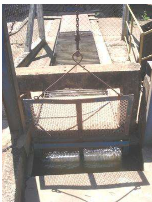
Figura 26 - Primeiro Gradeamento (esq.) e Segundo Gradeamento (dir.)
