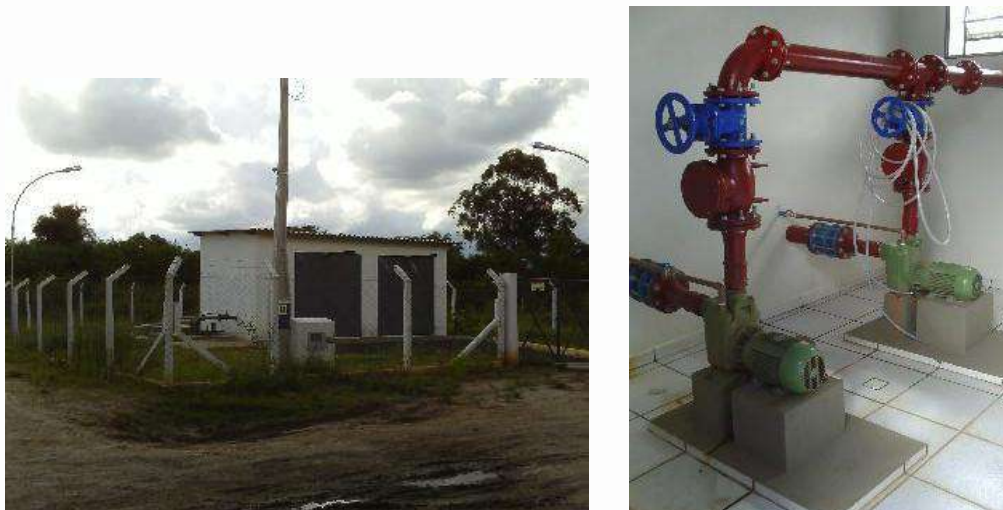
Figura 174 - Vista Geral da EEE (esq.) e Detalhe dos Conjuntos Moto Bombas (dir.)
