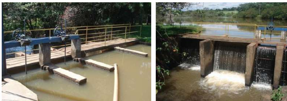
Figura 24 - Vista da Barragem de Montante (esq.) e Jusante (dir.)
