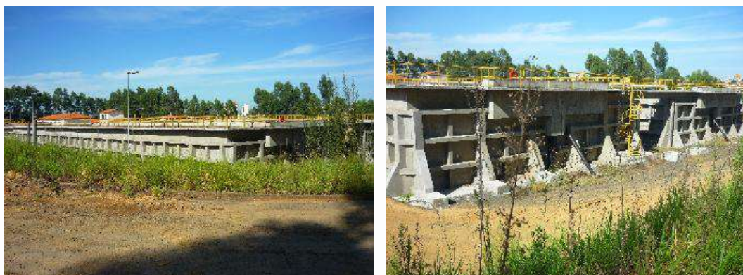
Figura 110 - Vista Geral e Lateral dos Tanques de Aeração
