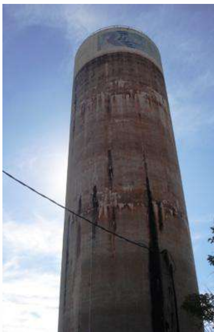
Figura 78 - Reservatório 31 de Março
