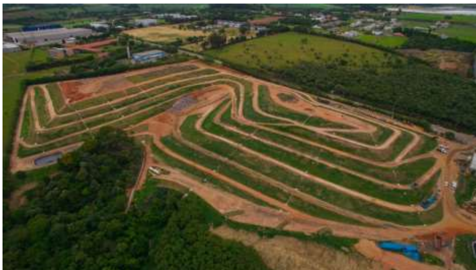
Figura 43 - Vista área do Aterro Sanitário. Fonte: CSO Ambiental, 2018.
