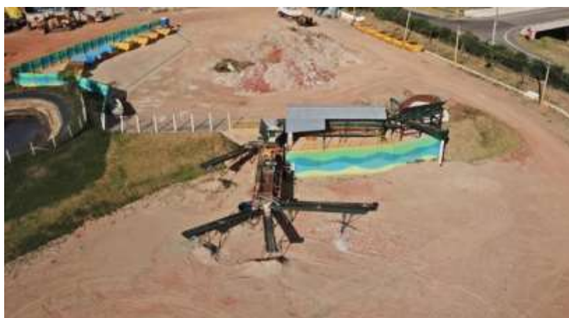
Figura 16- Usina de Valorização de Resíduos da Construção Civil, 2019.
