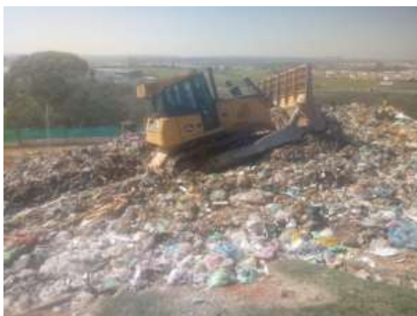
Figura 49- Frente de descarga. Fonte: CSO Ambiental, 2019
