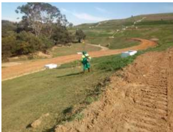
Figura 58- Roçada mecanizada para manutenção dos taludes. Fonte: CSO Ambiental, 2019.
