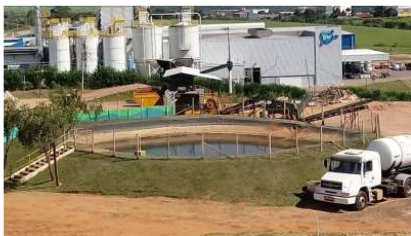
Figura 47 - Reservatório de líquidos percolados nº 1. Fonte: CSO Ambiental, 2019
