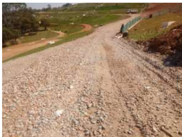
Figura 46- Estrada de acesso à área de aterramento. Fonte: CSO Ambiental, 2019
