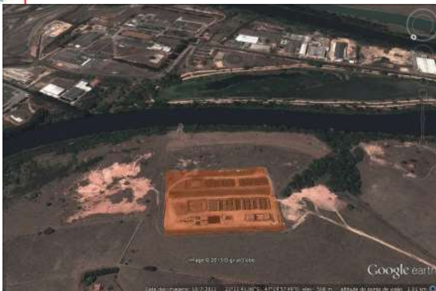
Figura 14- Estação de Tratamento de esgoto operada pela SANESALTO.
