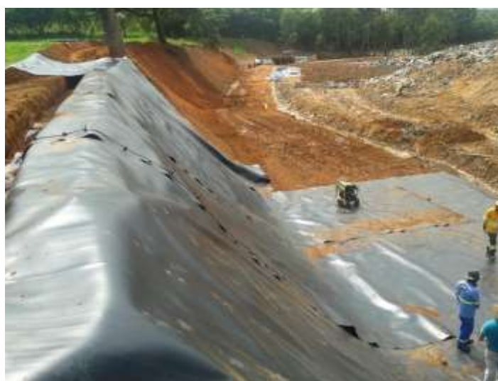
Figura 57 - Obra de impermeabilização com geomembrana PEAD. Fonte: CSO Ambiental, 2019.
