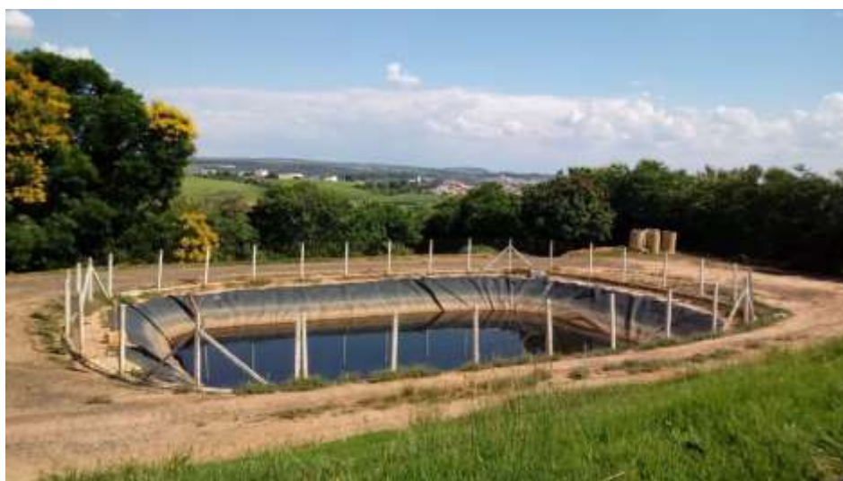
Figura 48- Reservatório de líquidos percolados nº 2. Fonte: CSO Ambiental, 2019
