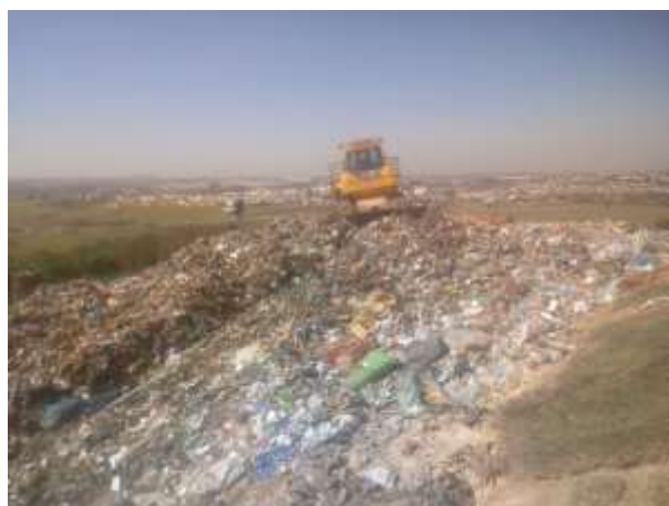
Figura 55 - Compactação com trator de esteira na frente de descarga. Fonte: CSO Ambiental, 2019.
