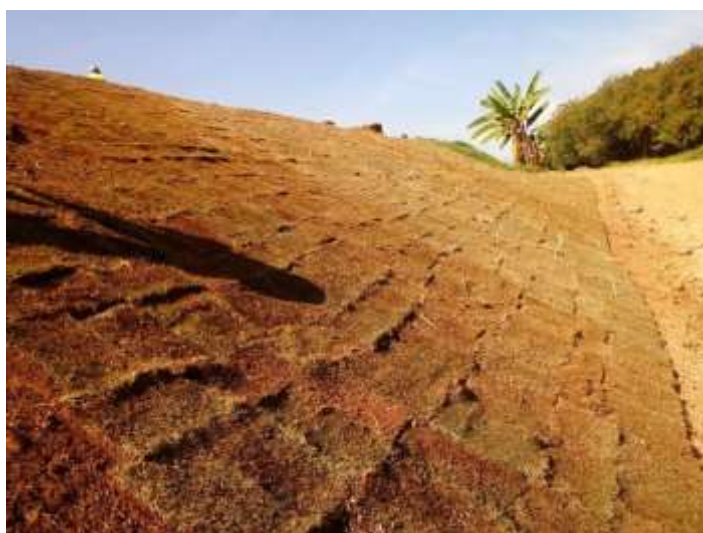
Figura 45- Plantio de gramas no talude. Fonte: CSO Ambiental, 2019
