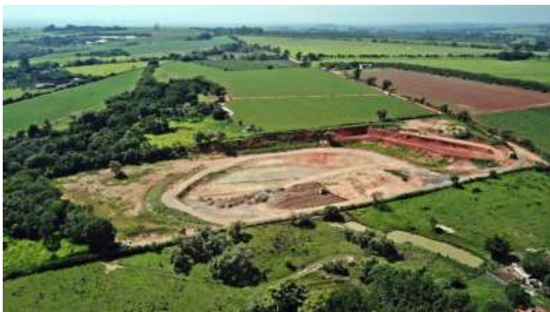
Figura 17 - Aterro de Inertes Chapada, 2019
