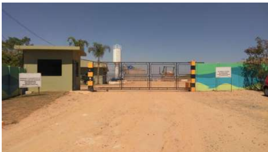
Figura 60- Fachada do Aterro Sanitário. Fonte: CSO Ambiental, 2019.
