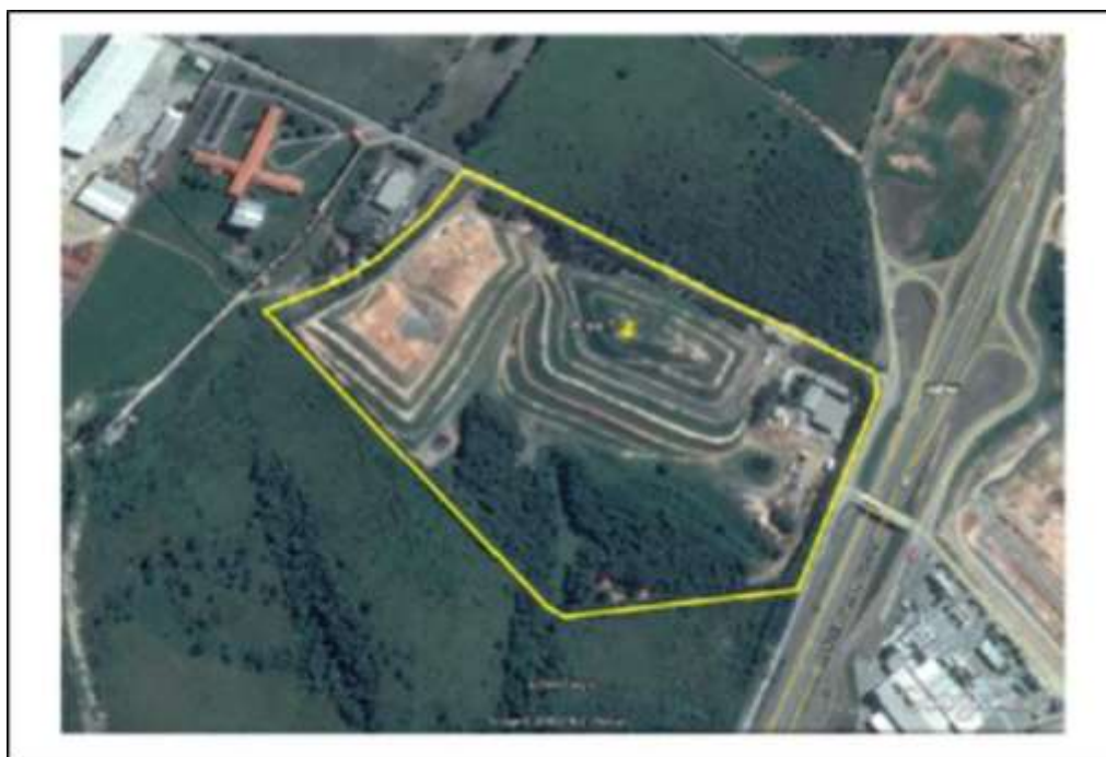
Figura 8- Área do Aterro Sanitário, 2019.
