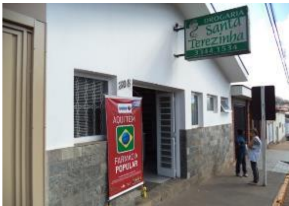
Figura 131. Fachada da Drogaria Santa Teresinha
