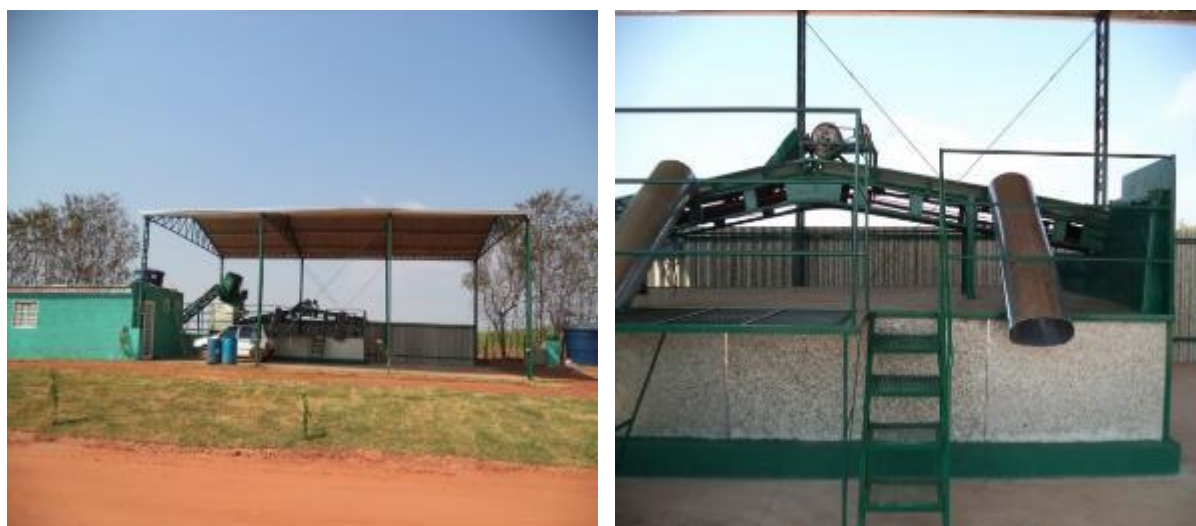
Figura 78. Barracão em estágio de finalização com respectivos equipamentos
