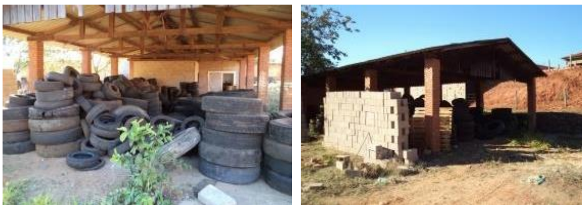
Figura 171. Ecoponto dos pneumáticos - Chacarazinha
