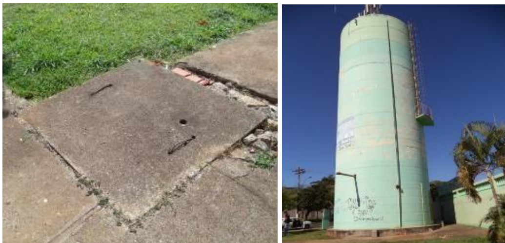
Figura 34. Poço 5 (P5) e Reservatório 5 (R5)
