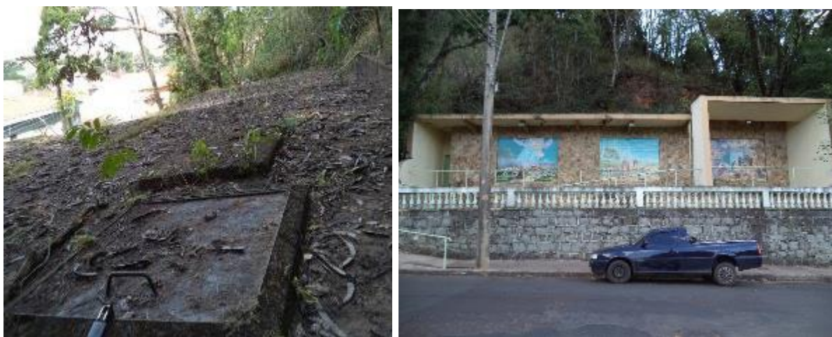
Figura 46. Reservatório 9 (R9) – Vista Superior e Fachada
