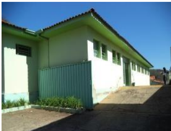
Figura 121. Fachada do CEM César Torrezan
