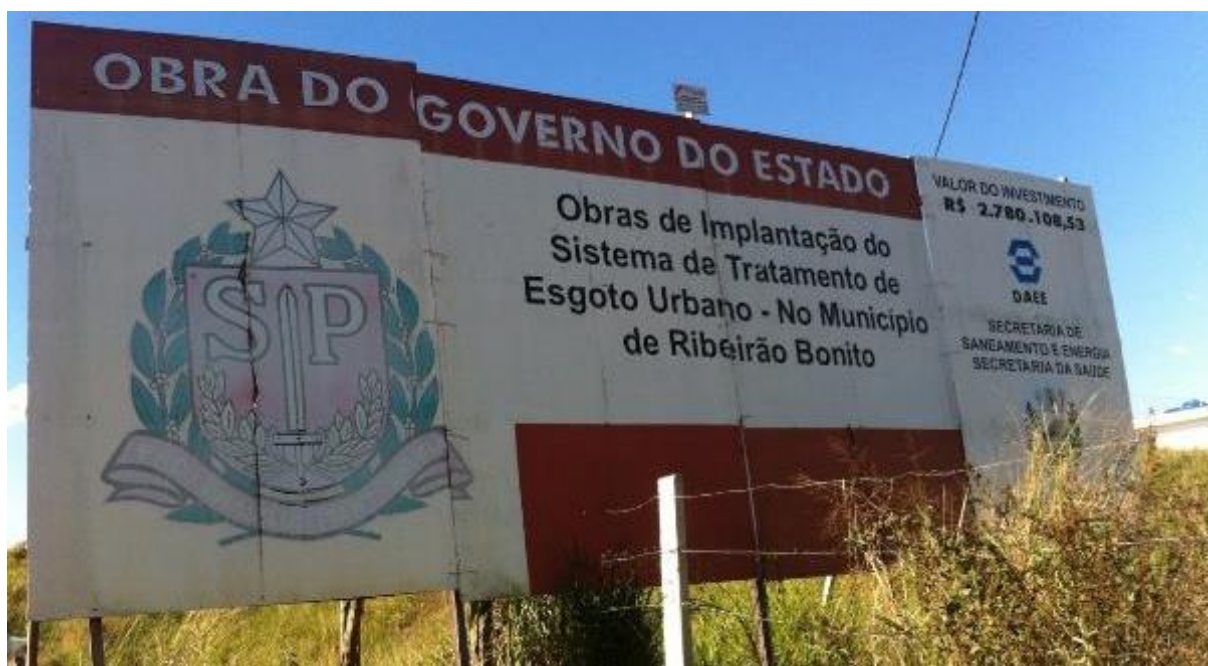
Figura 57. Sinalização da obra de implantação do Sistema de Tratamento de Esgoto em Ribeirão Bonito
