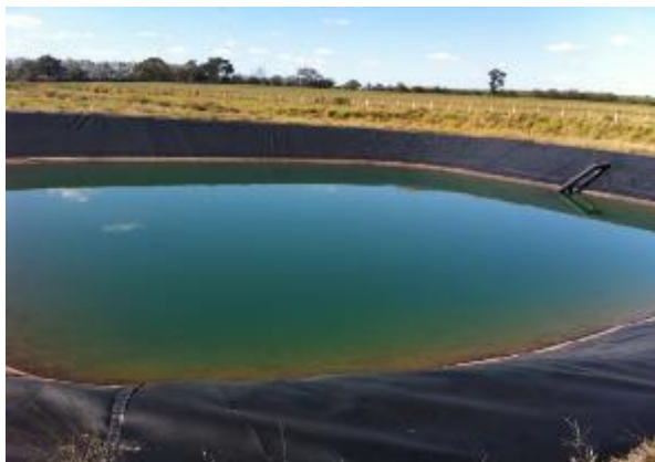
Figura 60. Lagoas anaeróbias
