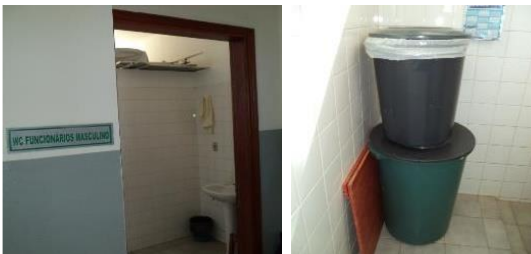
Figura 111. Local de acondicionamento dos resíduos no PSF Luiz Carlos Monteiro Novo I e II
