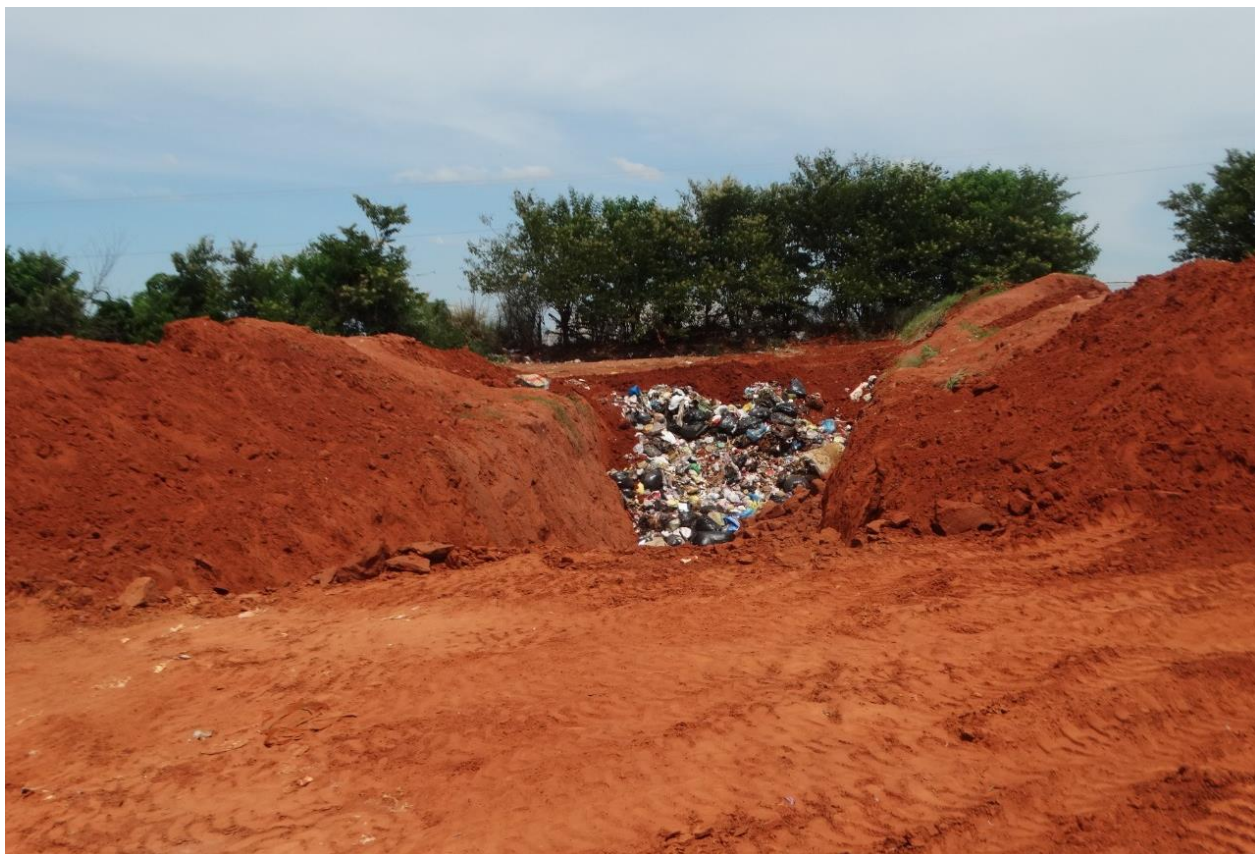
Imagem 14 – valas em operação do aterro sanitário municipal de Queiroz.
