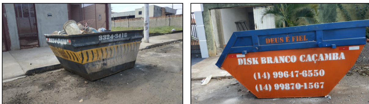
Figura 17 – Armazenamento de RCC
