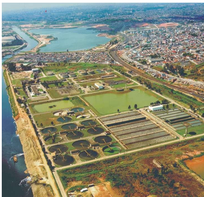
Figura 16. Vista aérea da ETE Barueri
