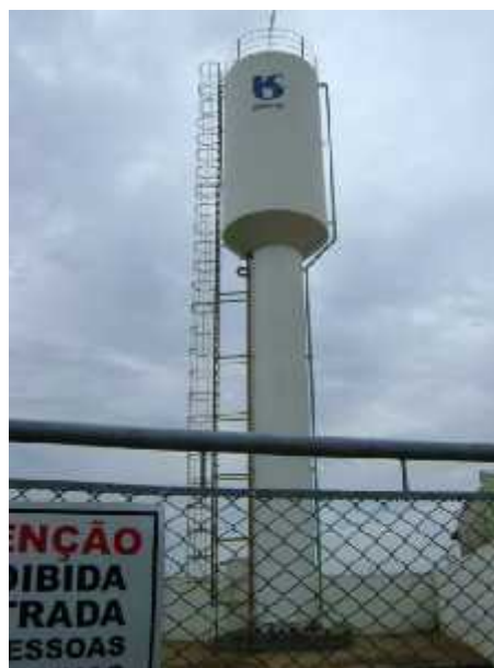
Figura 14- Reservatório elevado do bairro José P. Lima
