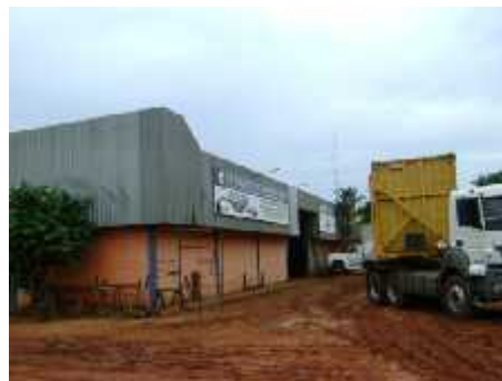
Figura 31- Região onde não existe rede coletora de esgoto
