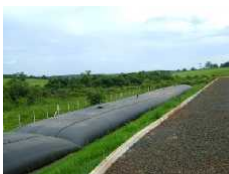
Figura 28- Detalhe das bag que armazenam o lodo
