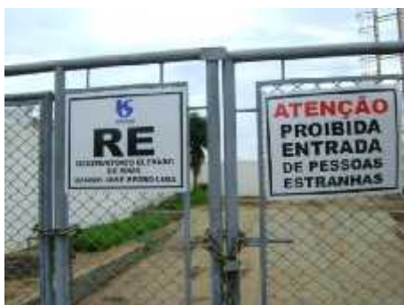
Figura 13- Reservatório elevado do bairro José P. Lima
