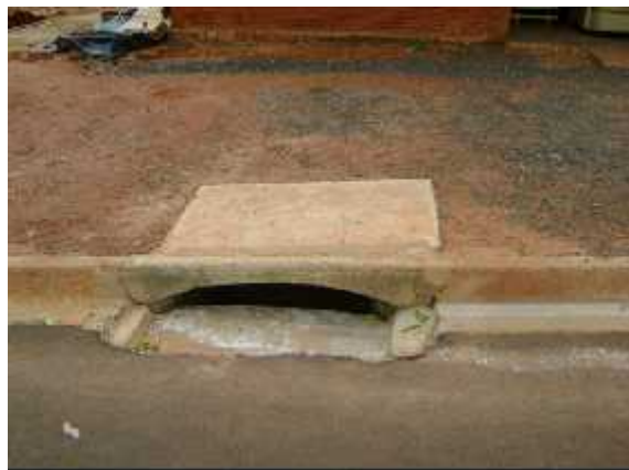
Fotos 41 42 Equipamentos de drenagem, canal de drenagem em processo erosivo
