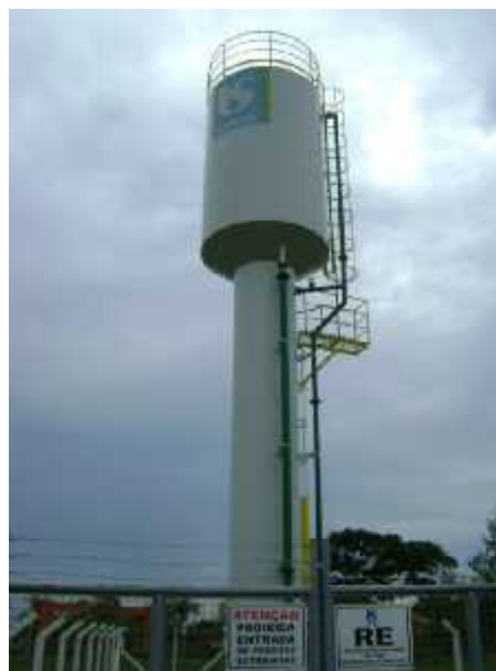
Figura 16- Reservatório elevado do bairro Flamboyant
