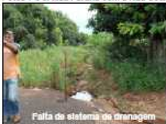
Fotos 7 e 8. Rua Paraná com a Rua Ceará
