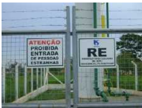
Figura 15- Reservatório elevado do bairro Flamboyant
