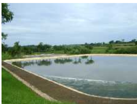
Figura 27- Estação de Tratamento de Esgoto
