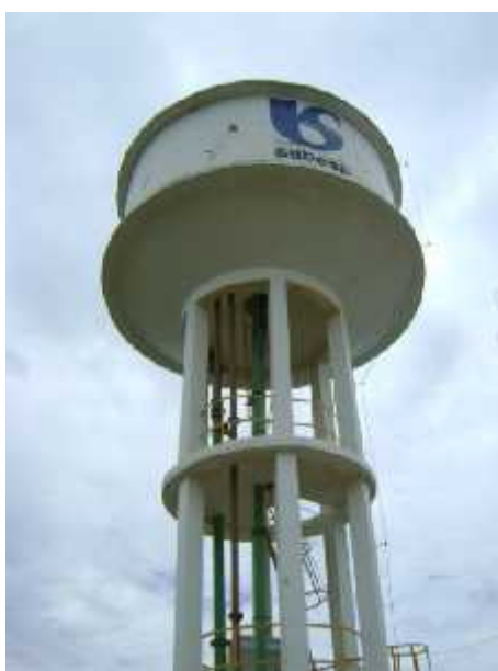
Figura 5- Reservatório elevado (taça)
