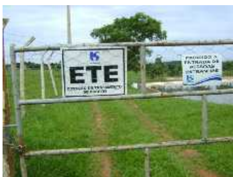
Figura 26- Estação de Tratamento de Esgoto
