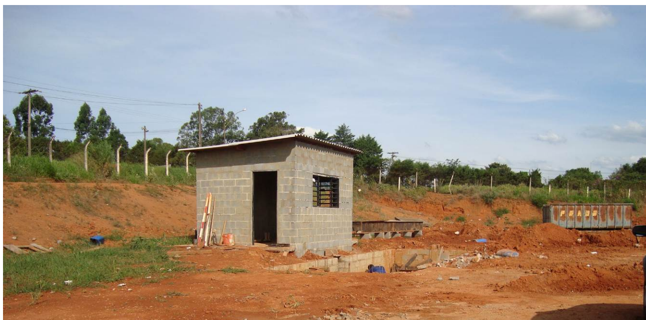
FIGURA 134. Área impermeabilizada onde ocorre o transbordo
