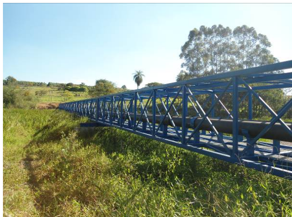
FIGURA 101. Travessia da Adutora de Água Bruta .
