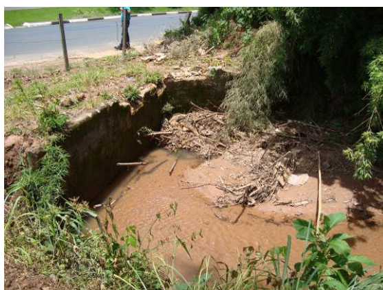
FIGURA 166. Montante da travessia do Ponto P16, tubulação DN 600 obstruída e local assoreado.
