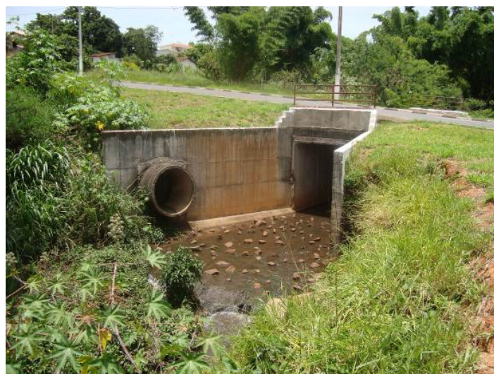
FIGURA 171. Jusante – travessia Ponto P20.
