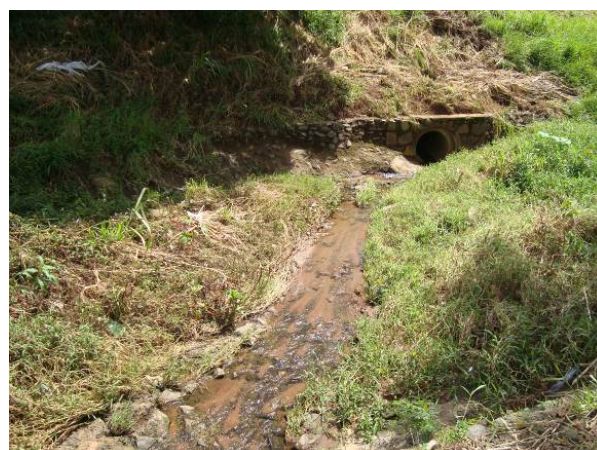
FIGURA 136. Falta de manutenção fez com que desenvolvesse vegetação no local – Ponto P01.
