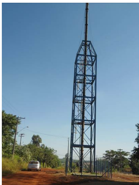
FIGURA 102. Stand Pipe na Adutora de Água Bruta.
