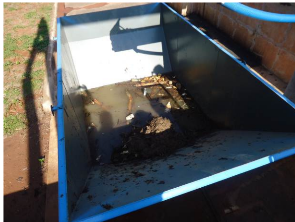
FIGURA 124. Chegada do Esgoto Bruto na ETE Mogi Mirim e Tratamento Preliminar.
