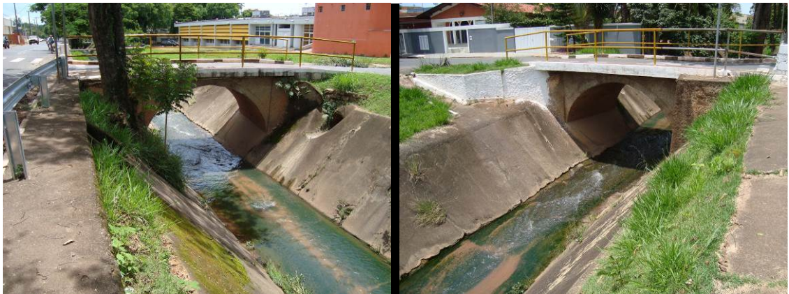
FIGURA 162. Travessia Ponto P14.
