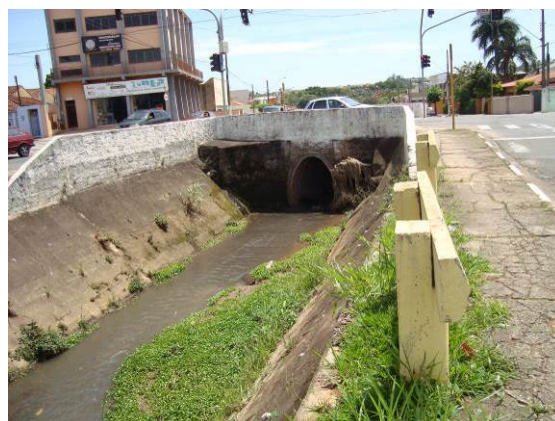
FIGURA 144. Chegada com canal trapezoidal – Ponto P04.
