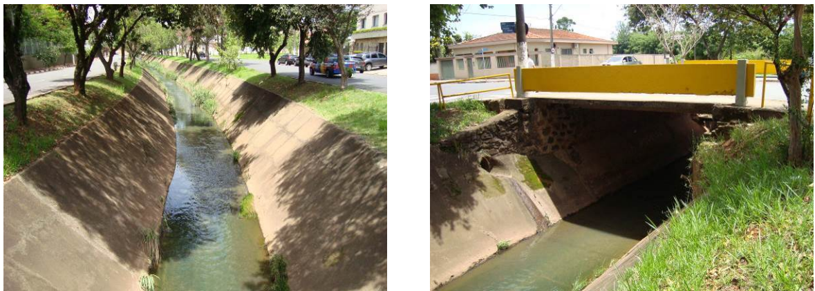
FIGURA 157. Montante travessia Ponto P11A.
