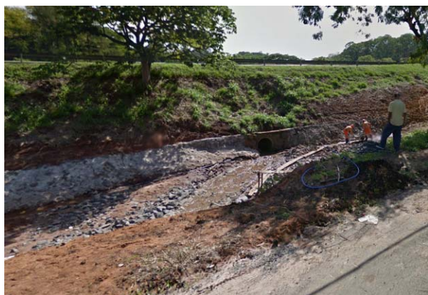
FIGURA 135. Execução da bacia de contenção com rachão revestido com concreto magro e tubulação da travessia DN 800mm – Ponto P01.
