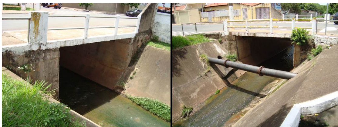
FIGURA 159. Travessia Ponto P12.
