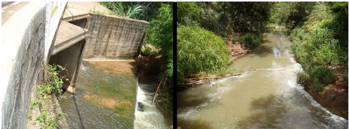
FIGURA 156. Jusante travessia Ponto P11.
