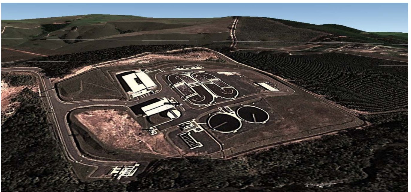
FIGURA 75. Localização da ETE Mogi Mirim.
