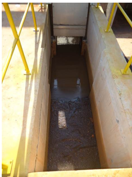
FIGURA 123. Chegada do Esgoto Bruto na ETE Mogi Mirim e Tratamento Preliminar.
