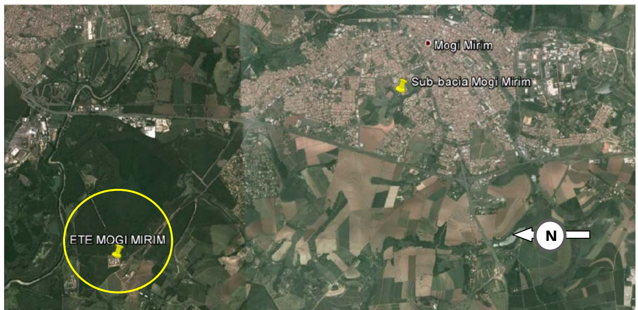
FIGURA 73. Localização da ETE Mogi Mirim.
