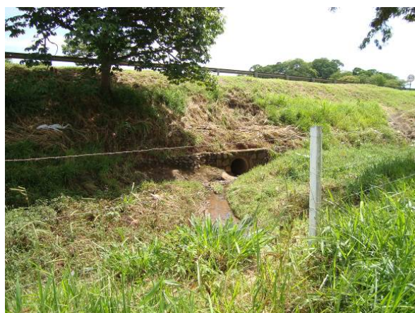
FIGURA 136. Falta de manutenção fez com que desenvolvesse vegetação no local – Ponto P01.
