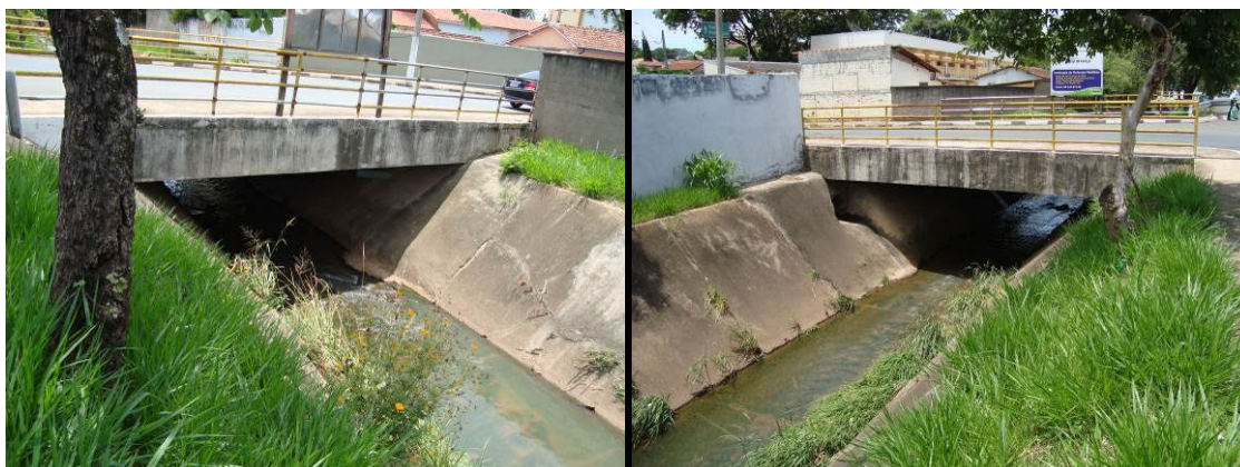
FIGURA 160. Travessia Ponto P13.
