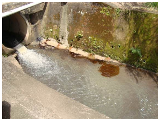
FIGURA 143. Lançamento de efluente no canal de drenagem de águas pluviais – Ponto P03.
