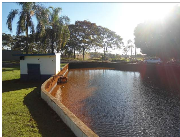
FIGURA 106. Sistema de recuperação de água de limpeza dos filtros da ETA 1 – Morro Vermelho.
