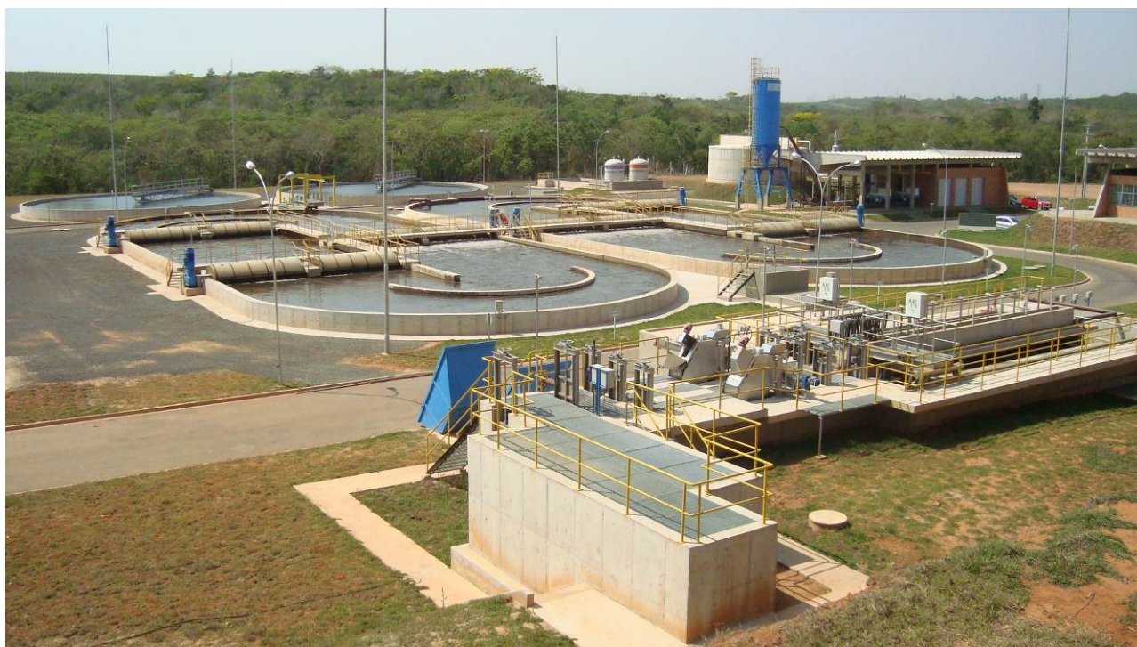
FIGURA 122. Vista geral da ETE Mogi Mirim.
