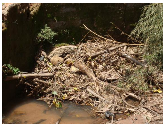
FIGURA 166. Montante da travessia do Ponto P16, tubulação DN 600 obstruída e local assoreado.
