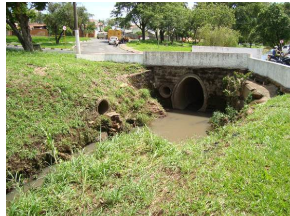
FIGURA 142. Travessias de esgoto ao longo do canal – Ponto P03.
