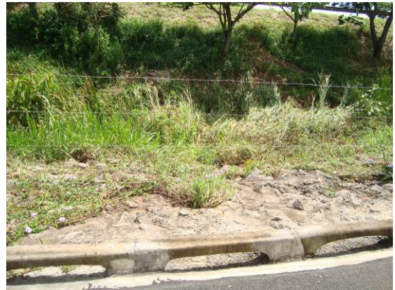
FIGURA 138. Passagens diretas da guia para bacia de contenção – Ponto P01.
