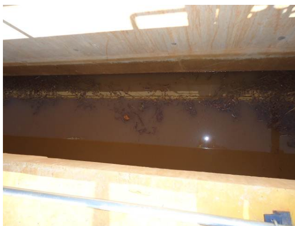
FIGURA 123. Chegada do Esgoto Bruto na ETE Mogi Mirim e Tratamento Preliminar.
