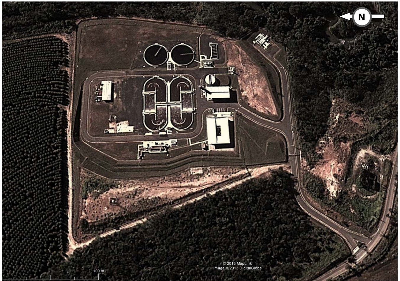
FIGURA 74. Localização da ETE Mogi Mirim.
