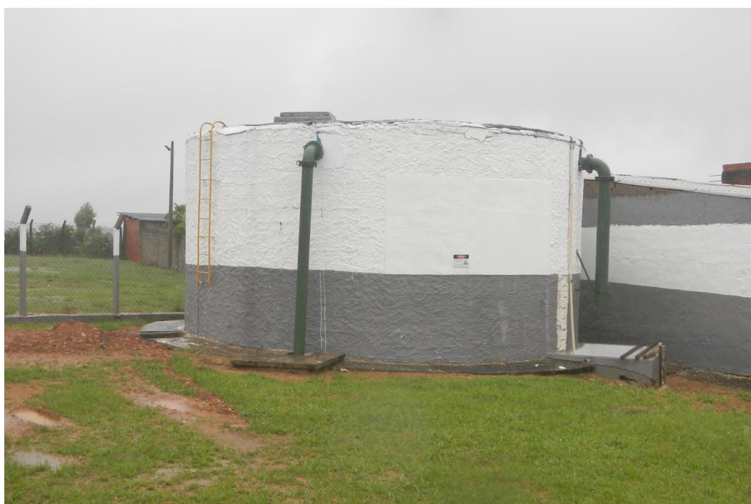
Vista do reservatório pertinente ao CR Flora.
