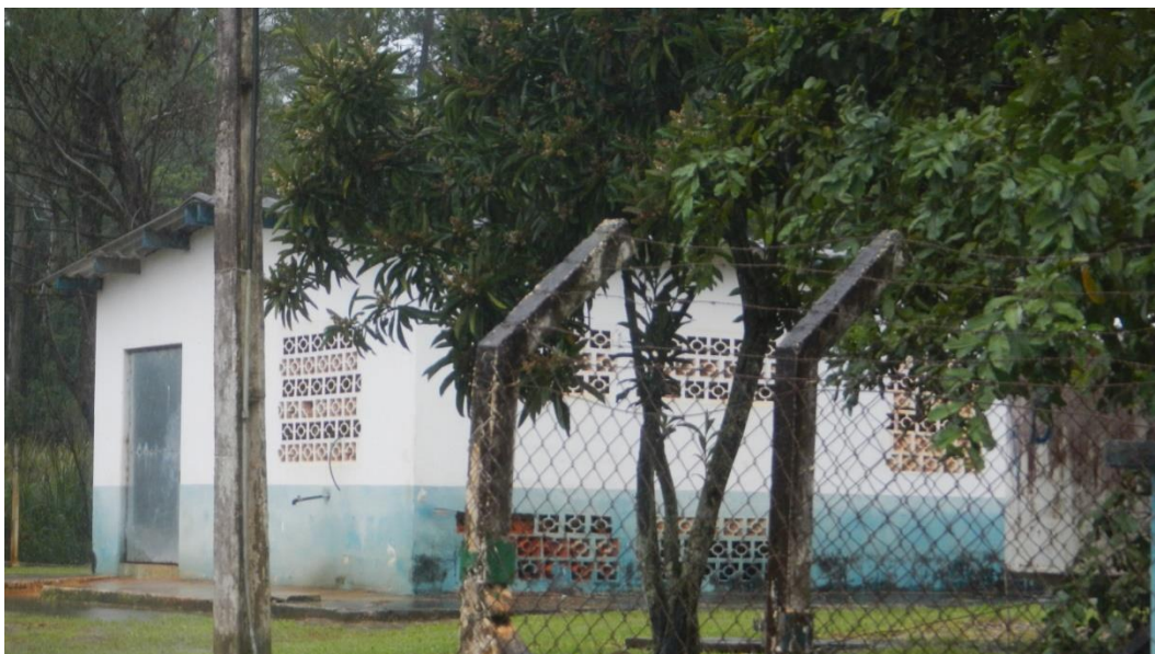
Vista Externa da EEAT Vitória ZB.
