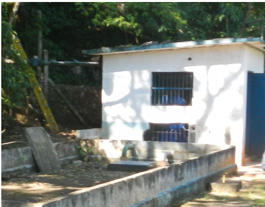
Vista das Instalações do Poço P-19.
