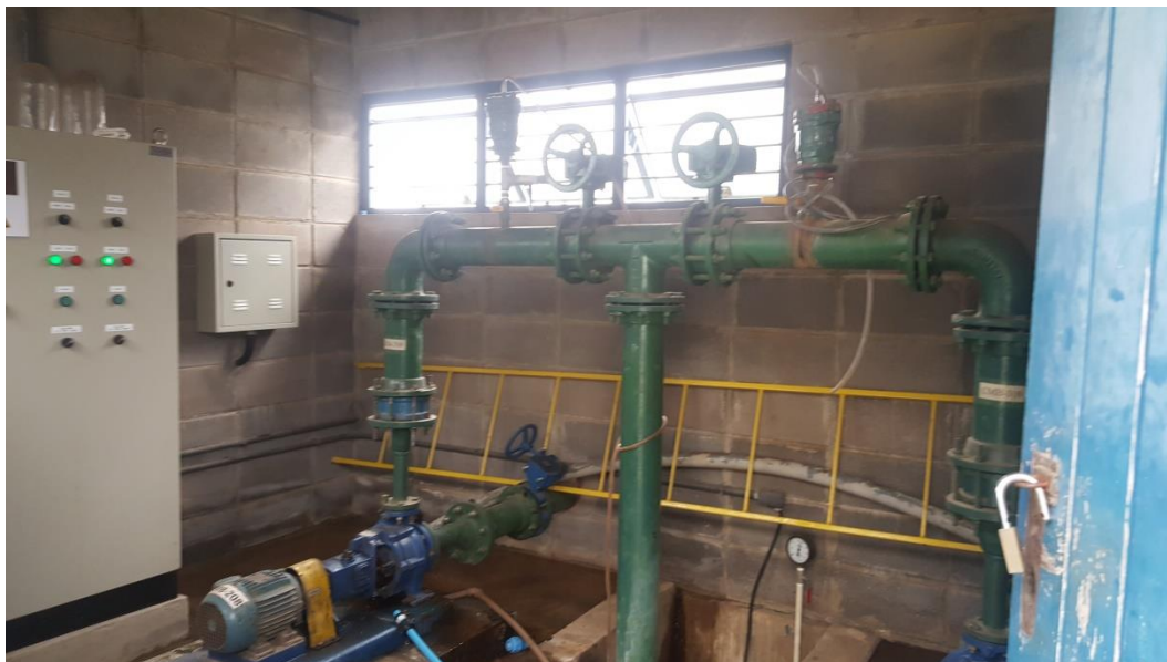
Vista do conjunto de Moto-bombas que compõem a EEAT – CR CECAP.
