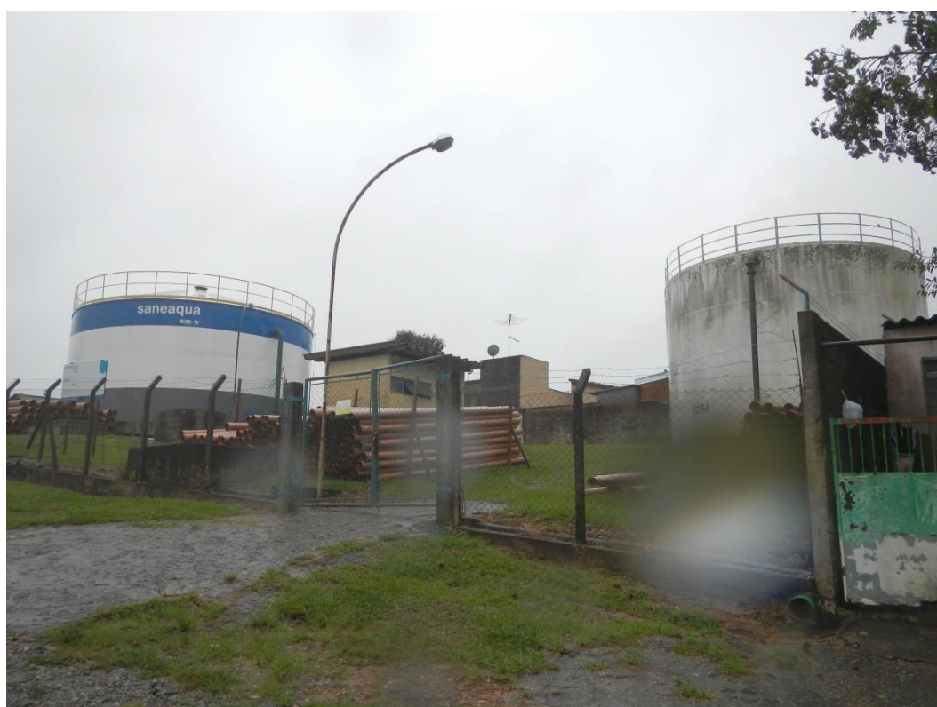
Vista do conjunto de reservatórios pertinentes ao CR CECAP.
