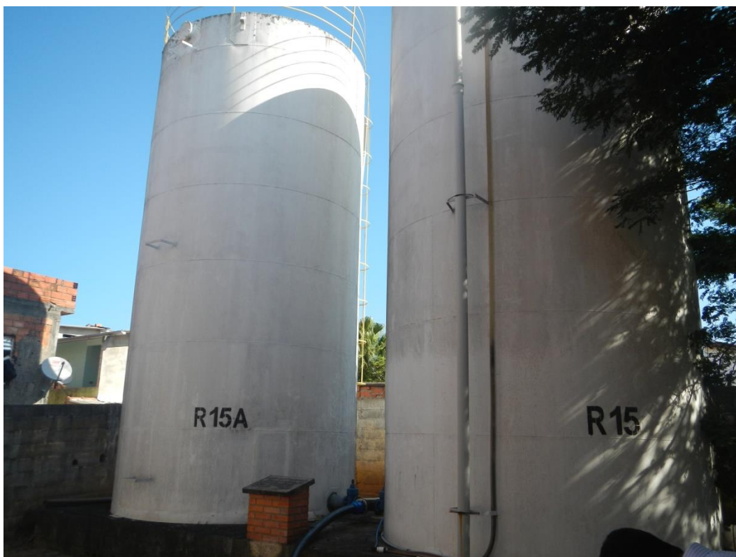
Vista do Reservatório CR Haydée
