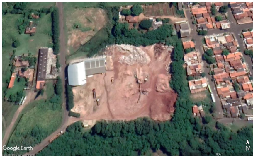
Figura 59. Imagem aérea da usina de reciclagem de RCC BR 189.
