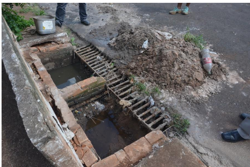
Figura 45. Limpeza de boca de lobo realizada pela SAECIL.
