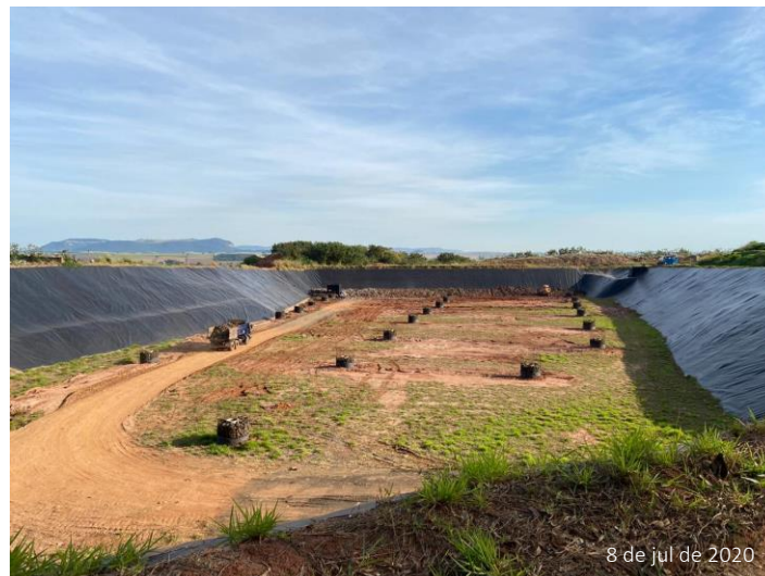
Figura 20. Vala do Aterro Sanitário de Leme atualmente em operação.
