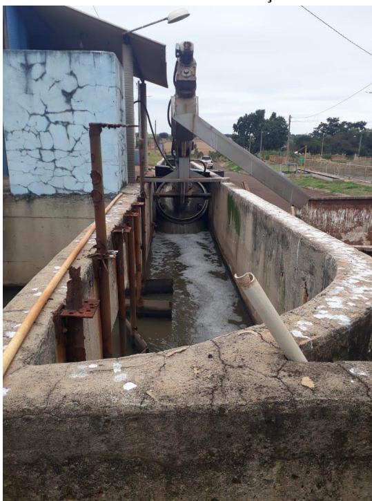
Figura 151 - Bomba parafuso de eixo rotativo
