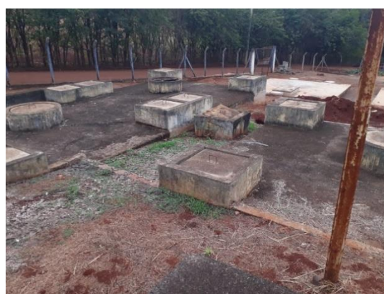
Figura 187 - Fossa séptica e filtros anaeróbios
