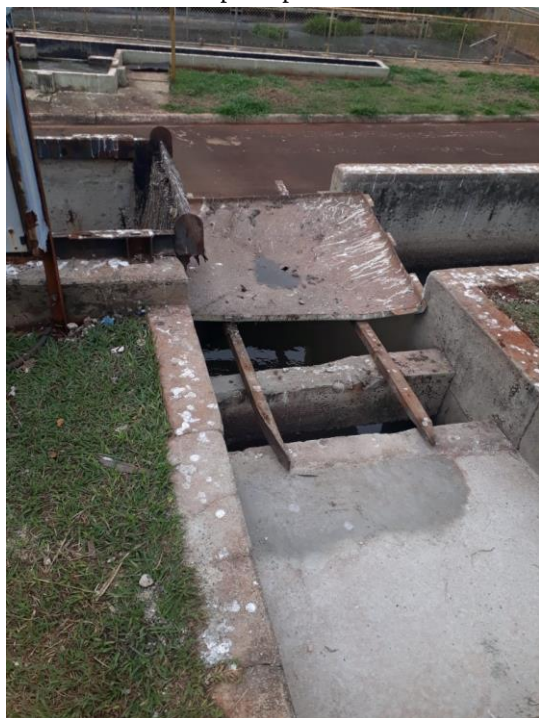
Figura 150 - Gradeamento e caixa de areia
