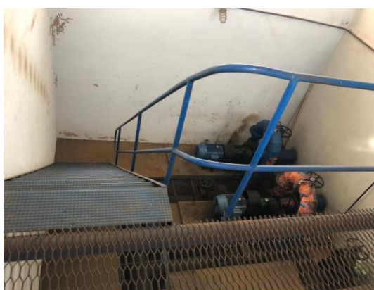
Figura 79 - Escada de acesso – EEAT – ETA
