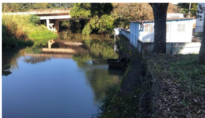
Figura 8 - Barragem e captação superficial – Córrego Rico
