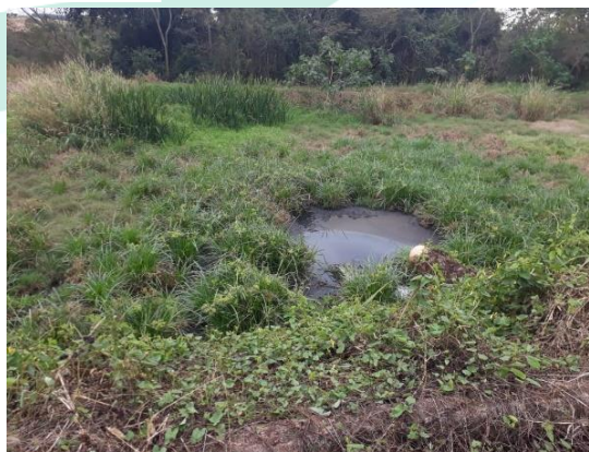
Figura 176 - Lagoa de secagem de lodo saturada, com vegetação
