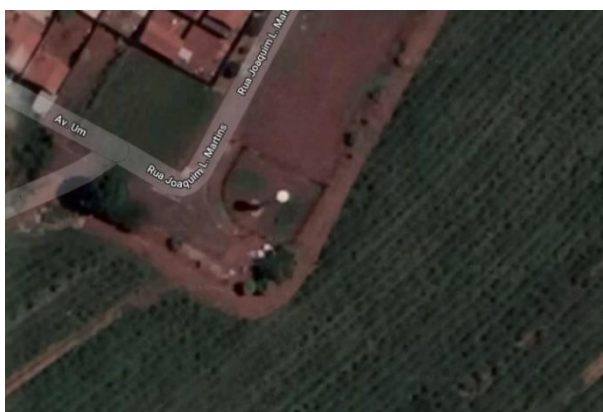
Figura 124 - Reservatório elevado de Lusitânia - Fonte: Google Maps
