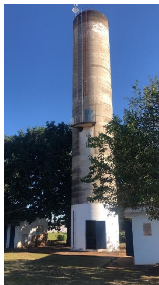
Figura 99 - Reservatório elevado COHAB I
