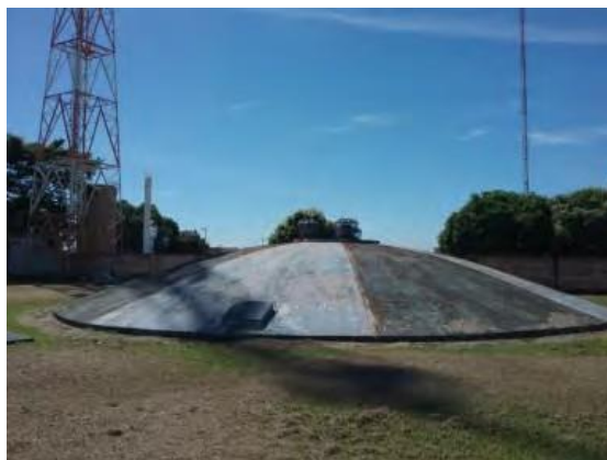
Figura 86 - Reservatório enterrado ETA – Fonte: ARES PCJ (2018)
