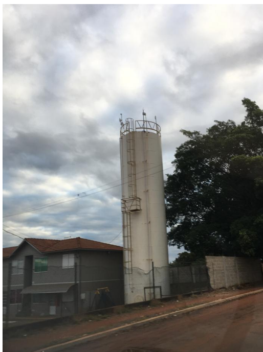
Figura 112 - Reservatório apoiado loteamento Vida Nova II
