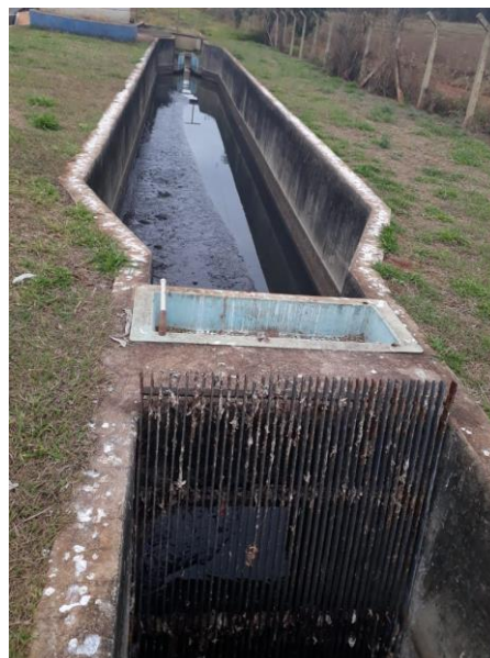
Figura 147 - Gradeamento e caixa de areia reserva
