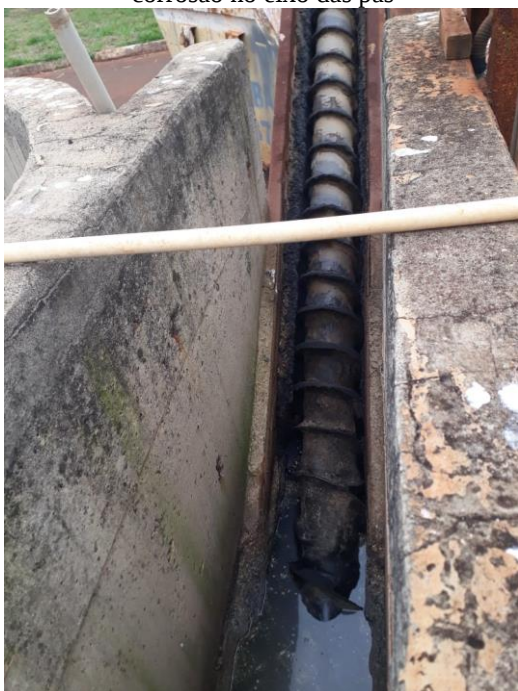
Figura 154 - Eixo de bomba parafuso
