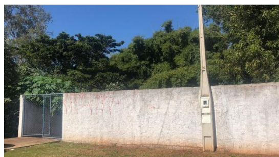
Figura 135 - Estação Elevatória de Esgoto – Athenas Paulista II
