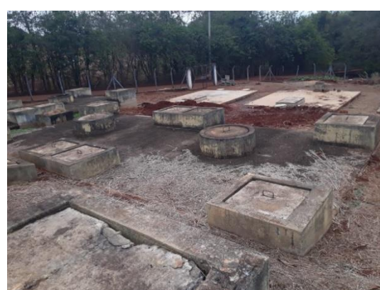
Figura 189 - Fossa séptica e filtros anaeróbios
