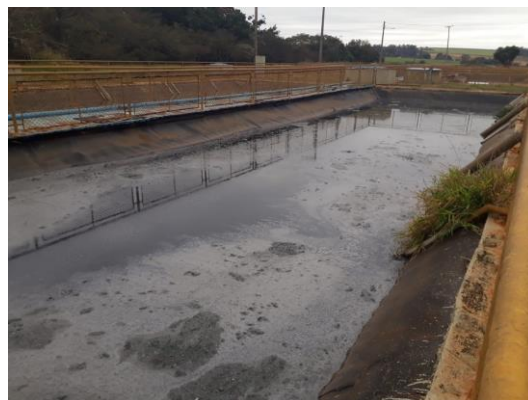
Figura 165 - DAFA com camada de sobrenadante
