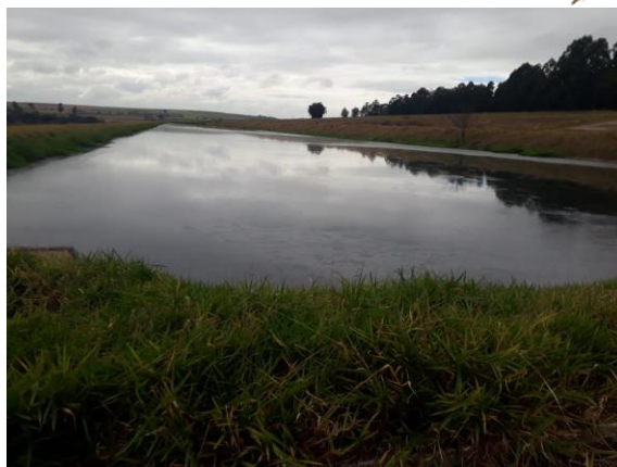
Figura 171 - Lagoa Facultativa, presença de vegetação nos taludes internos
