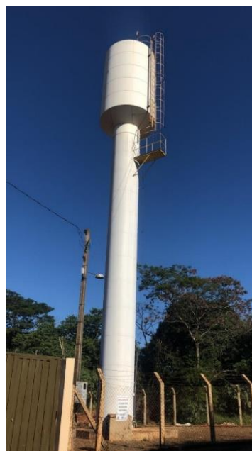
Figura 101 - Reservatório elevado Residencial Jaboticabal
