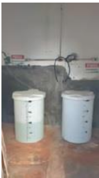
Figura 121- Aplicação de hipoclorito e flúor no poço Córrego Rico Reservatório Fonte: ARES PCJ (2018)
