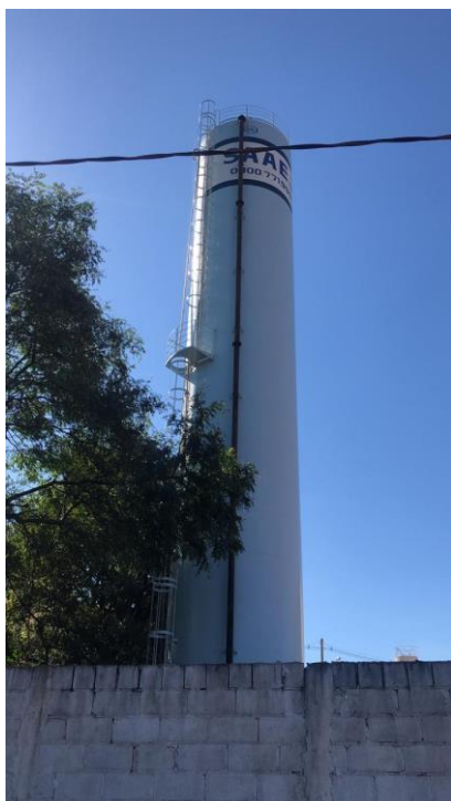
Figura 108 - Reservatório elevado Athenas Paulista II
