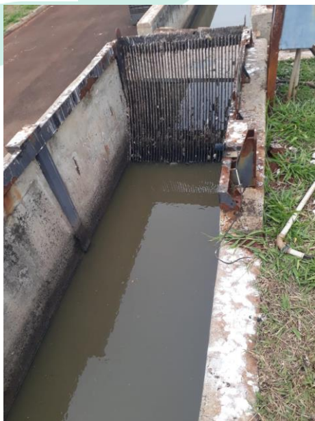
Figura 148 - Gradeamento e caixa de areia principal
