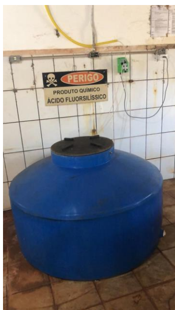
Figura 31 - Dosagem de ácido Fluorsilícico para o Poço de Estiva I
