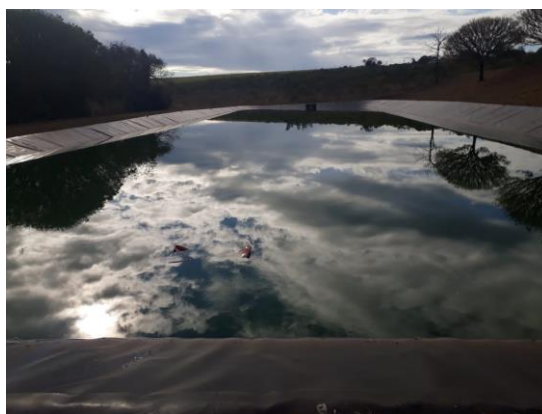
Figura 205 - Lagoa de maturação desnivelada
