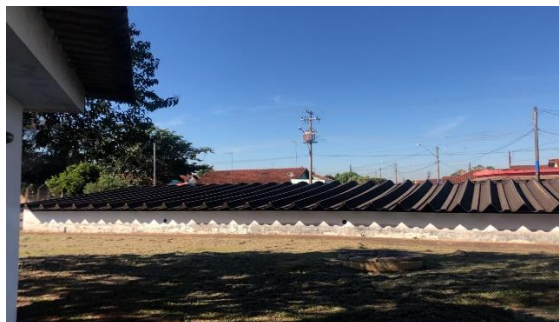
Figura 98 - Reservatório enterrado COHAB I
