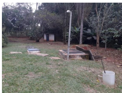
Figura 22 - Vista geral da área de captação dos drenos de Estiva
