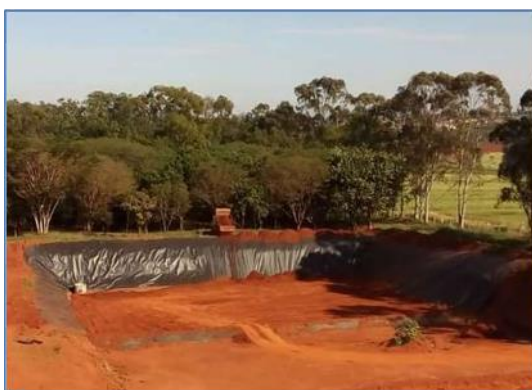
Figura 210 - Aterro Sanitário de Jaboticabal Fonte: PIMRS, 2019.
