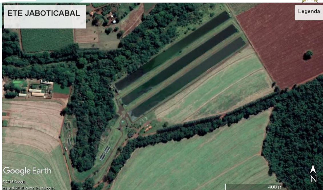
Figura 145 - ETE do distrito Sede - Fonte: Google Earth
