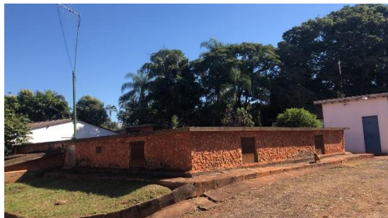
Figura 102 - Reservatório semienterrado José da Costa – Estiva
