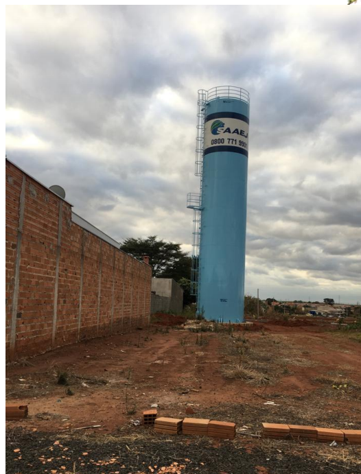
Figura 115 - Reservatório apoiado loteamento Morada Nova I sem cercamento
