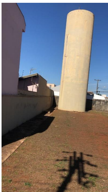
Figura 104 - Reservatório elevado Jd. São Marcos
