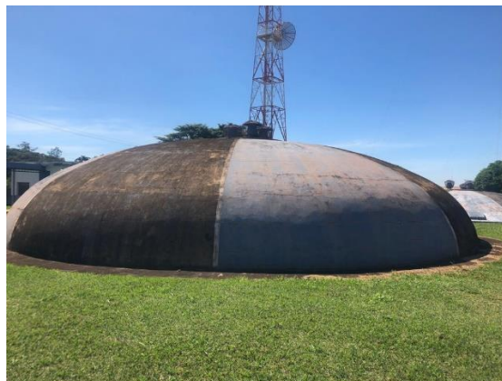
Figura 87 - Reservatório enterrado ETA
