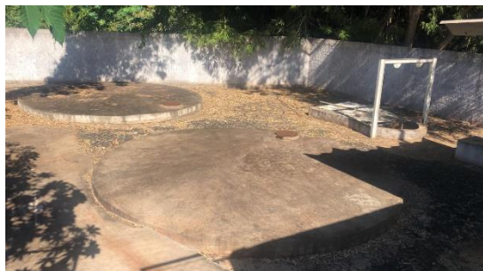
Figura 133 - Estação Elevatória de Esgoto – Athenas Paulista II
