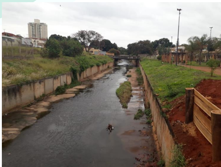
Figura 230 – Ponte por onde passa o Rio Cerradinho, onde ocorreu a tragédia em 1999.
