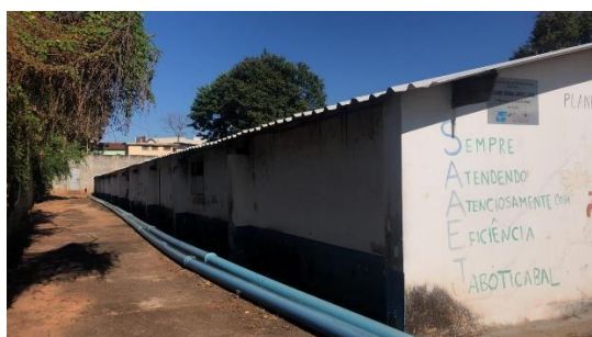
Figura 92 - Exterior do reservatório semienterrado manta PEAD – Bairro Alto
