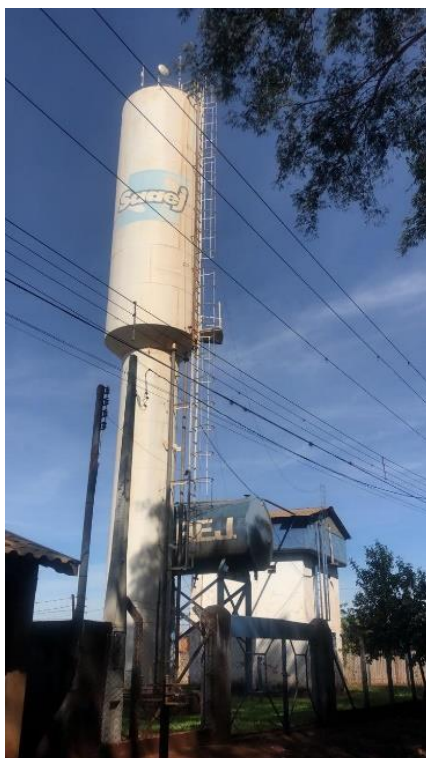
Figura 122 - Reservatórios elevados de Córrego Rico
