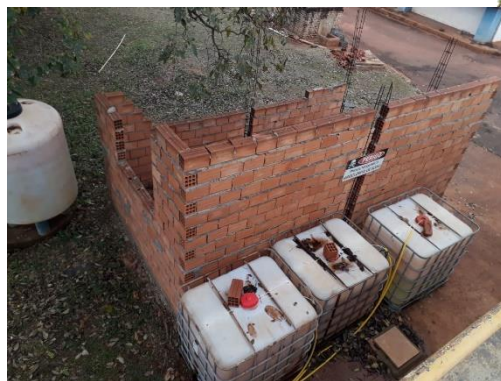
Figura 46 - Estocagem Inadequada dos produtos químicos
