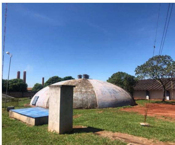
Figura 90 - Reservatório enterrado ETA
