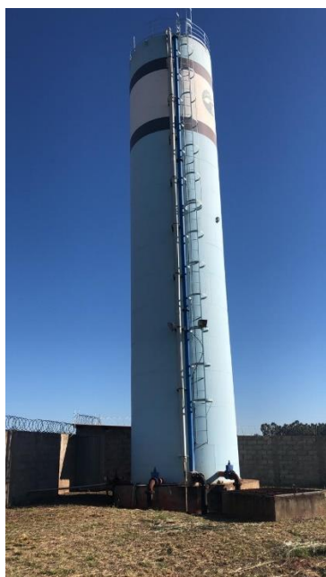
Figura 96 - Reservatório elevado Distrito Industrial
