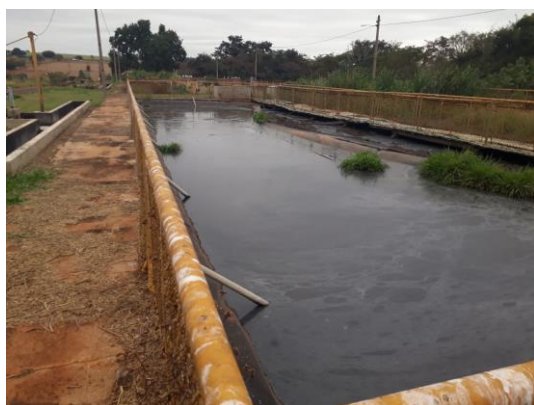
Figura 156 - DAFA com vegetação, camada de sobrenadante, estrutura em ruínas
