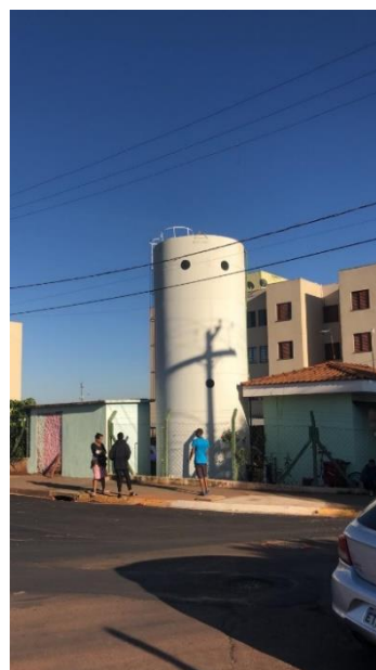
Figura 105 - Reservatório COHAB I
