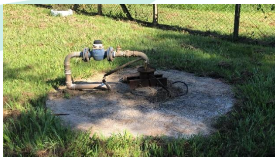
Figura 33 - Poço II Estiva
