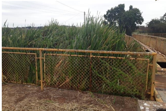
Figura 159 - DAFA saturado com vegetação de taboas
