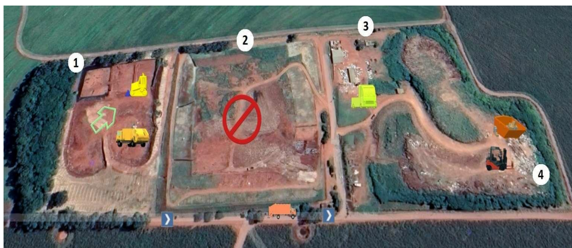
Figura 212 - Vista aérea do aterro sanitário de Jaboticabal, sendo 1 (Célula 4 em Operação), 2 (Célula 1, 2 e 3 Encerradas), 3 (Área de Reciclagem) e 4 (Aterro de Inertes). Fonte: PIMRS, 2019.
