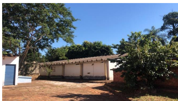
Figura 116 - Reservatório enterrado José da Costa – Estiva
