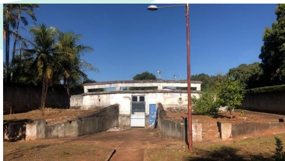
Figura 110 - Reservatório semienterrado circular Bairro Alto
