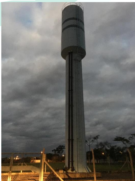
Figura 114 - Reservatório elevado Loteamento Parque dos Girassóis
