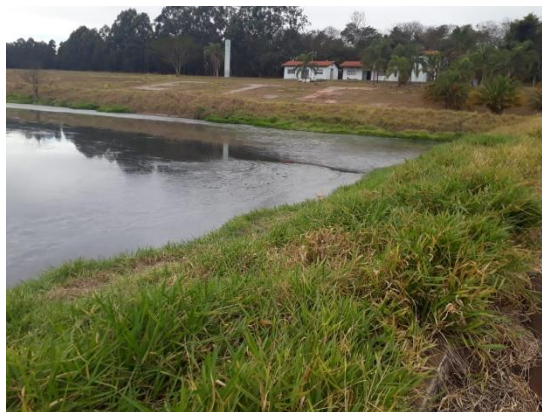
Figura 172 - Entrada da Lagoa Facultativa, com camada de gordura
