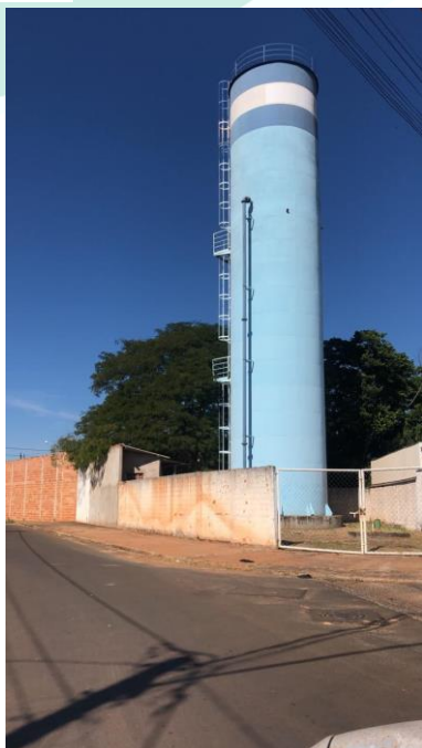
Figura 106 – Reservatório elevado Morada Nova II
