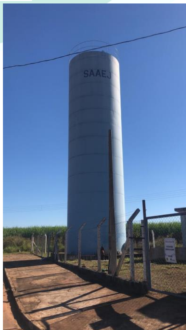
Figura 94 - Reservatório elevado Morada do Campo
