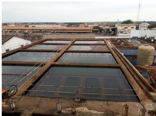
Figura 35 - Vista geral da ETA
