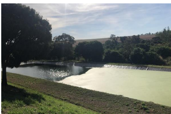
Figura 202 - Lagoa de maturação com camada de sobre-nadante
