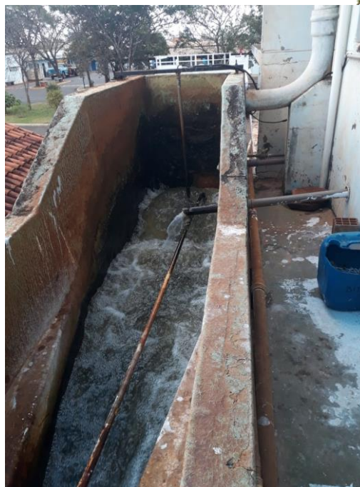
Figura 36 - Entrada de água na ETA
