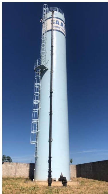
Figura 107 - Reservatório elevado Athenas Paulista I
