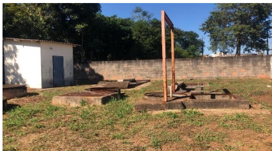
Figura 141- Estação Elevatória de Esgoto – Estiva
