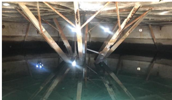
Figura 111- Interior Reservatório semienterrado circular Bairro Alto
