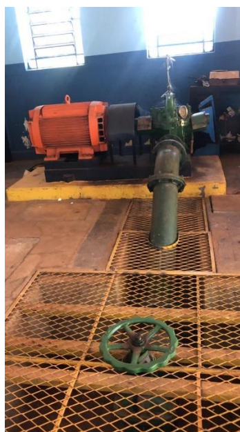
Figura 15 - Conjunto Motor-Bomba
