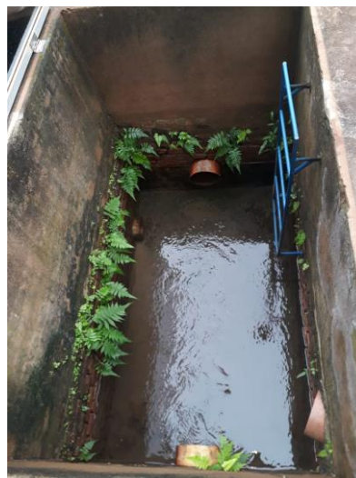
Figura 20 - Local de união do drenão e dreninho de Estiva
