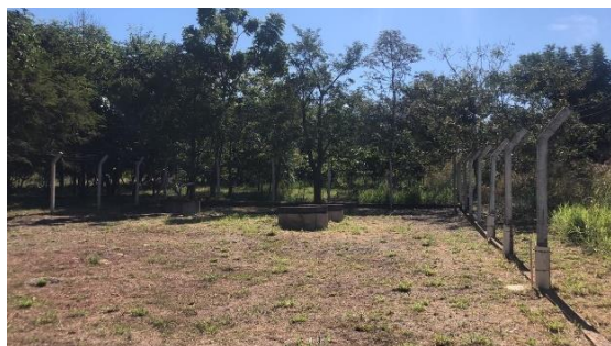
Figura 139 - Estação Elevatória de Esgoto – Jardim América
