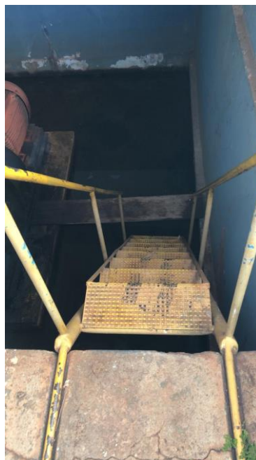
Figura 13 - Escada de acesso para as bombas
