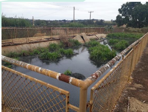
Figura 158 - DAFA com vegetação, camada de sobrenadante, estrutura em ruínas
