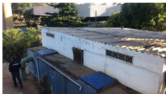
Figura 109 - Reservatório semienterrado Rodoviária
