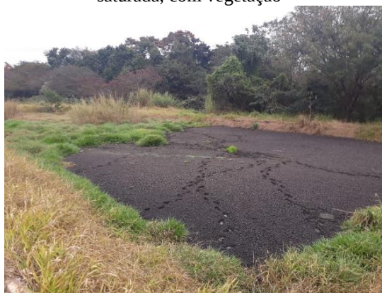
Figura 178 - Lagoa de secagem de lodo saturada com vegetação
