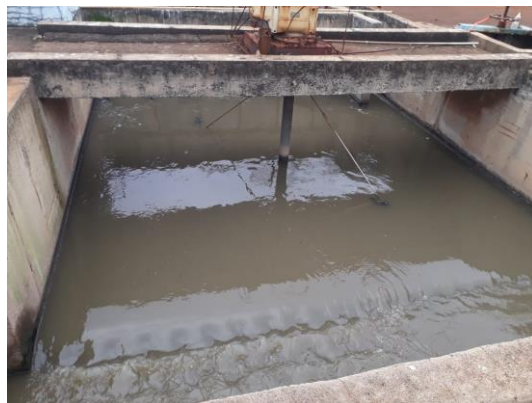
Figura 153 - Adensador de lodo de fundo
