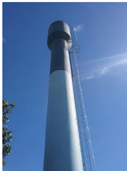
Figura 103 - Reservatório elevado Parque das Araras – Fonte: ARES PCJ (2018)
