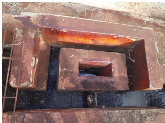
Figura 197 - Gradeamento e desvio do sistema de gradeamento
