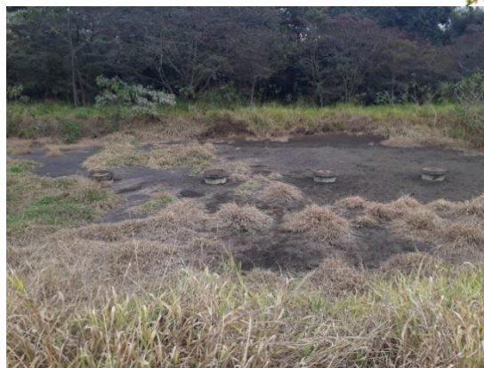
Figura 177 - Lagoa de secagem de lodo, com vegetação
