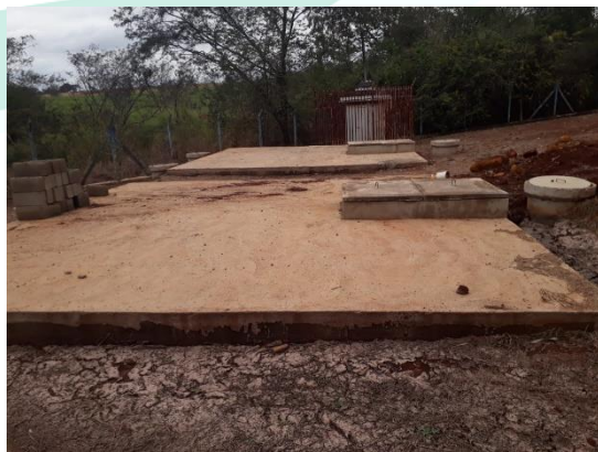
Figura 190 - Filtros anaeróbios de biobobs
