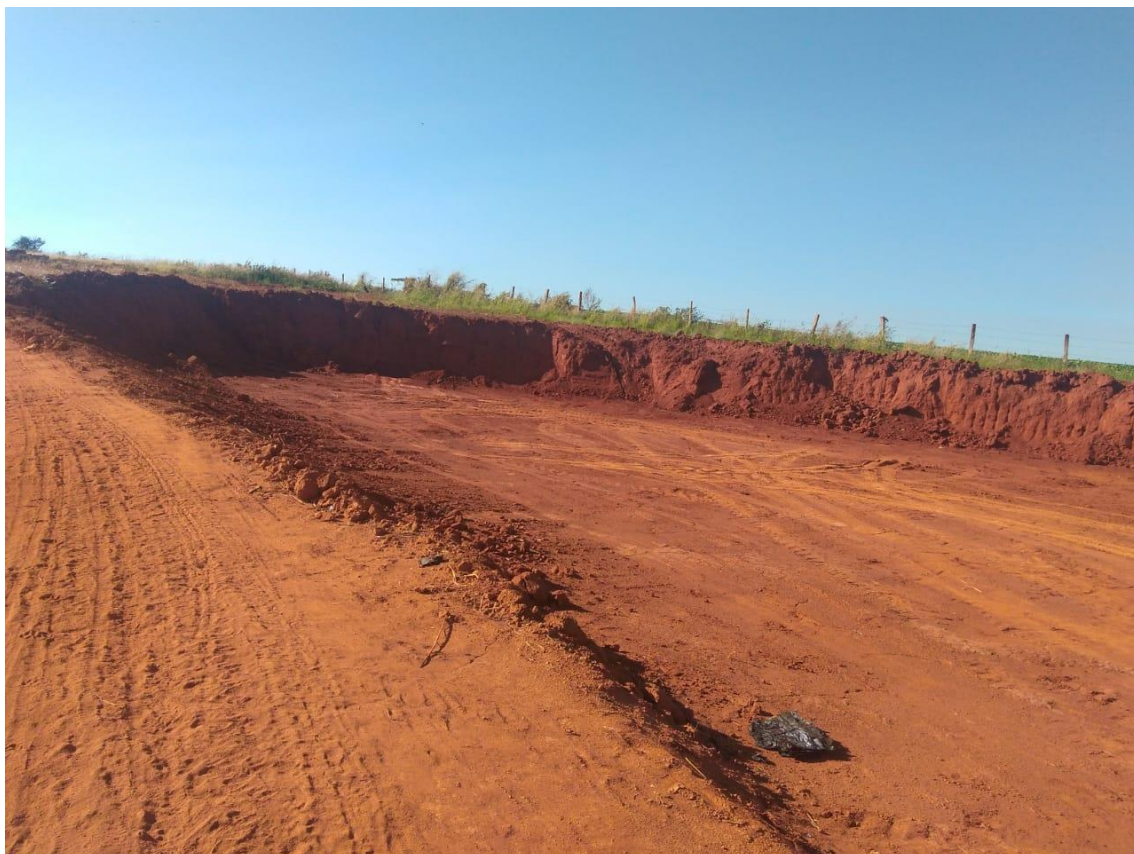
Figura 33: Área a ser utilizada para Aterro Sanitário (Fonte: do autor).
