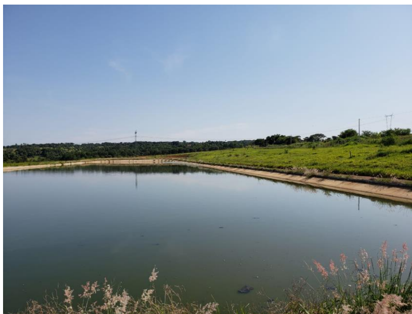
Figura 30: Estação de tratamento de esgoto (primeira lagoa). (Fonte: do autor)
