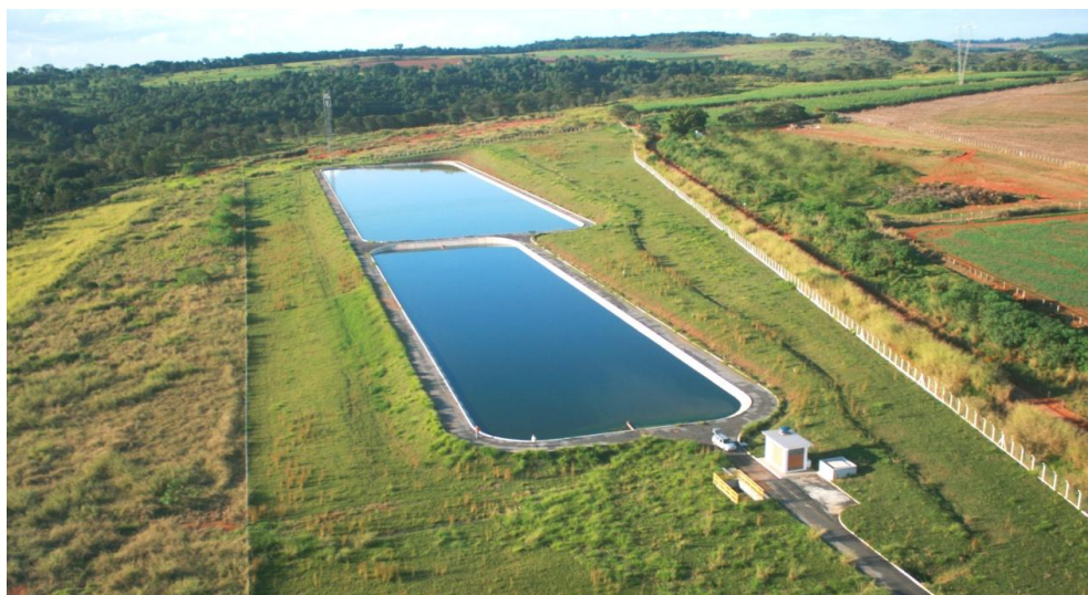
Figura 26 – Vista aérea da ETE de Itobi.
