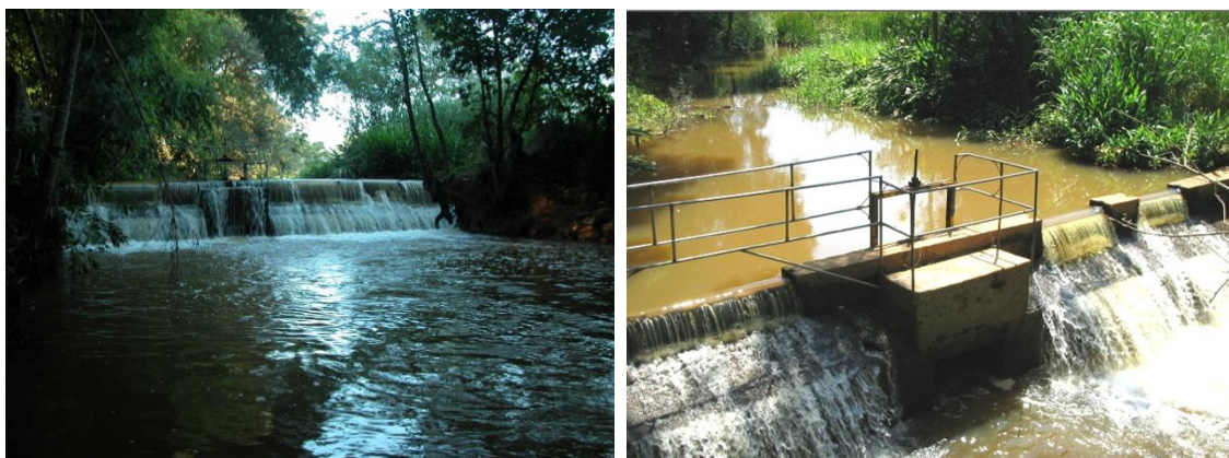
Figura 13 – Captação - Barragem de nível no Rio Doce – Itobi.
