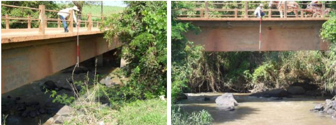
Figura 58 – Vista da Travessia TR-04.
