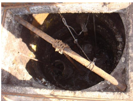
Figura 22 – EEE-01 e conjunto moto bomba submersível.
