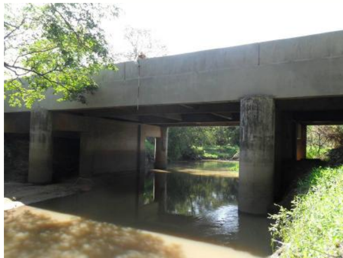
Figura 49 – Vista da Travessia TR-01.
