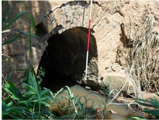
Figura 65 – Vista a montante e jusante da Travessia TR-09.
