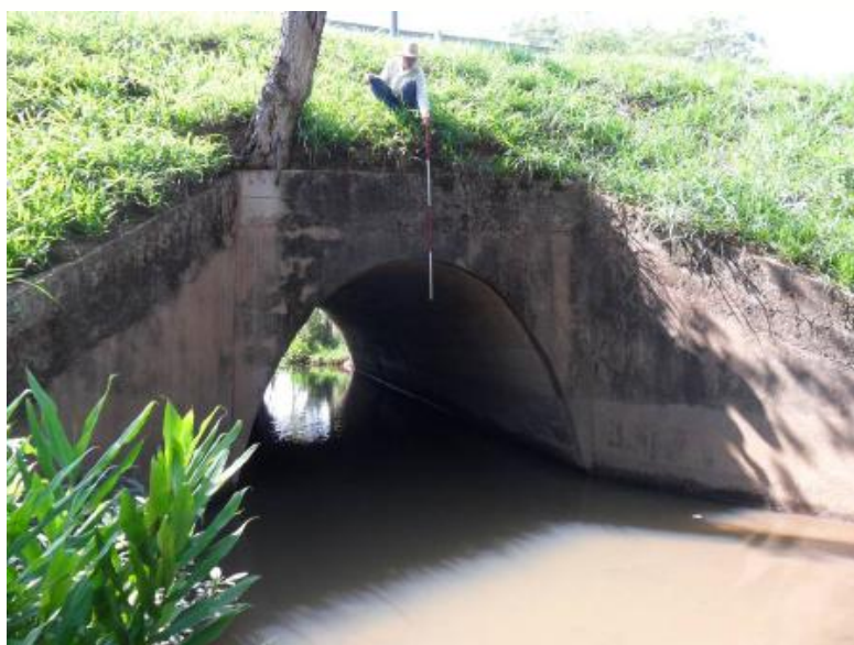
Figura 52 – Vista da Travessia TR-02.
