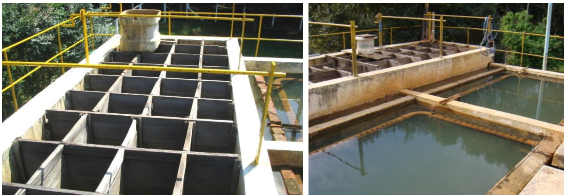
Figura 16 – Filtros com fluxo descendente e caixa de correção de pH.
