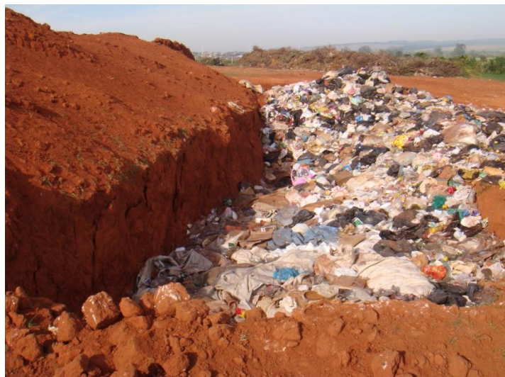
Figura 74 – Disposição dos resíduos no aterro em valas de Itobi.
