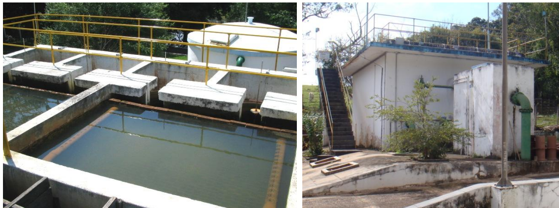
Figura 16 – Filtros com fluxo descendente e caixa de correção de pH.
