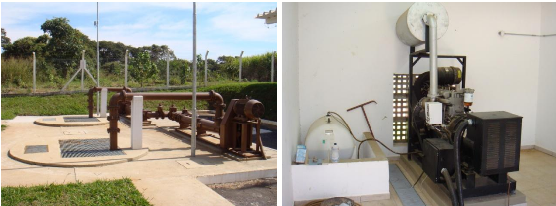
Figura 25 – Conjunto de bombas e gerador.
