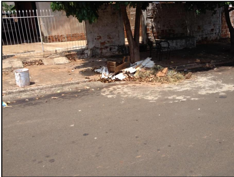
Figura 55– Acondicionamento dos RCC em frente às residências.
