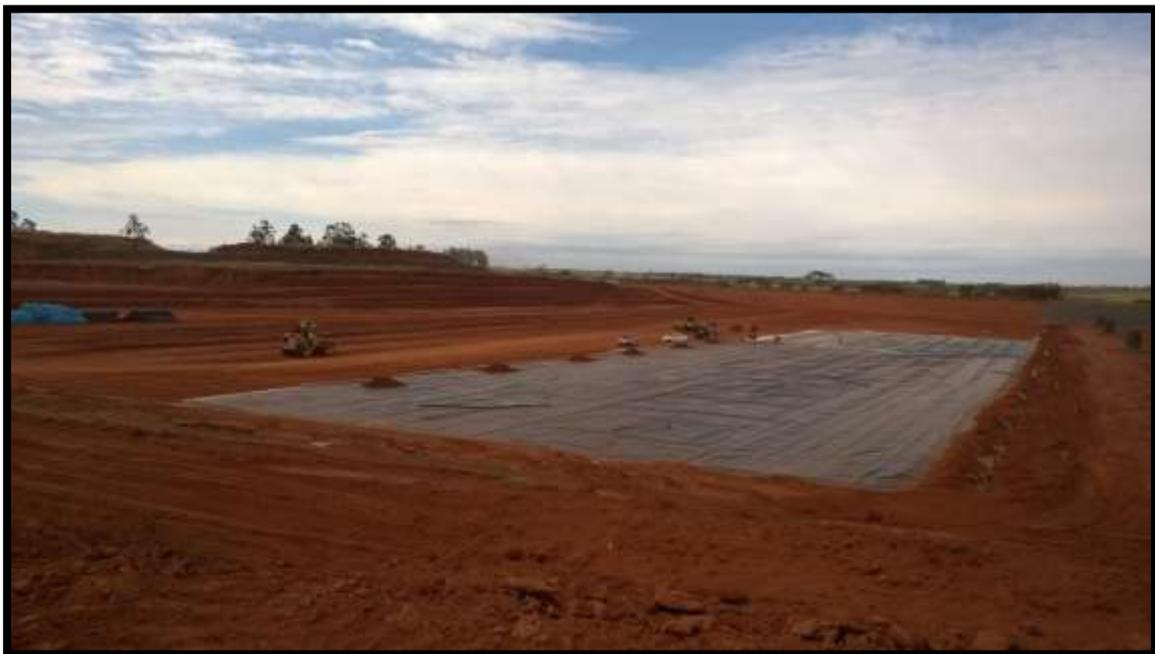
Figura 50 - Preparação de uma vala, com manta impermeabilizante
