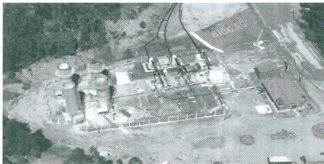
Figura 19 - Sistema de aproveitamento do biogás do aterro sanitário classe II da Essencis (CTVA Caieiras). Fonte: Essencis.
