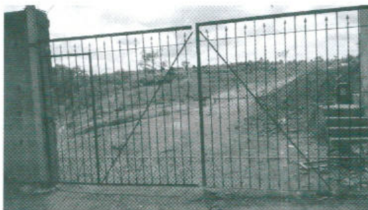
Figura 23 - Antigo lixão desativado, que é de propriedade particular. A área encontra-se sem resíduos aparentes e está murada.
