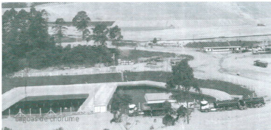
Figura 18 - Lagoas de chorume do aterro sanitário classe II da Essencis (CTVA Caieiras). Fonte: Essencis.
