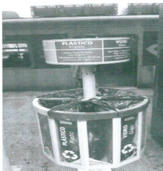
Figura 22 - Lixeira da estação de trem.
