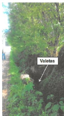
Foto 3.33 - Valetas executadas para melhorar o escoamento da água
