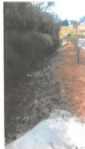
Foto 3.13 - Valeta utilizada para escoamento da água
