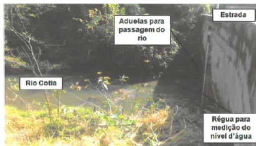
Foto 3.28 - Aduelas e régua para medição do nível d'água
