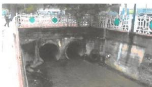
Foto 3.52 - Estrangulamento da seção do ribeirão - Manilhas de concreto
