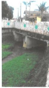
Foto 3.53 - Estrangulamento da seção do ribeirão - Aduelas de concreto
