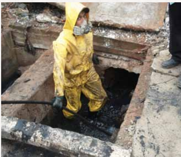
FOTO 13 Serviço de hidrojateamento e sucção dos dejetos
