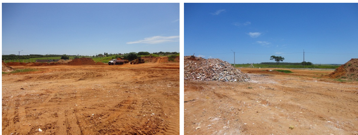
Figura 18. Fotos da área da Prefeitura para armazenamento temporário de RCC
