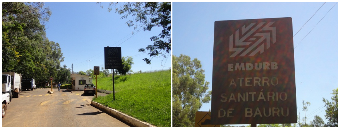
Figura 9. Fotos da entrada do Aterro Sanitário
