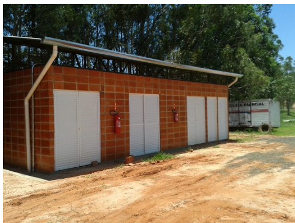
Figura 16. Câmara fria para armazenamento temporário de RSS
