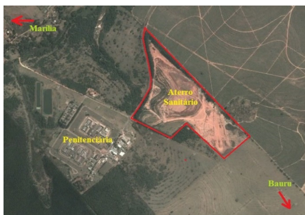
Figura 8. Imagem aérea da Área do Aterro Sanitário municipal
