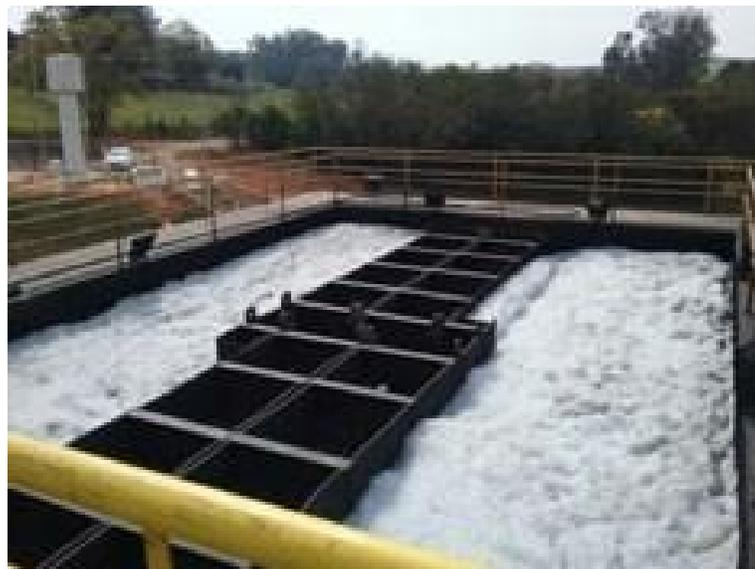
Foto 53: Vista superficial do reator aeróbico e do decantador central
