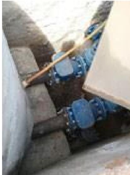
Foto 78: Válvulas de retenção
