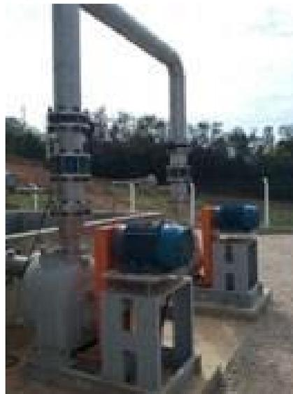
Foto 49: Bombas de recalque do esgoto para o UASB
