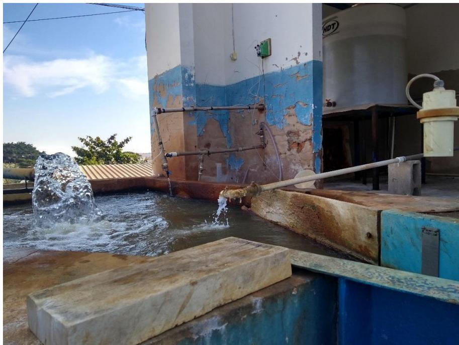
Foto 4: Caixa de chegada de água bruta e dosagem de coagulante. Fonte:
