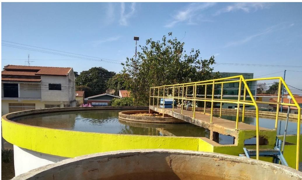
Foto 5: Floculador Central e Tanque de Decantação periférico
