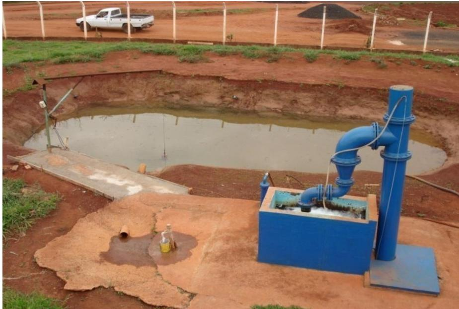
Foto 16: Reaproveitamento de água de retrolavagem.
