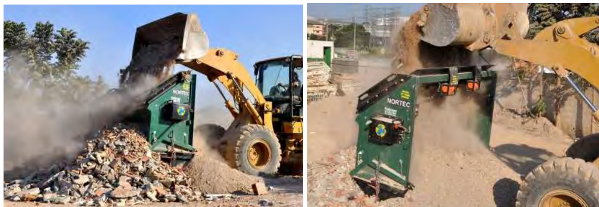
Figura 12-8. Exemplos de tecnologia de beneficiamento de RCC de baixo custo – sistema de peneiramento sem britagem.
