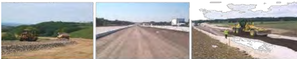
Figura 12-9. Exemplos de utilização de RCC beneficiado para fabricação de artefatos da construção civil e pavimentação.
