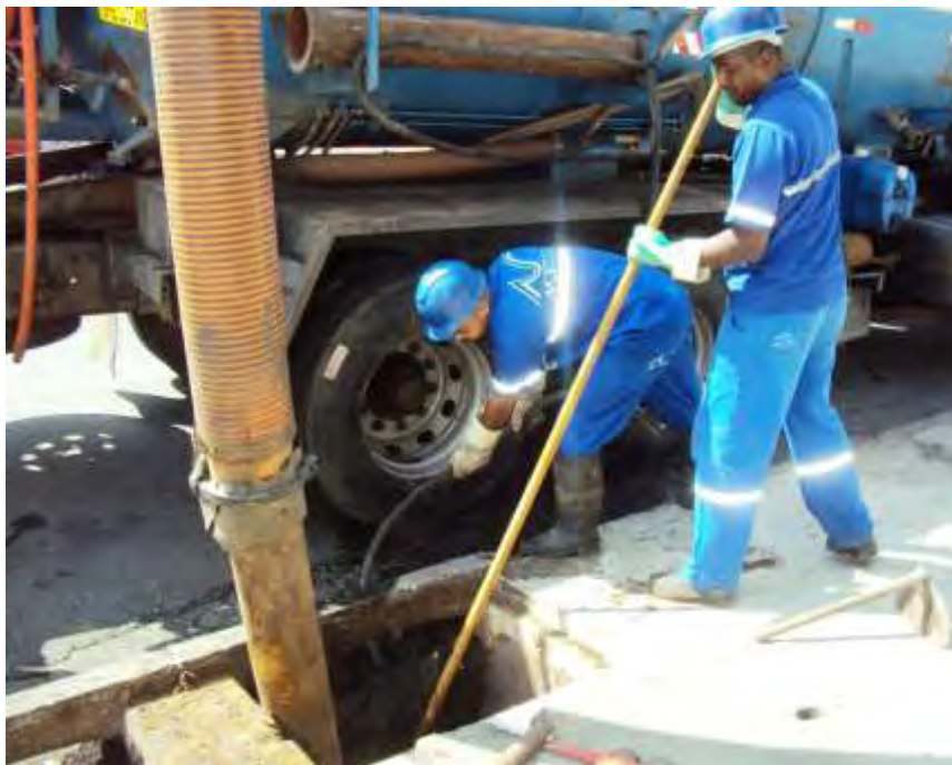
Foto 8-28. Imagem ilustrativa do processo de limpeza de boca-de-lobo no município de São Paulo.
