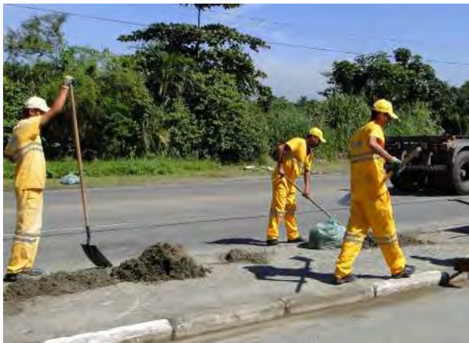
Foto 8-30. Imagem ilustrativa do processo de raspagem das guias na cidade do Guarujá.
