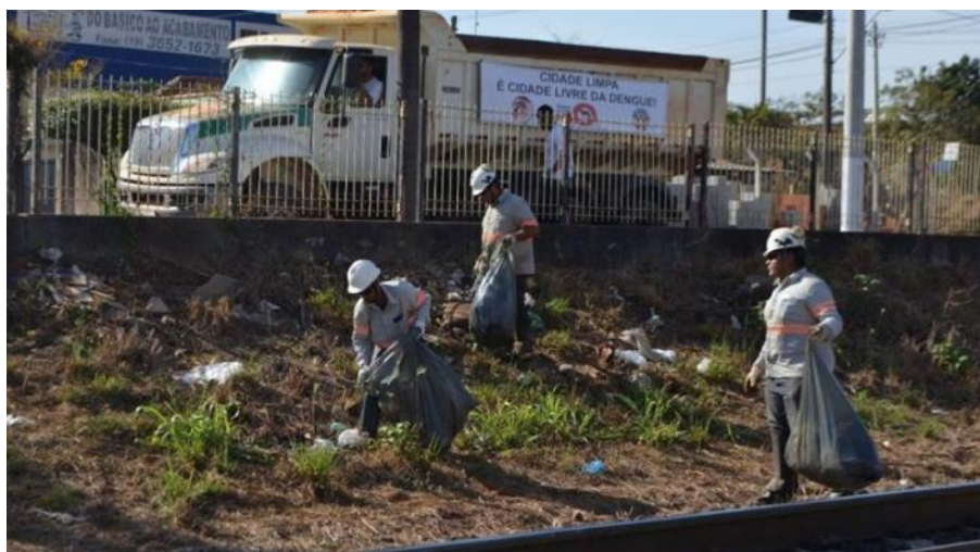
Figura 18: Limpeza em torno da linha férrea.
