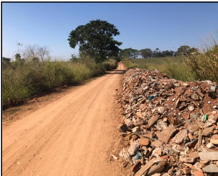
Figura 25 - Utilização de RCC para melhoria de estradas vicinais.
