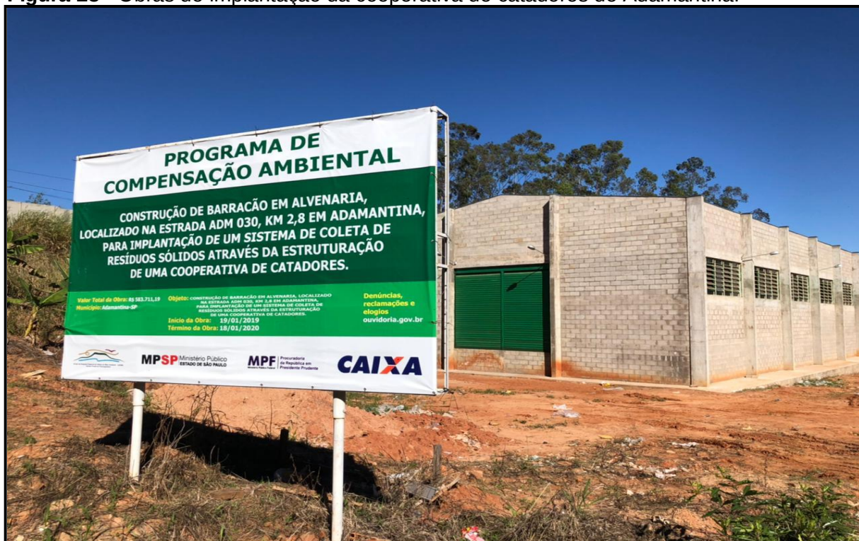
Figura 23 - Obras de implantação da cooperativa de catadores de Adamantina.
