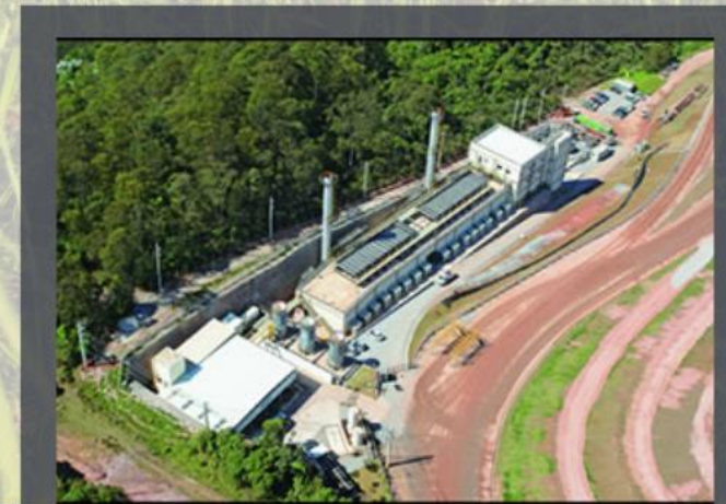
SÃO JOÃO Energia Elétrica 23 MW
